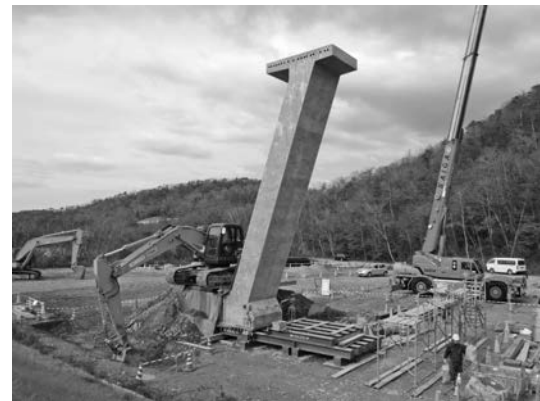
写真一11 実物大コンクリート打設試験
