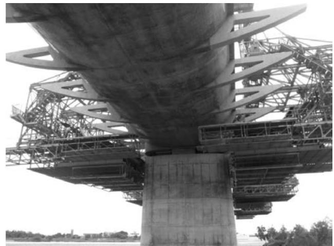
写真-5 下部フレーム スライド状況
