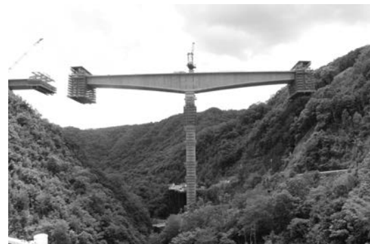
写真一12 P2橋脚からの張出し施工
