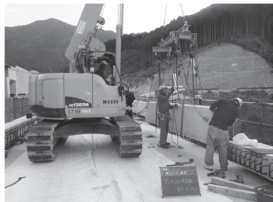
写真-5 プレキャスト部材据付け状況
