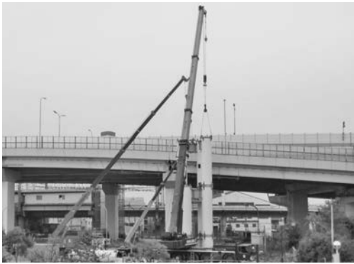
写真一五 柱部架設
