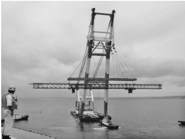
写真—10 PC部架設桁の移設
