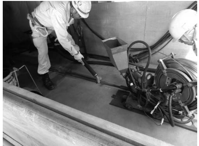
写真—12 風防設備内 継手溶接状況
