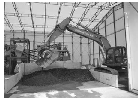
写真-8 焼却主灰破碎状況
