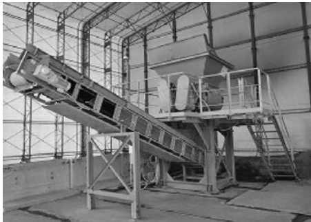
写真一10 焼却灰混合施設
