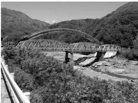
写真—5 現橋早川橋（手前）と架設中の新橋
