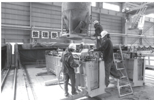
写真-3 プレキャスト部材製作状況
