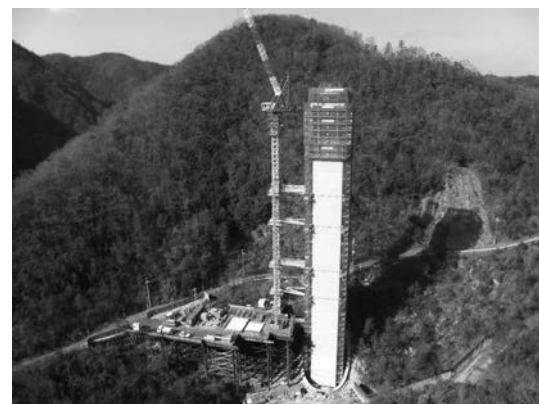
写真—4 セルフクライミングフォームによる橋脚施工
