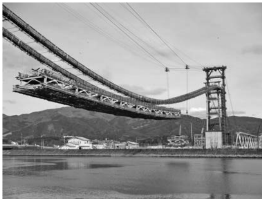
写真—4 架設状況（ケーブルクレーン使用）
