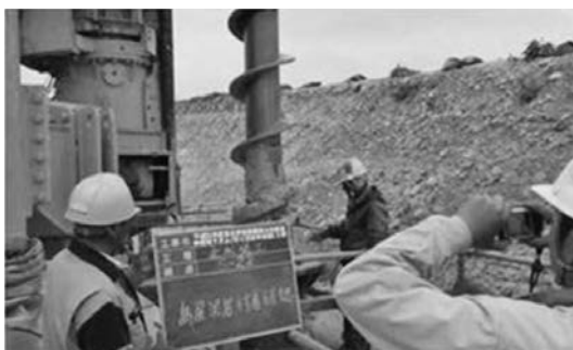
写真-2 不透水層土塊の付着確認状況
