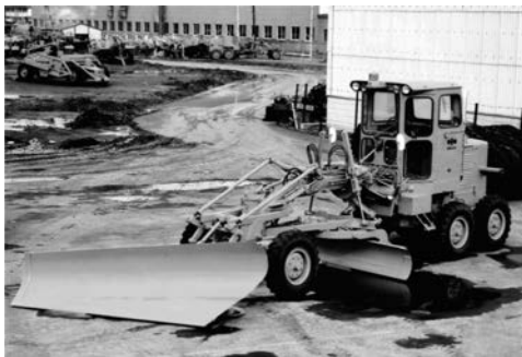
写真 4-32 3.1 m 級 110PS GD31RC-3A (株)小松製作所 昭和 51 年
