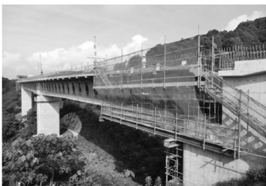
写真一 7 A1 側径間部の施工状況
