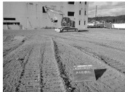
写真—23 駐車場路盤整備状況
