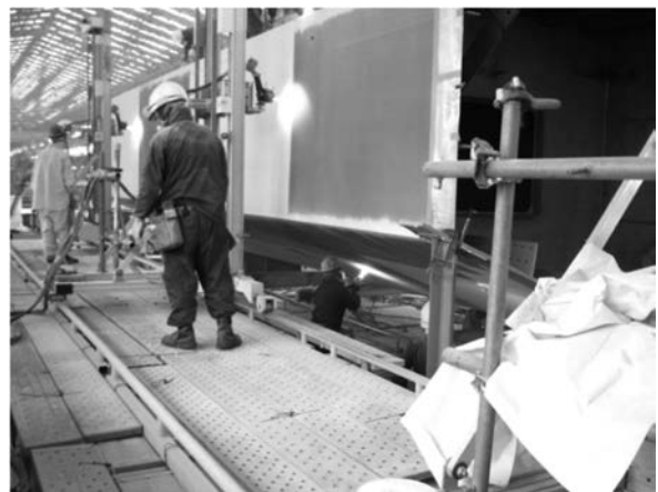
写真-4 工場溶射状況
