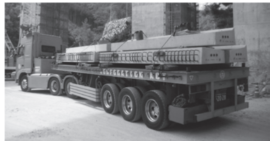
写真-4 プレキャスト部材搬入状況
