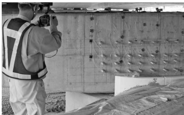
写真—4 カメラ計測状況
