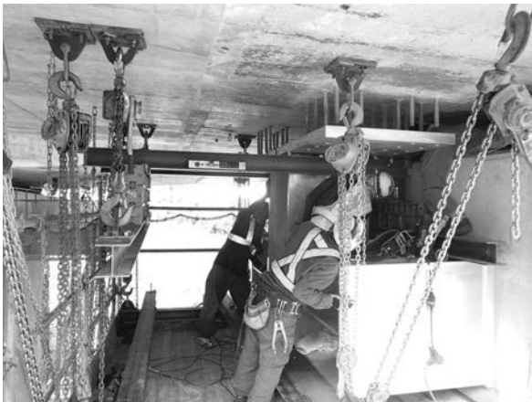
写真一六 ブラケット施工状況
