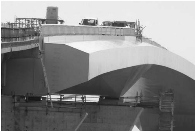
写真-2 桁外面状況
