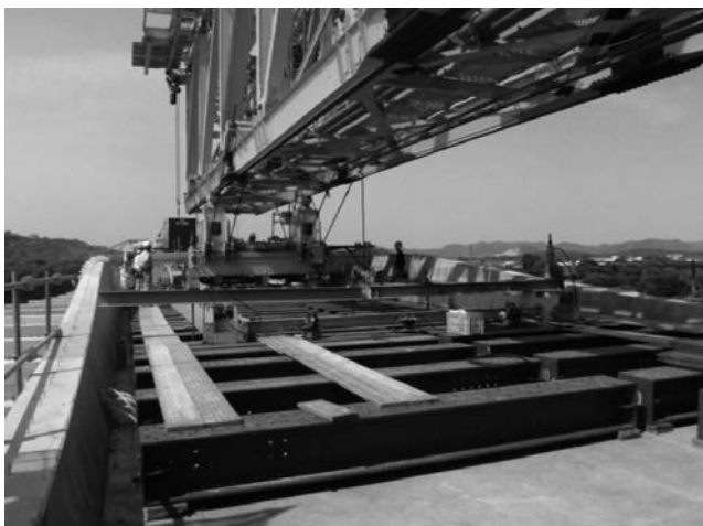
写真-4 荷重分散梁 設置状況
