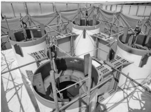
写真一六 横つなぎ材の接合
