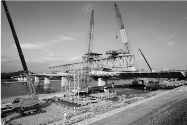
写真一六 架設桁・型枠装置 解体全景
