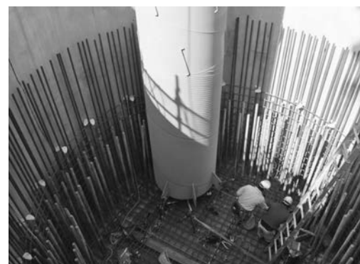
写真一4 基礎鋼管・基礎頂版の接合
