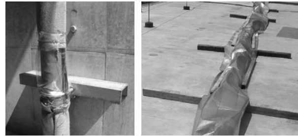
鉛直配管 水平配管 写真一10 コンクリートの配管養生
