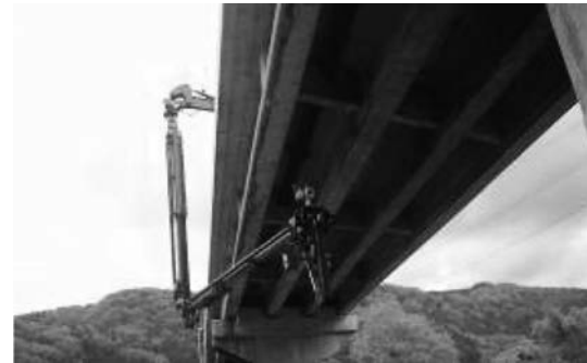
写真—4 作業状況
