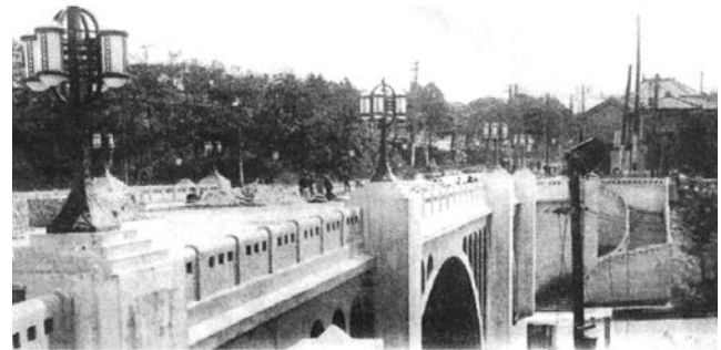
写真—2 開橋当時の写真（左奥が飛鳥山公園）
