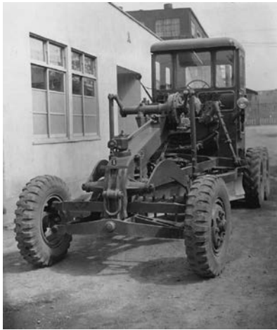
写真 4-8 3.1 m 級 初期型 80PS 後期型 105PS MGⅢ 鋼製キャブ付き 三菱日本重工業(株) (注4) 昭和 27 年
