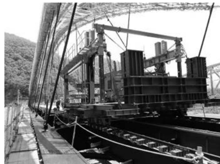
写真一4 施工中のPC床版架設機④
