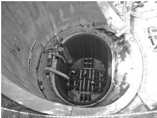
写真-1 小判形断面の大口径深礎
