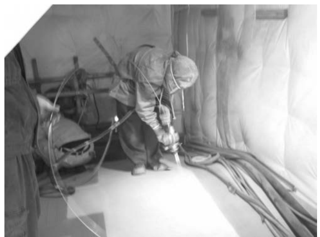
写真—13 風防設備内 Al-Mg 溶射状況
