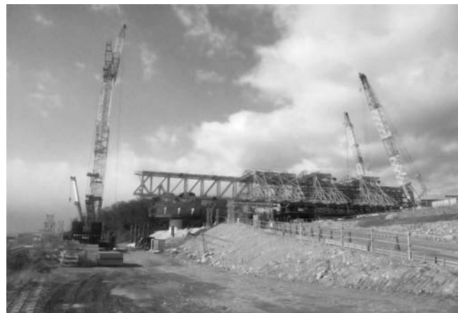
写真一2 架設桁・型枠装置 組立全景
