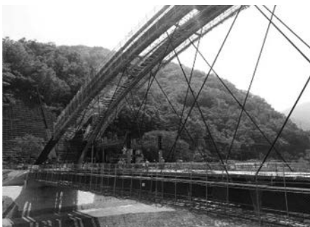
写真一1 施工中のPC床版架設機①
