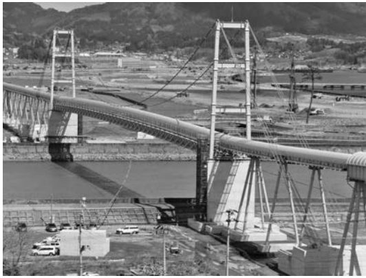
写真一六 ベルトコンベヤ用吊橋「希望のかけ橋」(土砂搬送中)
