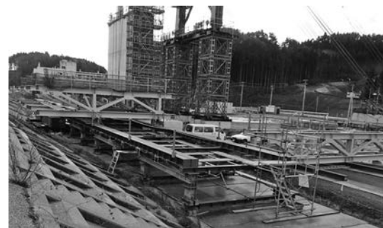
写真—5 地組立用架台
