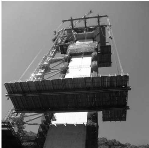
写真一9 下段作業台の一括架設
