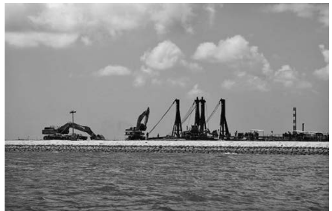
写真-7 現場では各種の陸上建設機械が稼働
