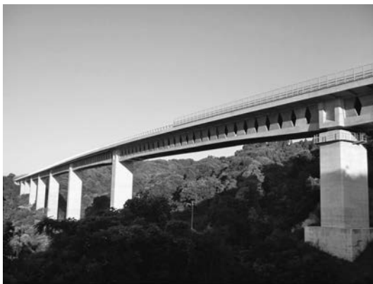
写真—8 完成写真
