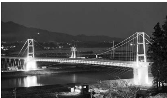
写真一八 ベルトコンベヤ用吊橋「希望のかけ橋」 (夜間メンテナンス作業時：LED 照明)
