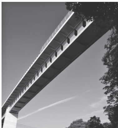
写真一 1 完成写真 (近景)
