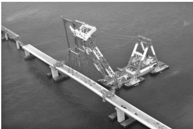
写真—11 中央径間の架設
