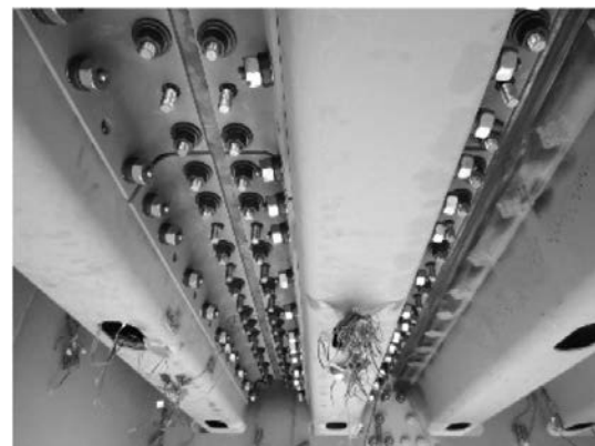
写真一1 あて板の取付状況
