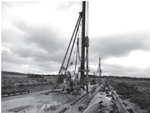
写真-1 SMW工法による止水壁構築状況
