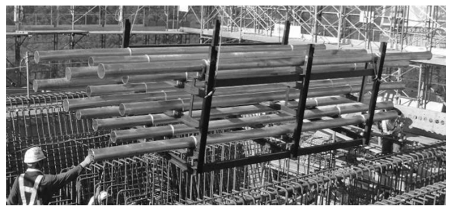
写真—8 偏向管一括架設
