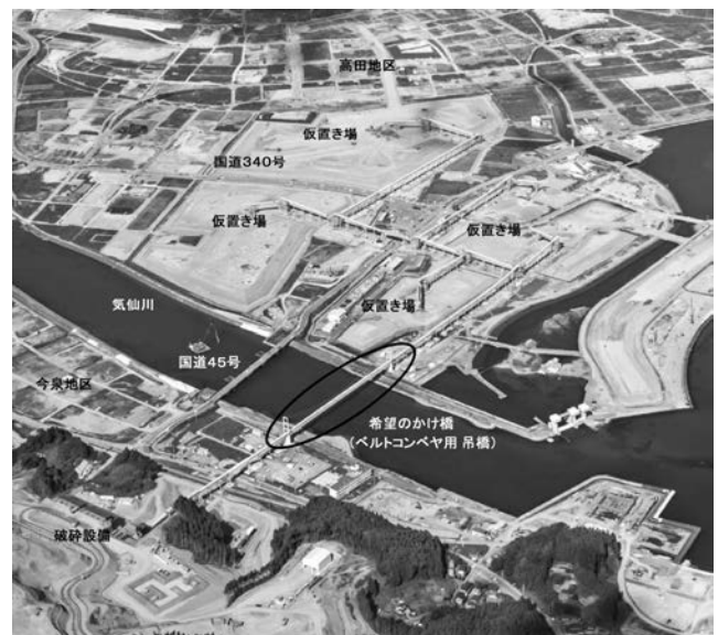
写真—1 ベルトコンベヤ設備全景
