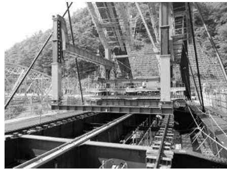
写真一3 施工中のPC床版架設機③
