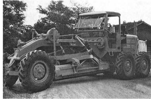
写真 4-16 3.7 m 級 100 PS HA58 日本開発機製造(株) (注15) 昭和 33 年 2)
