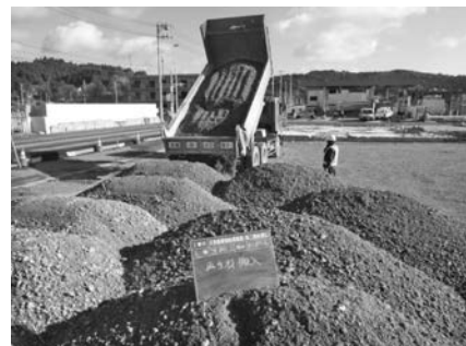
写真—22 造粒再生碎石搬入状況
