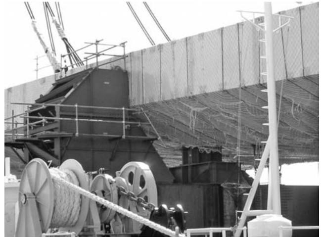
写真—7 横移動制限装置
