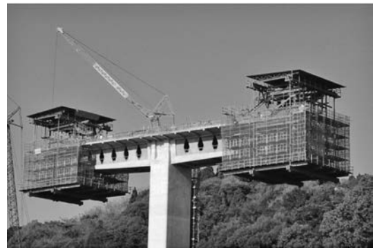
写真—5 張出し架設状況
