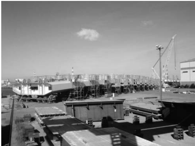
写真—5 地組立て、ヤード溶接
