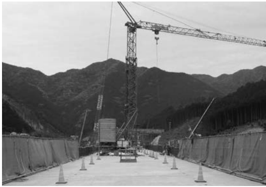
写真一 ポテインクレーン
