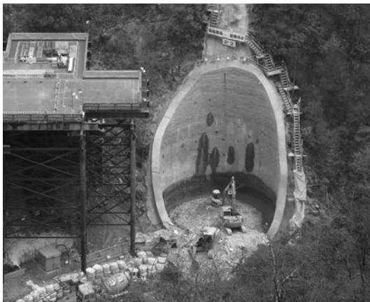
写真—2 竹割り型土留め工法
