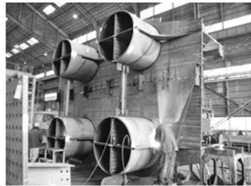
写真一3 剛結部 (鋼管と鋼桁下フランジの溶接)
