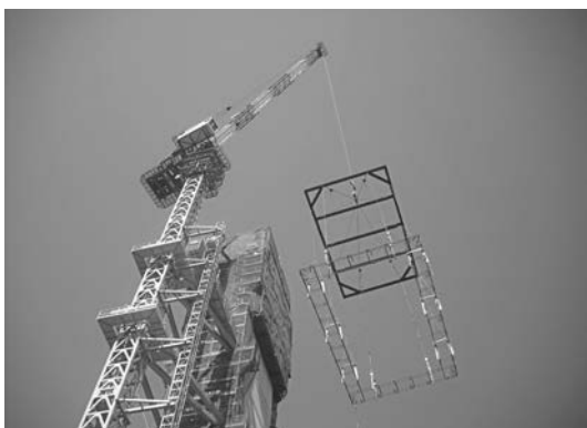
写真—6 鉄筋一括吊込み
