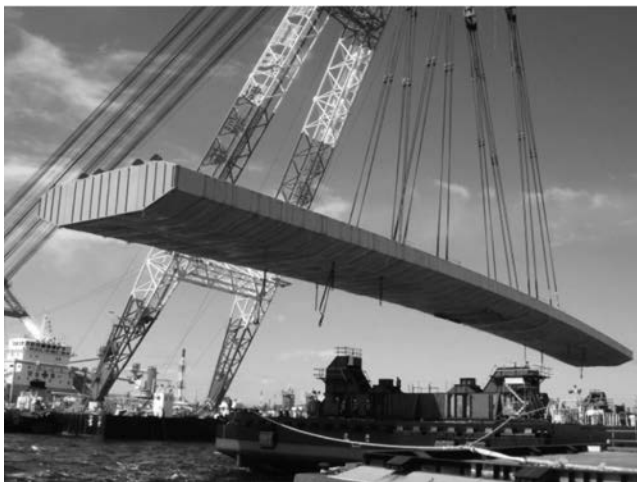
写真—6 工場ヤードからの浜出し
