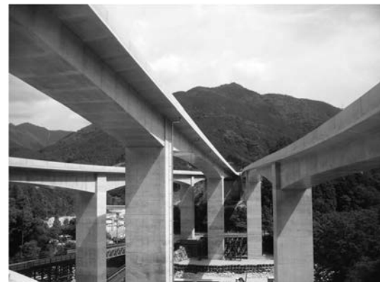
写真-6 完成写真
