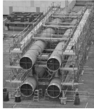
写真一2 仮組立状況
