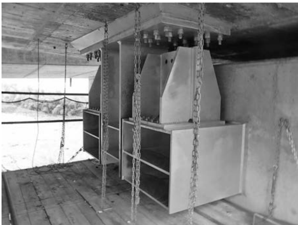
写真一七 完成状況
