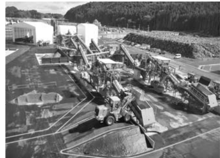
写真一13 造粒前処理施設全景
