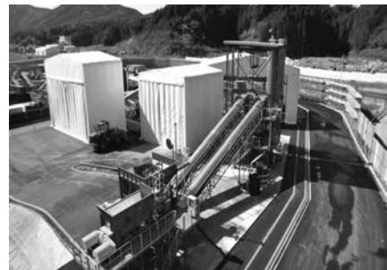
写真一14 造粒固化処理施設全景
