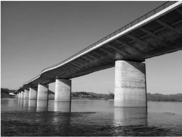
写真一七 完成全景
