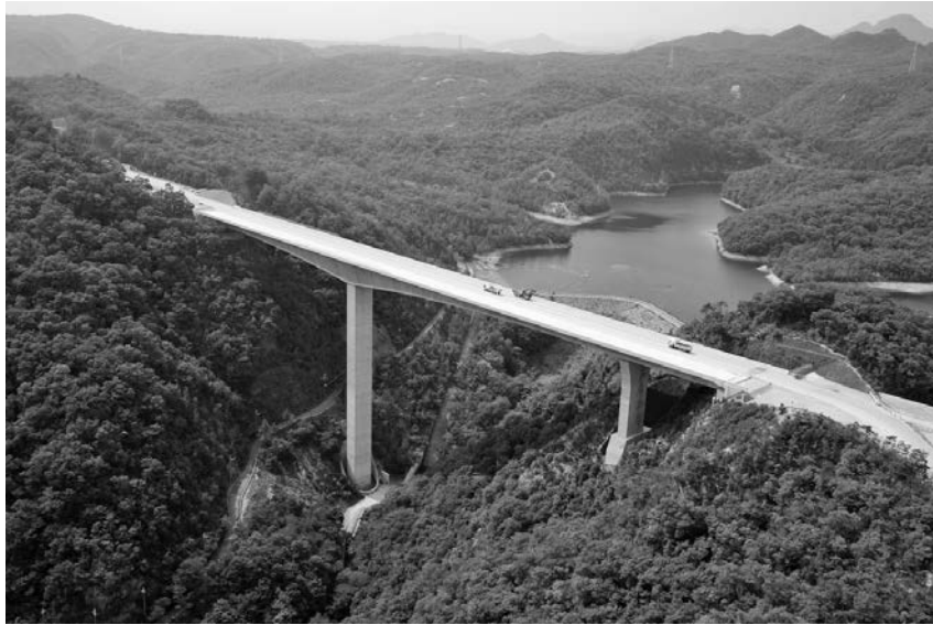
写真—13 川下川橋全景
