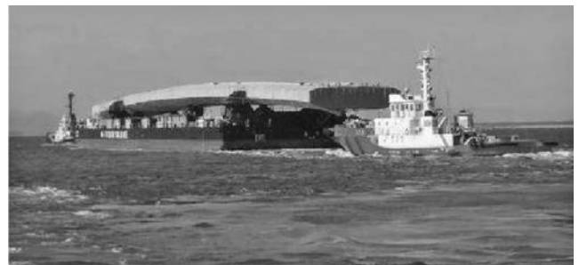
写真—8 大ブロック海上輸送状況
