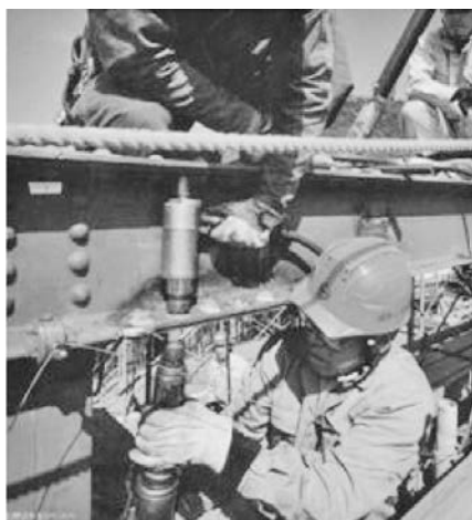
写真一5 リベット締付け状況
