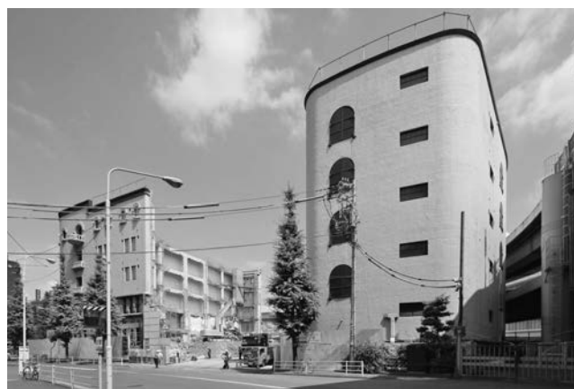
写真—4 既存建物中央部解体完了状況 (撮影：(株)カット写真事務所)
