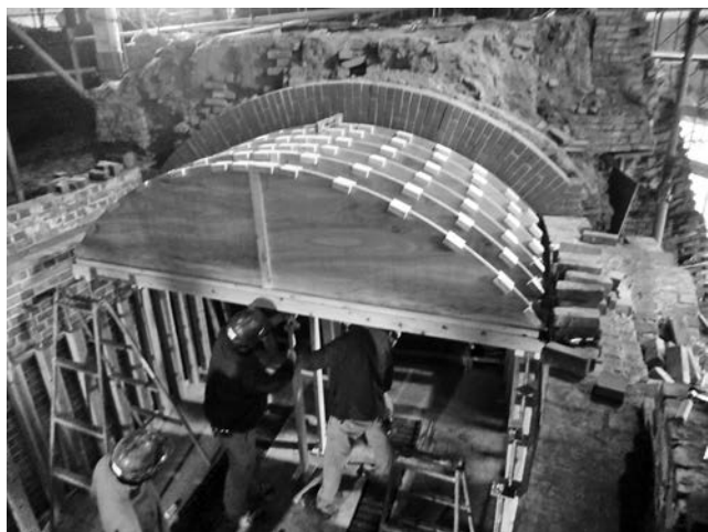
写真—16 柄の取り付けと調整
