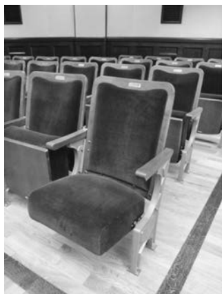
写真—8 接合部など補強し無垢材で復元した座席
