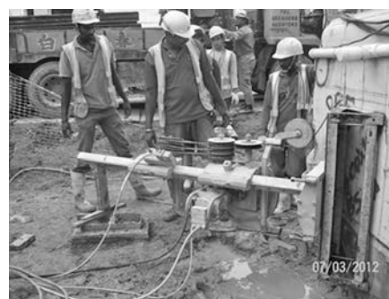
写真—4 ワイヤ・ソーと固定用治具
