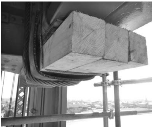
写真—3 鉄骨部の養生状況
