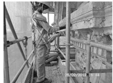
写真—25 既存塗装除去
