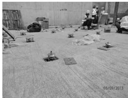
写真—24 防振装置の設置
