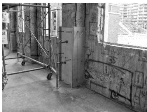
写真—15 柱グラウト打設
