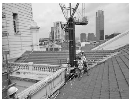
写真—21 鉄骨建方状況
