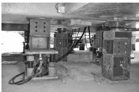
写真一 8 ジャッキアップ状況
