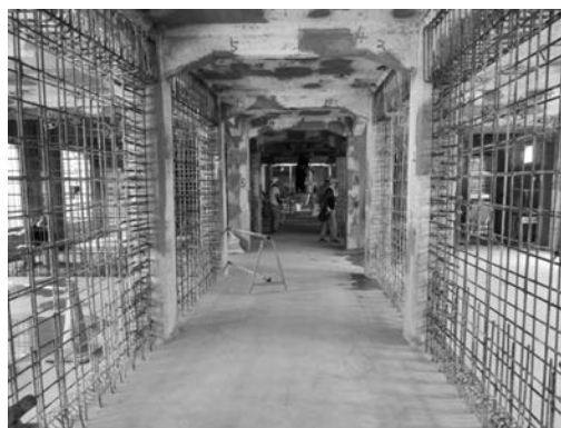
写真一5 耐震壁の増設
