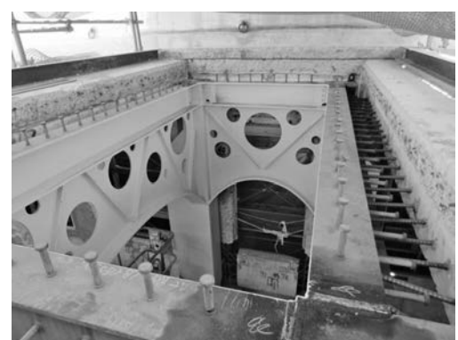
写真－10 接合部状況 1
