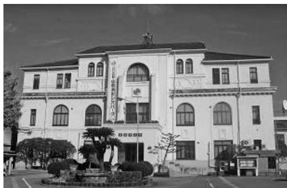
写真―2 昭和27年に建築当時の雰囲気を残して3階部分が増築された曳家前の旧本庁舎（豊岡市ホームページより）
