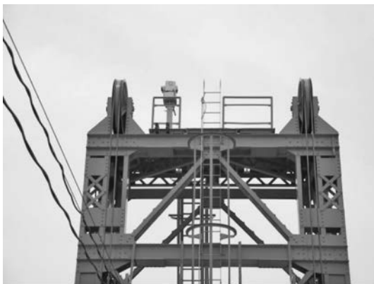
写真—18 修理完了②
