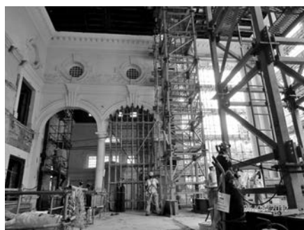
写真—17 アーチ開口部の補強状況
