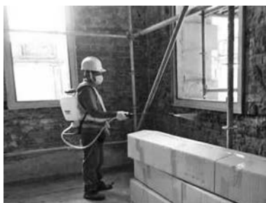
写真—26 耐塩害処理剤塗布
