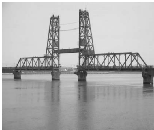
写真—1 筑後川昇開橋全景
