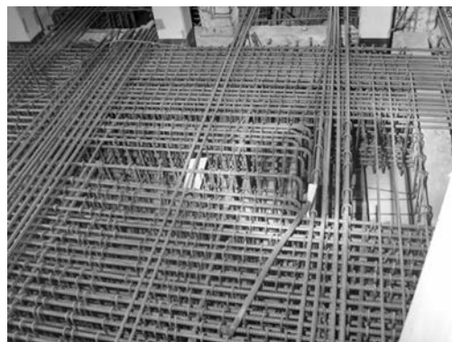
写真一4 基礎梁の補強
