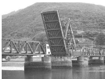
写真—1 長浜大橋開閉状況
