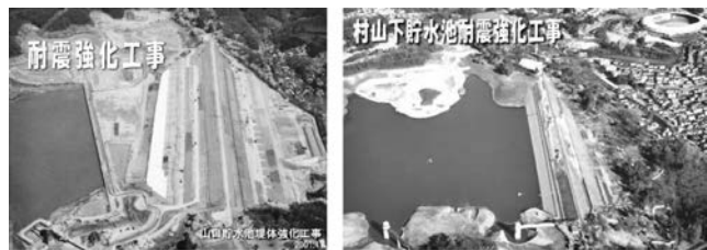
写真—17 耐震強化工事時の山口貯水池と村山貯水池
