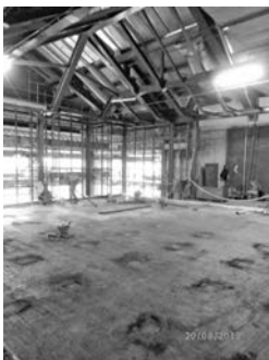
写真—23 コンクリート打設後
