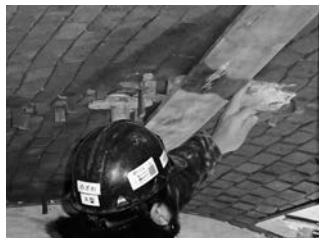
写真—25 煉瓦楔の打ち込み
