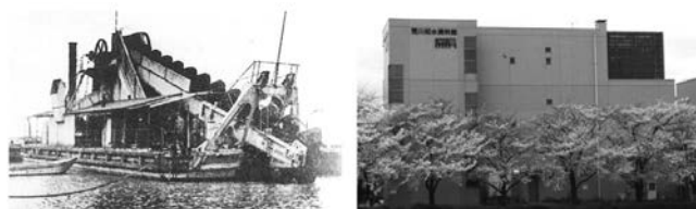
写真一11 浚渫船
