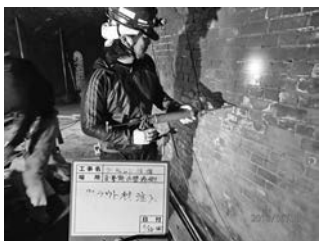
写真—33 グラウト材注入
