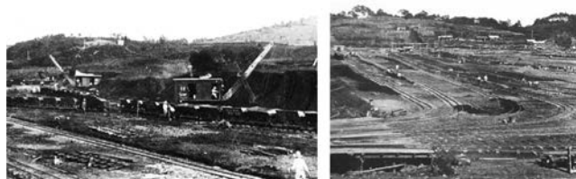
写真一16 山口調整池の土取場と堤体敷の線路網
