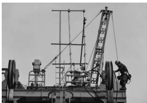
写真—9 ジンポールデリック設置完了
