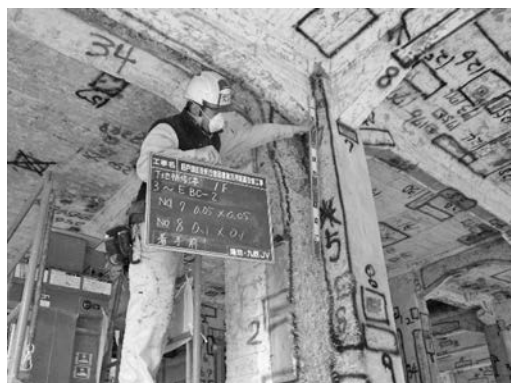
写真—13 既存躯体調査状況①
