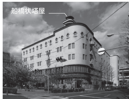
写真—3 2011(平成23)年解体着手前の 「江戸橋倉庫ビル」
