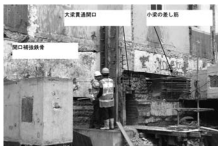
写真—5 施工状況
