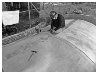
写真—19 段差の削り
