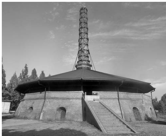
写真—36 修理工事後
