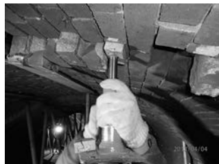
写真—26 油圧ジャッキによる押し上げ
