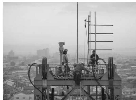
写真—6 電動ウインチ設置状況
