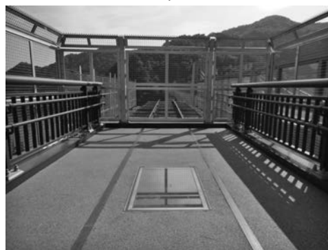
写真一7 鉄道橋時代(上)と先端の鉄橋保存区間及び床面のガラス窓(下)
