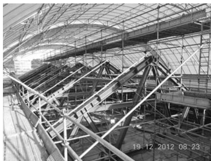
写真—15 新設屋根鉄骨施工中
