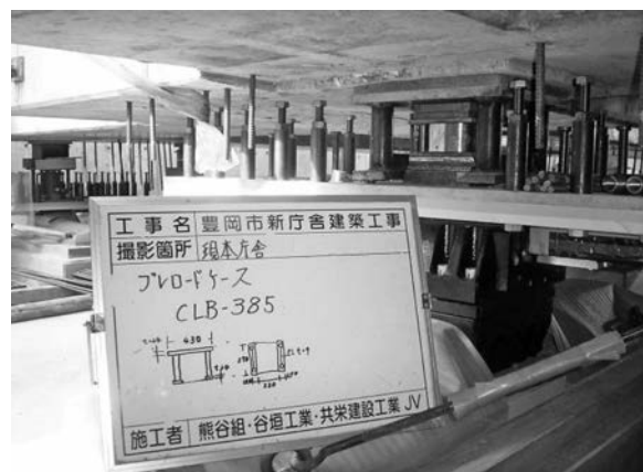
写真—13 プレロードケース設置状況
