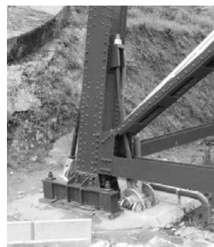
図一3 写真一5 PCケーブルによる橋脚基部補強
