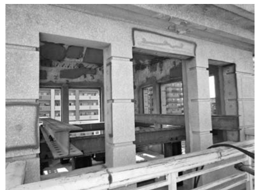
写真－9 塔屋鉄骨取り込み架台
