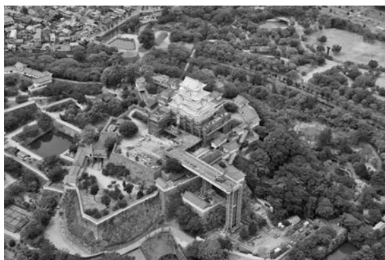
写真-1 現場全景(素屋根解体状況)
