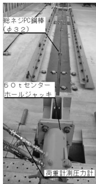
写真-6 ジャッキ設置状況
