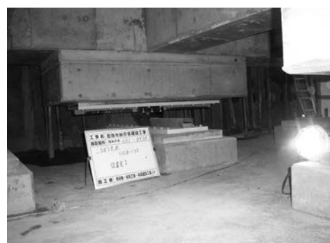
写真—14 グラウト注入の前
