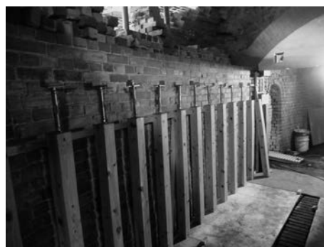
写真—15 350mm 間隔の木柱
