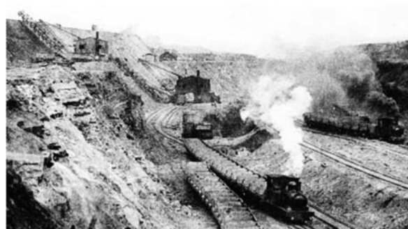
写真-6 山間部掘削のエキスカベータと土工機関車
