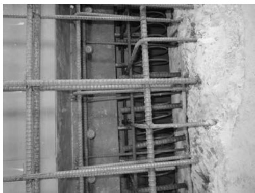
写真—11 接合部状況 2
