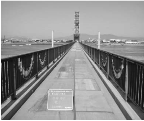
写真—2 遊歩道保護養生状況
