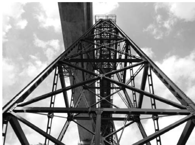
写真—9 地上からの展望施設を見上げる
