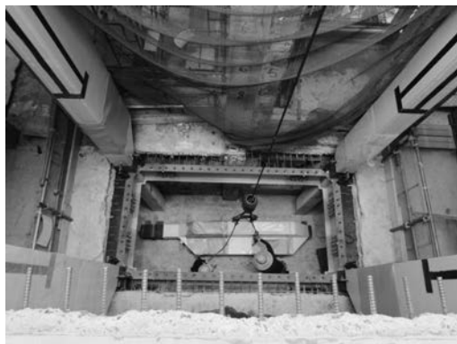
写真－7 鉄骨柱取り込み状況
