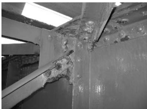
写真—4 上部工の状況
