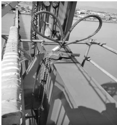
写真—4 仮吊りワイヤー設置状況
