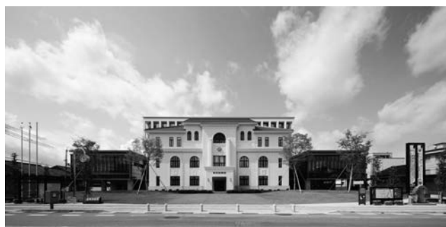
写真—3 完成写真
