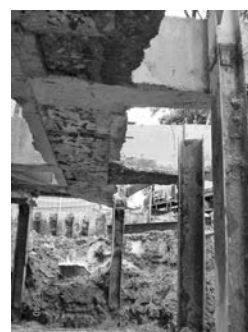
写真—10 掘削後、梁に支持された既存壁
