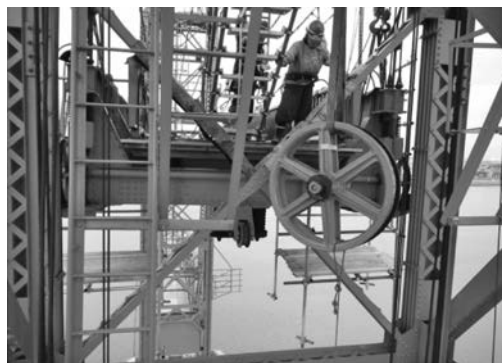
写真—12 可動桁から遊歩道上へ下ろす
