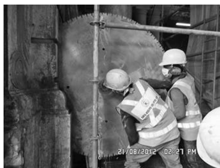
写真—18 丸ノコによる壁切断
