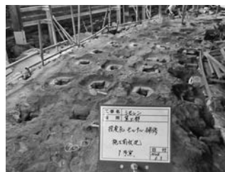
写真—28 施工前状況
