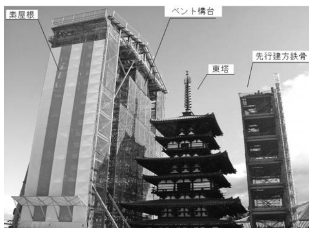
写真—2 素屋根西立面
