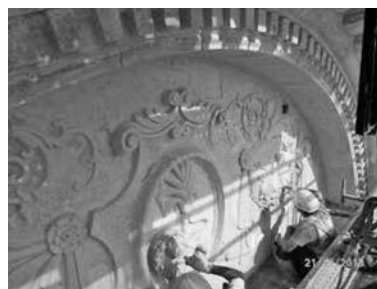
写真—27 左官仕上げ塗り状況
