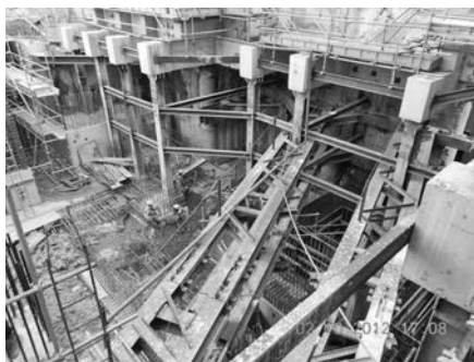
写真—11 水平つなぎの設置
