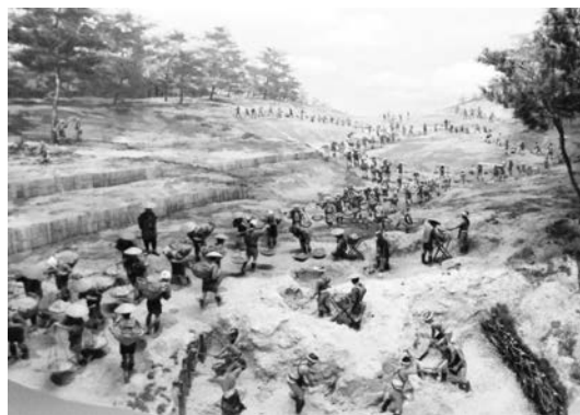
写真—9 新川放水路開削（文政3年（1820））
