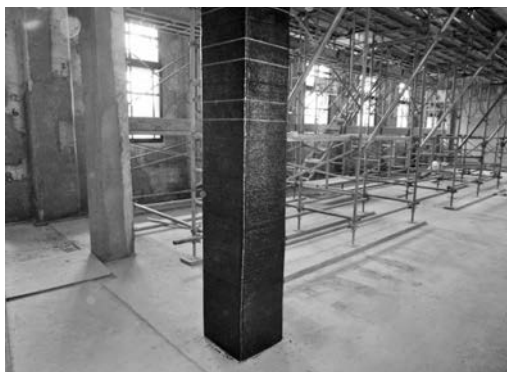
写真—16 柱炭素繊維補強
