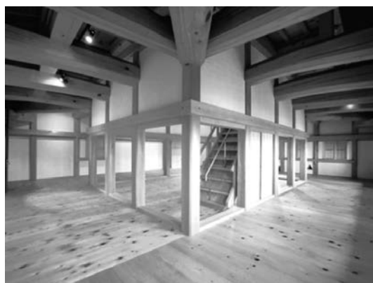
写真—2 天守1階内部
