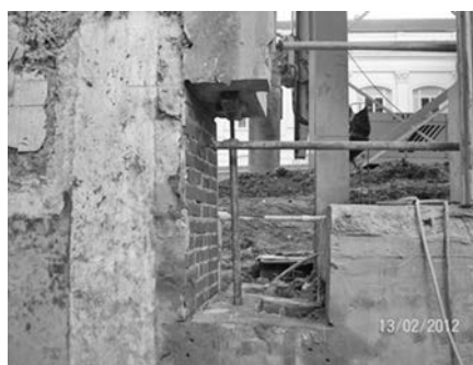
写真—3 大梁貫通開口
