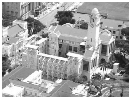
写真—1 全景写真（着工前）
