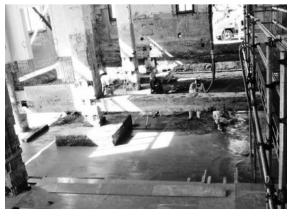
写真—4 建物内部の礎盤の構築
