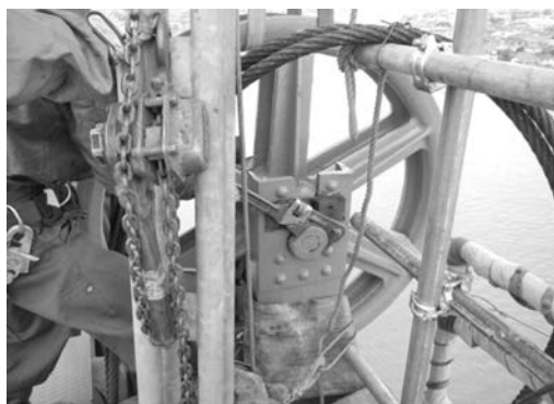
写真—10 可動桁滑車取り外し状況
