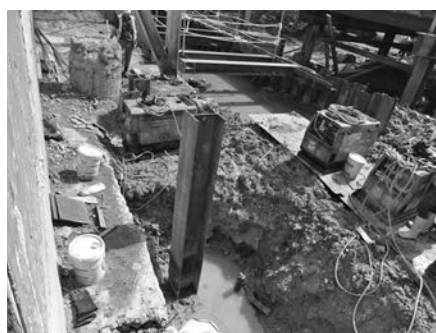
写真—2 H鋼柱（延伸後）
