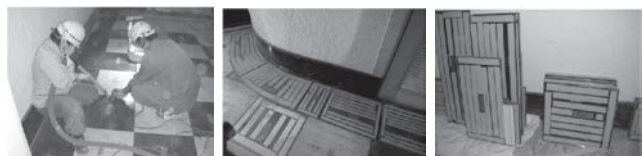
サンダーによる 床大理石の縁切り
