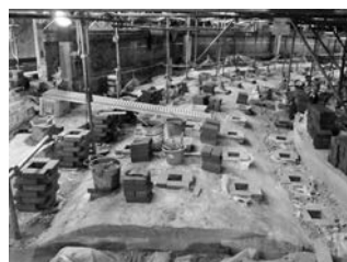
写真—30 投炭坑の煉瓦積み
