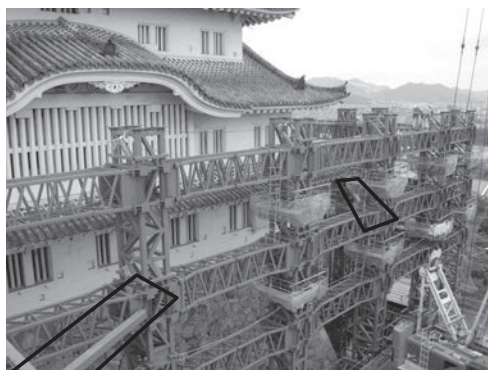
写真—4 屏風建ての建方とそれを2方向から支える仮設火打梁
