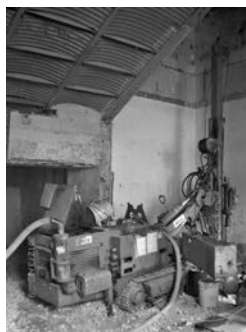
写真—12 マイクロパイル用杭打機
