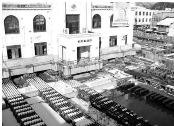
写真一 9 転動路盤設置状況
