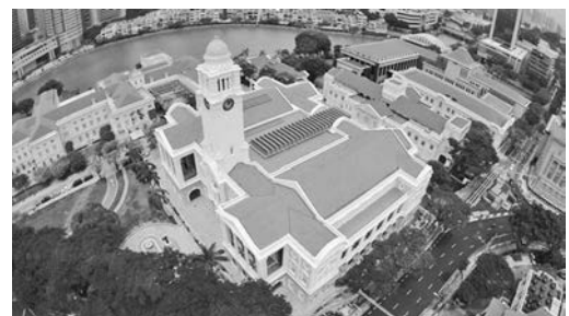
写真—28 上空より全景
