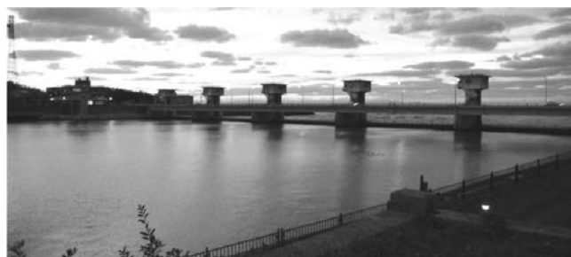
写真—8 関屋分水路と新潟大堤橋
