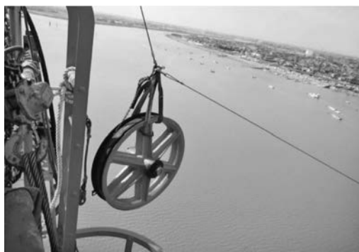
写真—11 滑車を取り外し可動桁へ移動
