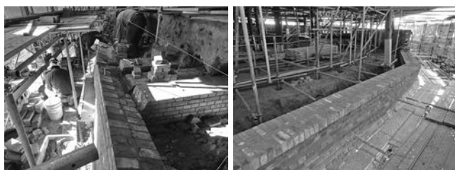
写真—12 外周壁仕上げ
