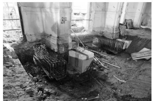
写真—13 貫通開口と梁
