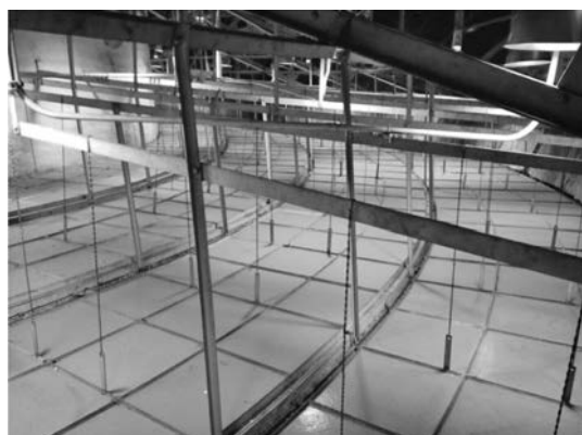
写真—3 既存天井下地の状況
