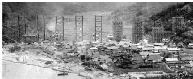
写真1 鋼トレススル式橋脚架設 4)
