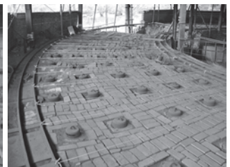
写真ー3 復旧後
