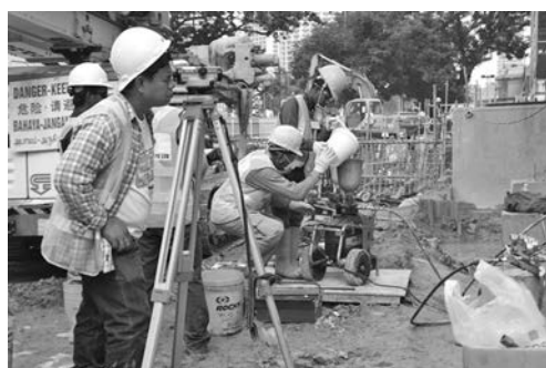
写真—8 レベル測量
