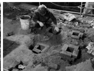
写真—29 投炭坑の修理
