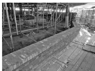
写真—13 外周蛇腹部
