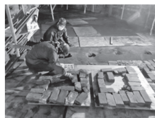
写真ー6 外部での煉瓦積み替え
