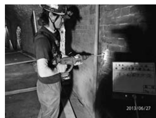
写真—32 電動ドリルで穿孔
