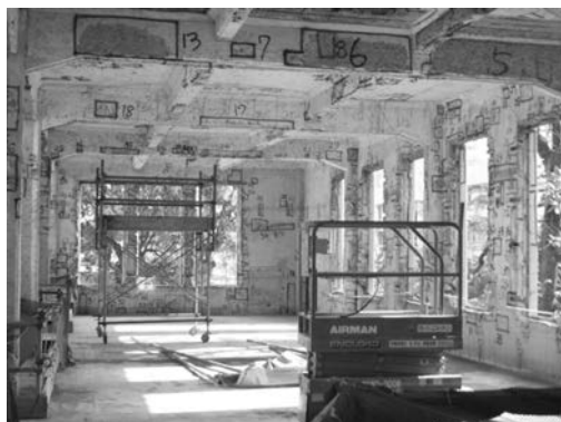
写真—14 既存躯体調査状況①
