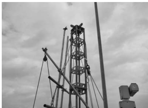
写真—8 ジンポールデリック設置状況
