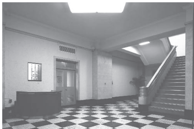
1階既存エントランスホール
