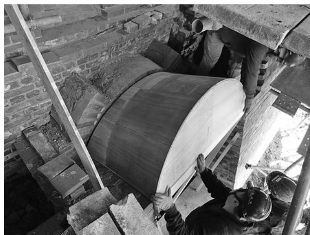
写真—14 アーチ芹杵の取り付け
