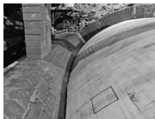
写真—22 側壁とボールドの境界
