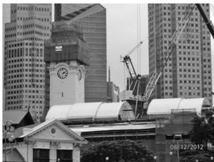
写真—14 テントを移動してのトラス建方
