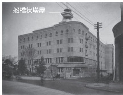
写真—2 1930(昭和5)年創建時の 「江戸橋倉庫ビル」
