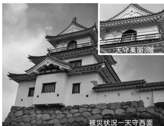
写真一4 3.11地震による被災状況
