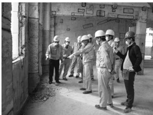
写真—12 柱の劣化状況確認
