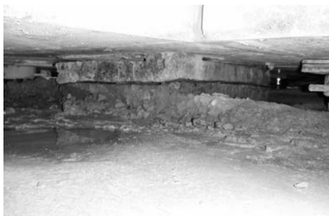
柱切断位置状況
