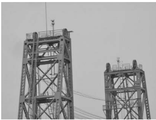
写真—17 修理完了①
