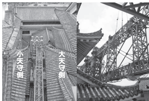
写真一3 西面（左）と北面（右）での屏風建て
