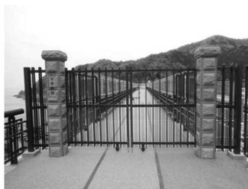
写真一8 門扉(閉鎖時)
