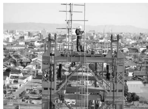
写真—7 電動ウインチ設置完了
