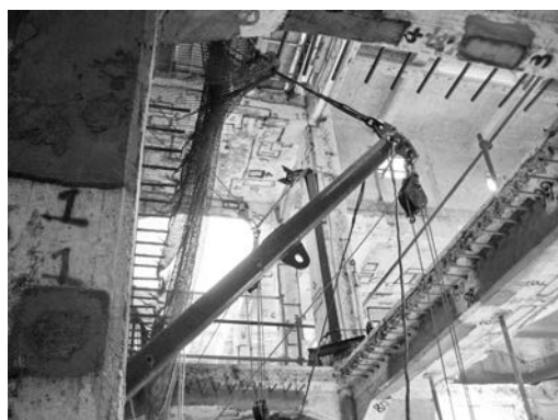
写真－8 塔屋下部鉄骨建方仮設ブーム
