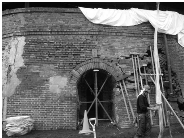
写真—9 外周壁修復
