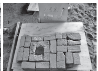
写真ー5 投炭坑口の撤去前の番付作業
