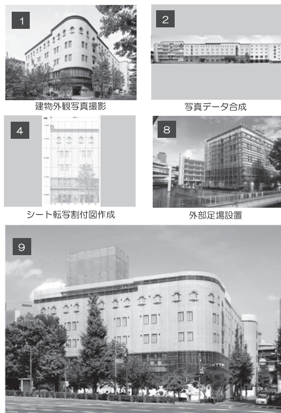
シート貼り実施状況
