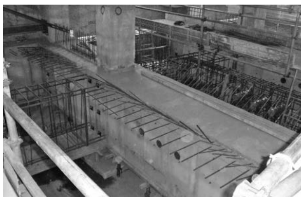
写真—5 新設地中梁の構築状況
