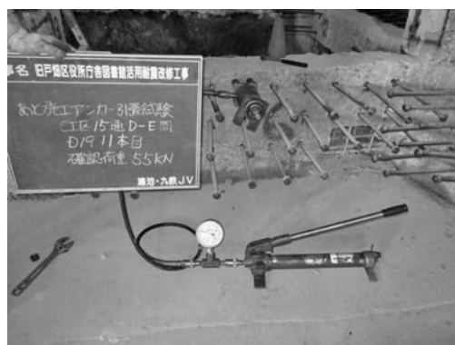
写真一6 あと施工アンカー引張試験
