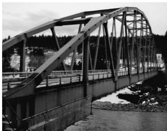
写真—2 三島大橋・全景
