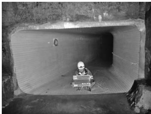
写真—4 施工後の管きょ内面状況
