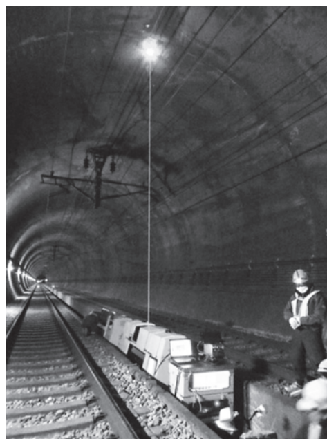
写真—9 トンネル内中央通路型の装置
