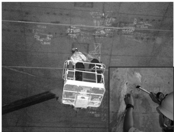
写真—4 現地試験箇所例
