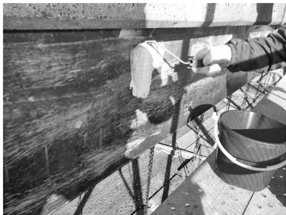
写真—8 主桁表面保護工（含浸系）
