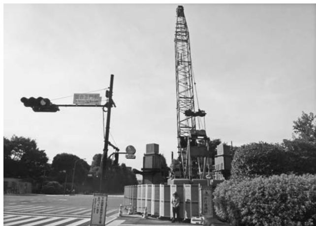
写真—3 立坑設置箇所（アーバンリング工法）
