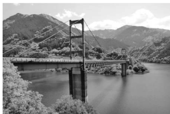
写真—6 大渡ダム大橋・全景
