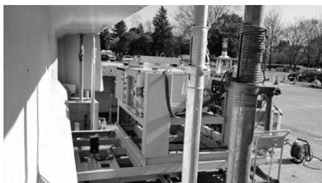
写真—2 PCT 桁橋の撮影
