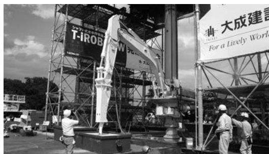
写真—2 コンクリート破碎状況
