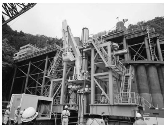
写真—6 水中作業機進水
