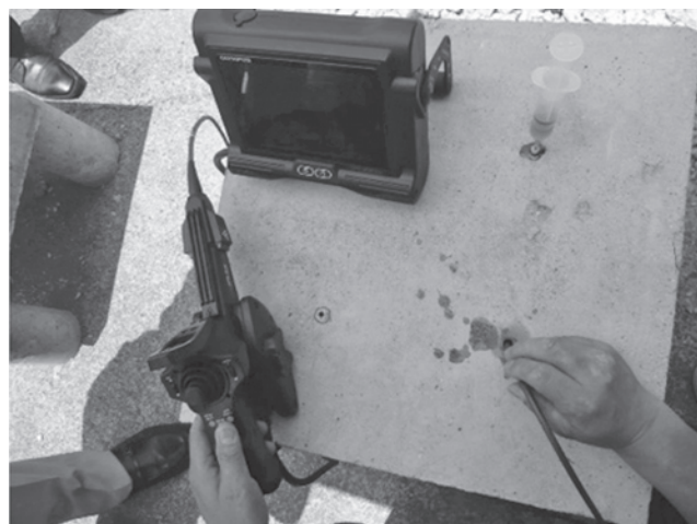
写真ー4 工業用内視鏡の調査状況
