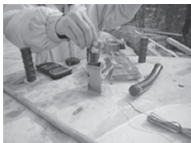
写真1 動的破碎剤（点火具とも）
