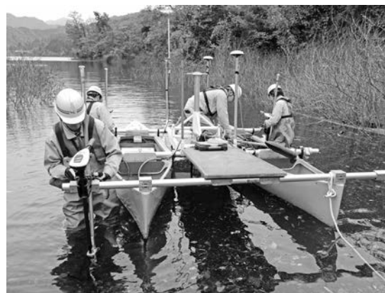
写真一1 艀装状況
