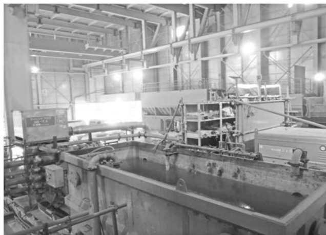
写真—4 防音ハウス内状況
