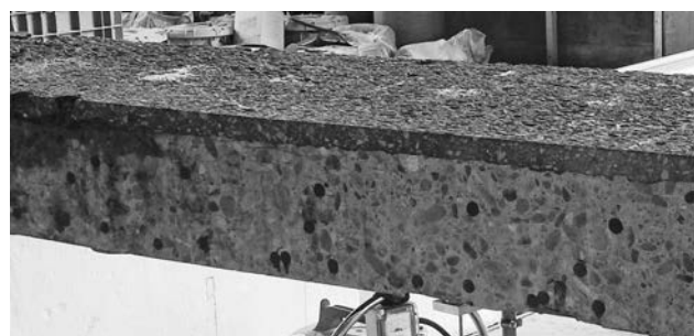
写真-7 使用した撤去床版
