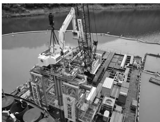
写真—5 水中作業機設置
