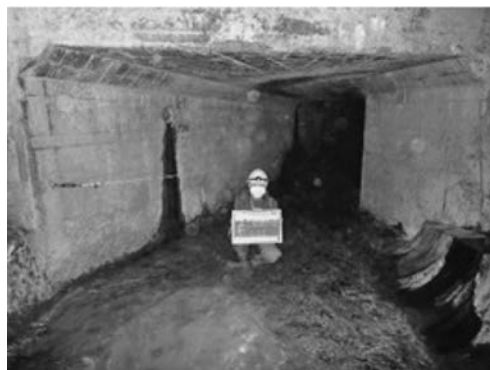
写真一三 既設管きょ拡幅部
