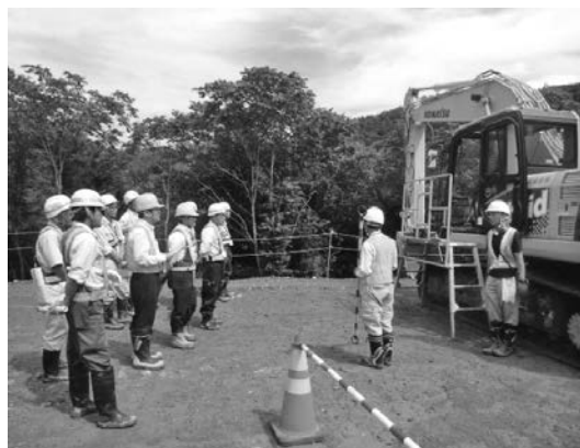
写真一 2 見学会実施状況
