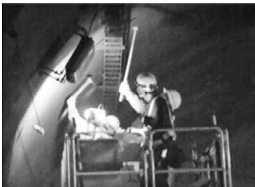
写真—3 打音検査の作業状況
