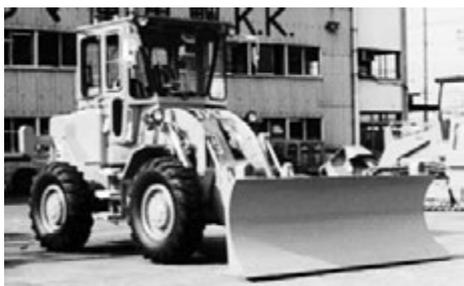
写真 5-13 除雪ドーザ Cat920 キャタピラージャパン<sup>(株)</sup> 昭和45年
