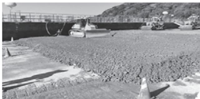
写真一5 RCD コンクリート自動まき出し・整形状況
