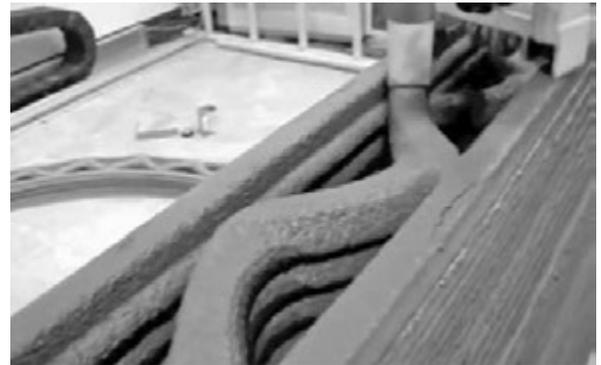
図一11 巨大3Dプリンター「コンター・クラフティング」の完成イメージ（上）。壁の造形風景（下）。壁の内側、外側、内部を順次、層状に積み重ねて造っていく（資料・写真：南カリフォルニア大学）
