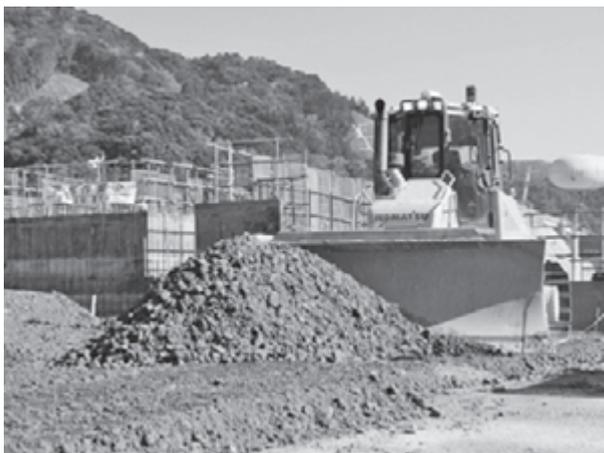
写真一4 RCD ダム工事での自動運転状況
