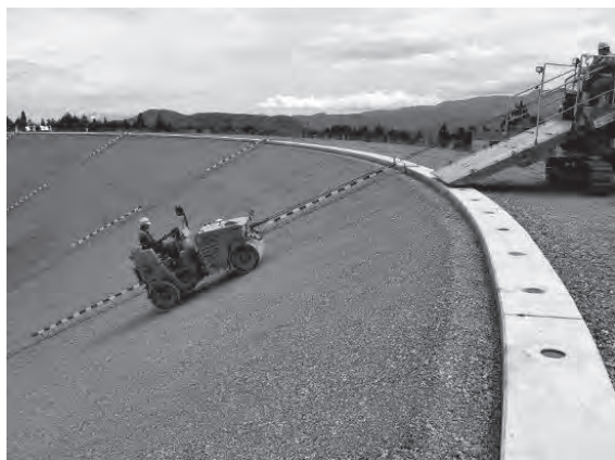
写真-4 ダム・ため池舗装工事例
