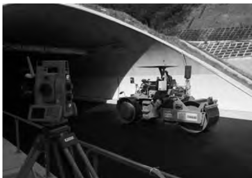
写真—10 坑口付近施工状況
