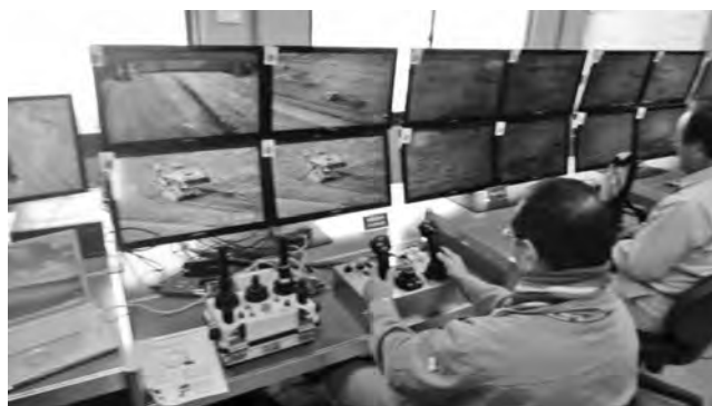
写真—10 ロボット実証実験状況（操作室）
