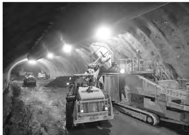
写真—1 急速ズリ処理システム
