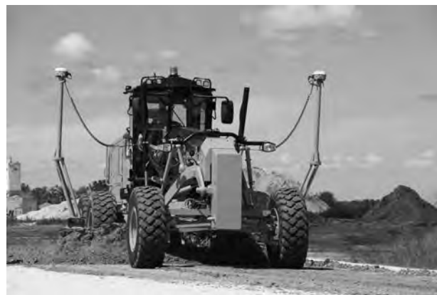
写真一七 情報化施工（GNSS 仕様）（写真は国内仕様とは異なります）
