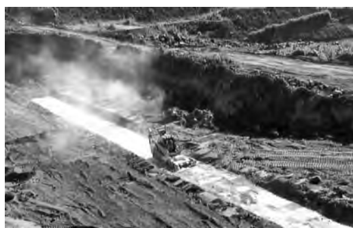
写真—6 清掃作業状況
