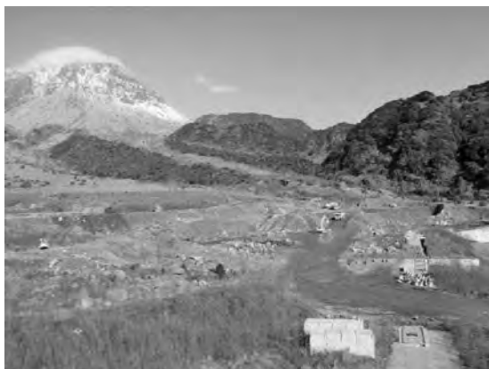
写真一 1 床固工工事施工状況①
