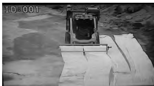
写真—8 養生作業状況
