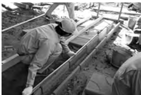
写真一 2 3 年生総合実習（施工実習）
