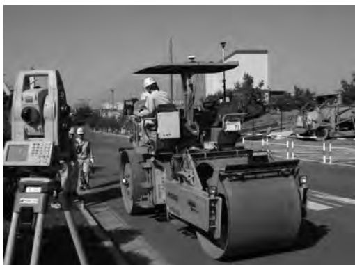
写真—9 試験状況写真
