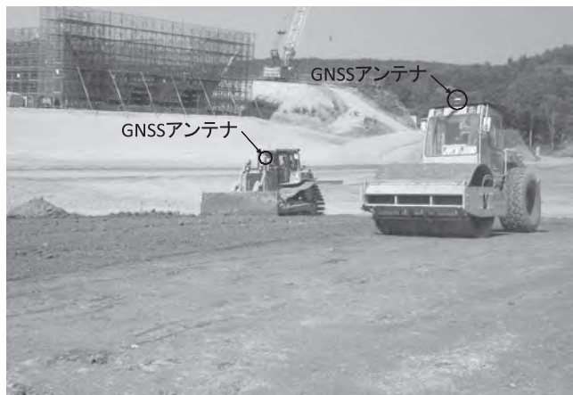
写真—1 敷均し転圧状況
