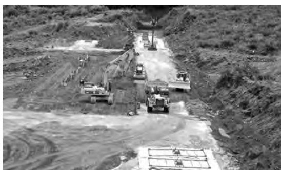
写真一 2 床固工工事施工状況②
