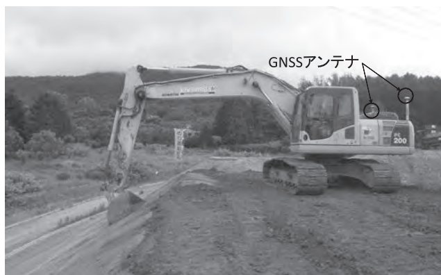
写真—2 法面締固め状況
