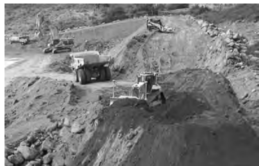
写真—7 カメラ車利用状況
