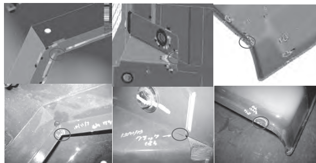
図—9 建屋カバー疲労解析結果（破損予測部位）
