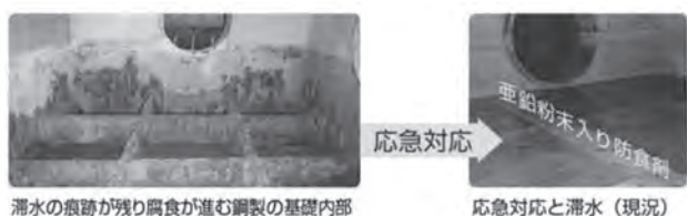
図—4 15号堺線（湊町付近）
