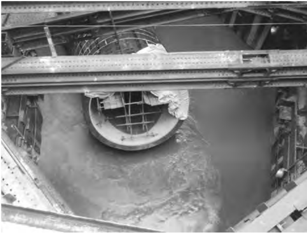
写真一七 流動化処理土打設
