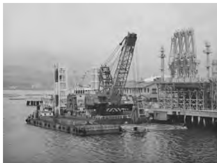
写真一八 LNG 栈橋前面 グラブ浚渫状況
