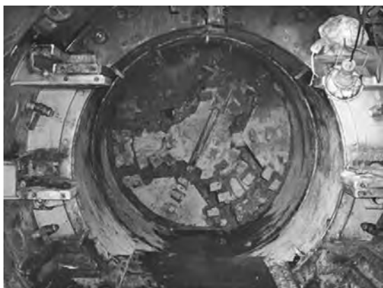
写真—5 シールド到達状況（正面は受入側シールド）
