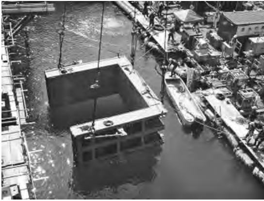
写真一8 仮締切扉体吊り込み状況
