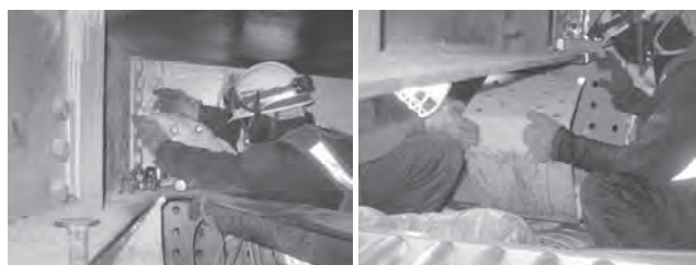
写真五 横桁の表裏で2班配置しての作業
