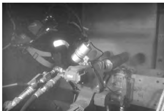
写真ー3 アンカーボルト削孔状況（水中）
