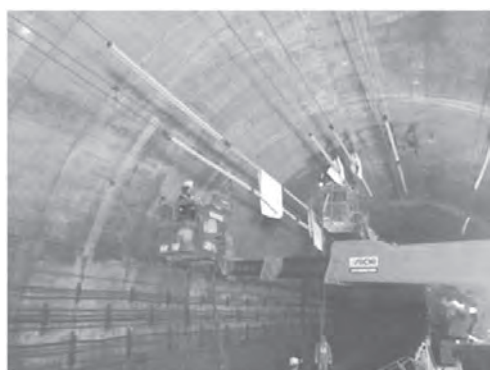
写真—8 2箇所同時注入の施工状況
