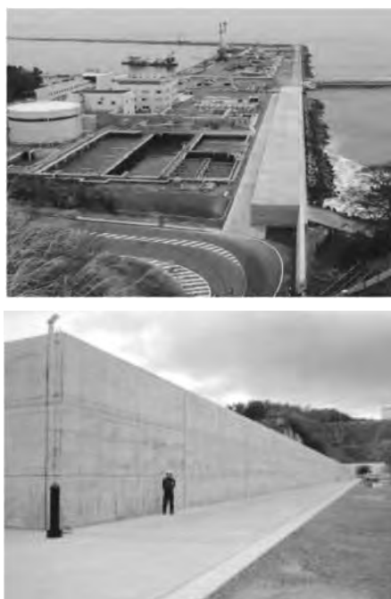
図—5 広野火力発電所防潮堤
