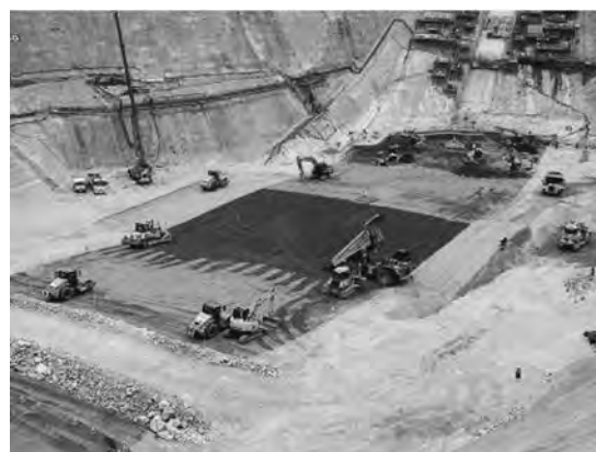
写真—2 堤体部盛立施工状況
