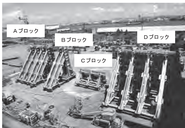
写真—4 工場での底部架台の仮組立状況
