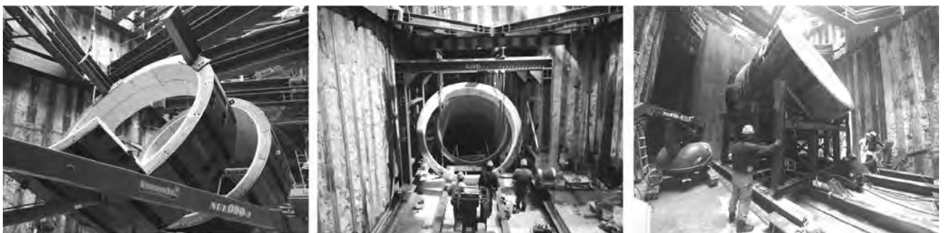
写真一八 特殊部の施工状況
