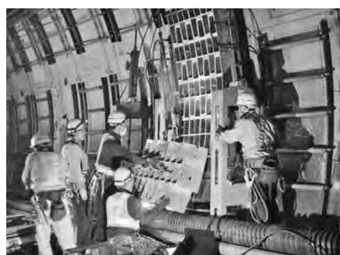
写真—5 セグメント運搬フロー
