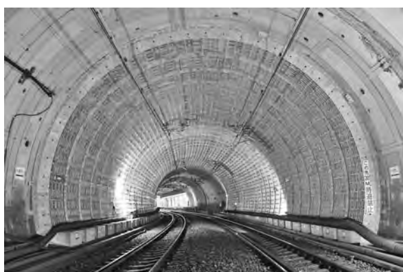
写真—7 内部補強工完了全景
