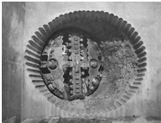
写真-2 1工区シールド到達状況
