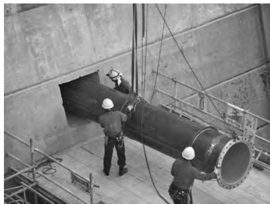
写真―3 取水管挿入状況
