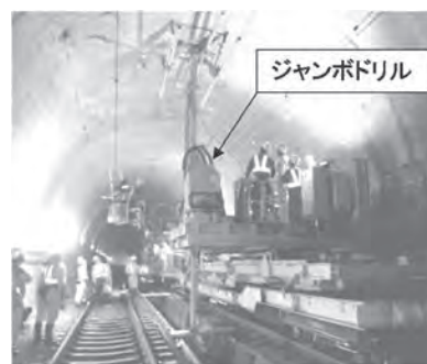
写真—9 削孔状況
