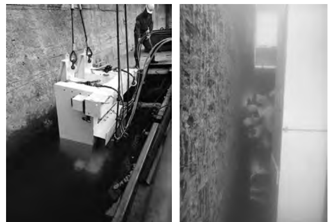
写真－2 水中ツインヘッドによる施工状況
