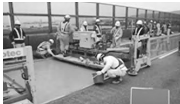
写真—4 SFRC舗装の施工状況
