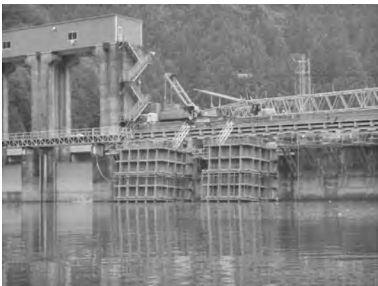
写真一9 仮締切設備据付完了
