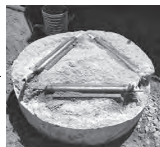
余盛コンクリート撤去完了
