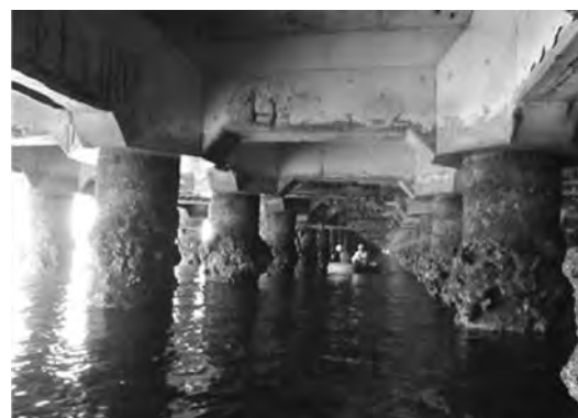
b) 栈橋下での作業状況
