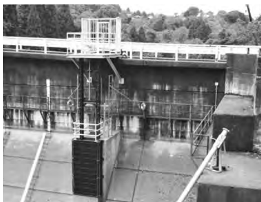
写真一4 取水口ゲート据付完了
