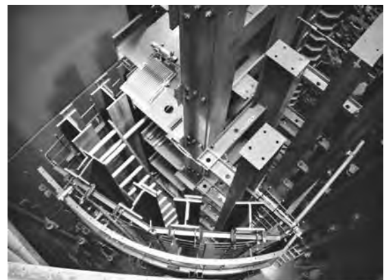
写真一10 予備ゲートピア施工状況
