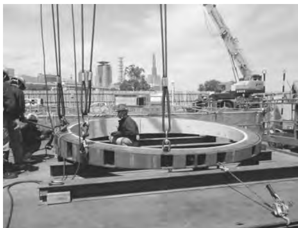
写真—4 セグメントの地上組立
