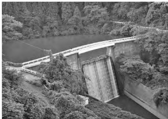
写真—1 平沢川砂防堰堤
