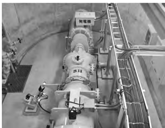
写真一6 水車発電機据付完了
