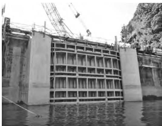
写真—12 予備ゲート扉体据付完了
