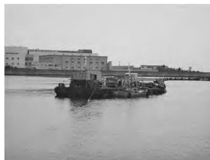
写真一10 散布台船 覆土状況
