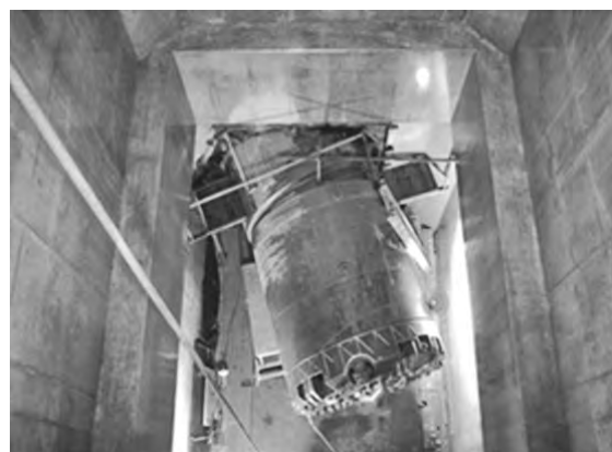
写真-3 1工区シールド抜き出し状況
