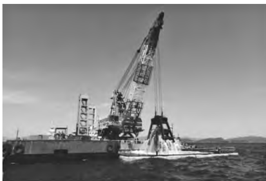
写真―3 グラブ浚渫船「第16平成」 全景
