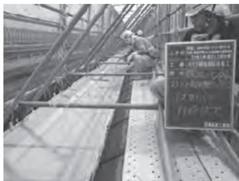
写真—6 セルフレベリング材の使用
