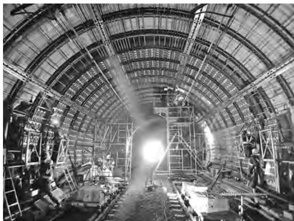
写真—6 内部補強工施工状況
