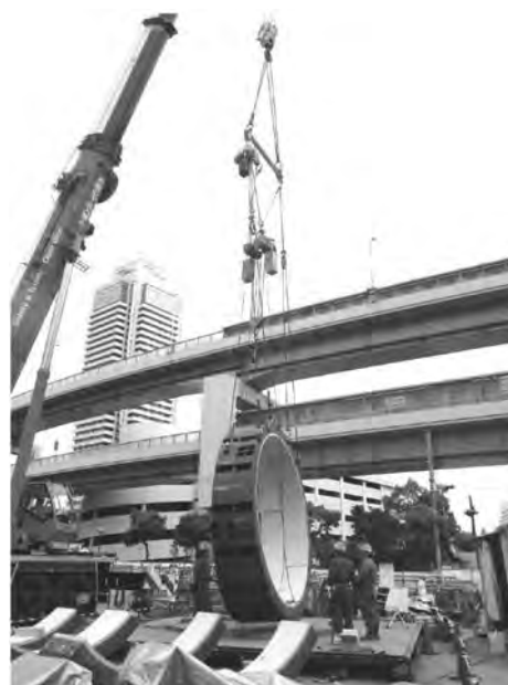
写真—5 セグメント投入
