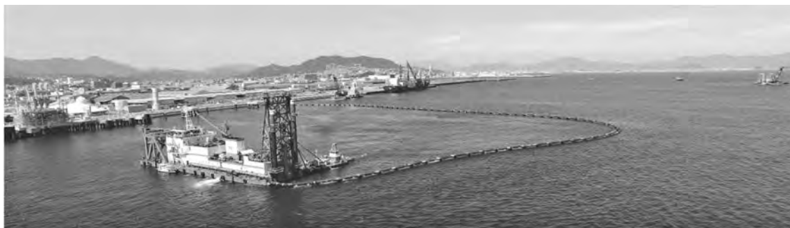
写真―6 浚渫区域全景
