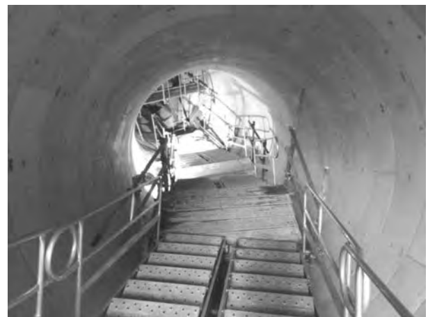
写真二〇 セグメント管路内部
