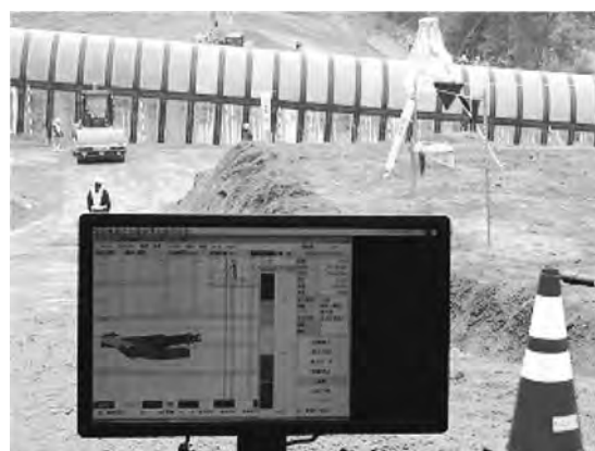
写真—3 締固め管理システム見学状況
