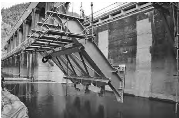
写真—5 鋼製架台（斜材）吊り込み状況
