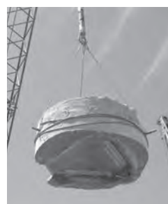
余盛コンクリート撤去状況
