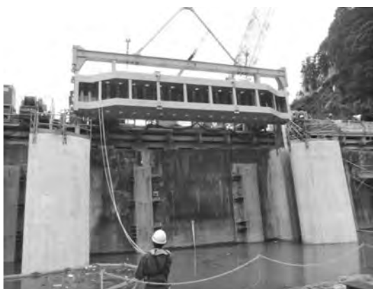
写真—11 予備ゲート扉体吊り込み
