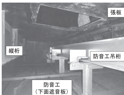
写真三 橋りょうの内部構造
