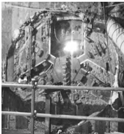
写真—4 2工区シールド到達状況
