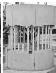
写真—2 撤去状況
