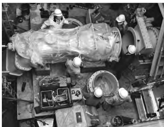
写真一5 水車据付状況
