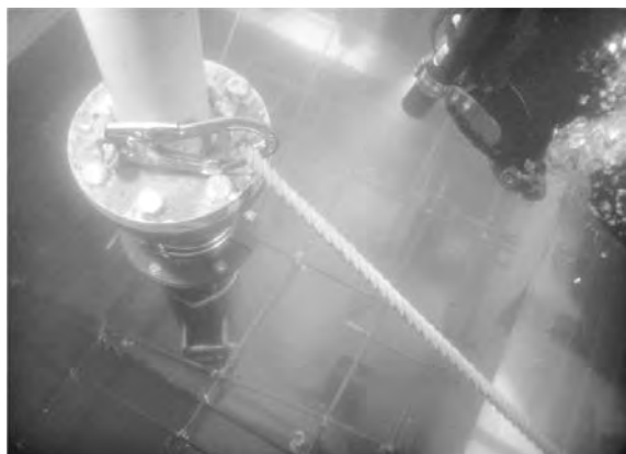
写真一七 水中不分離性コンクリートの打ち込み（水中）
