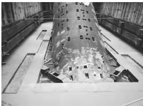
写真—3 開口補強鋼材（SRC 構造）
