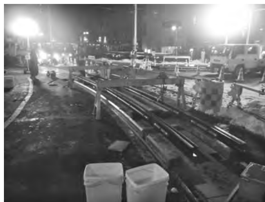
写真—5 レール据付状況
