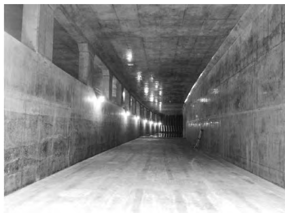
写真一4 高浜橋架道橋改修 (奥がⅠ期工事, 手前がⅡ期工事)
