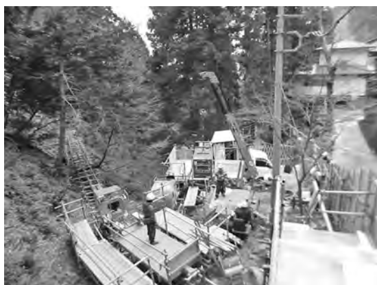
写真—1 仮設モノレール発進基地
