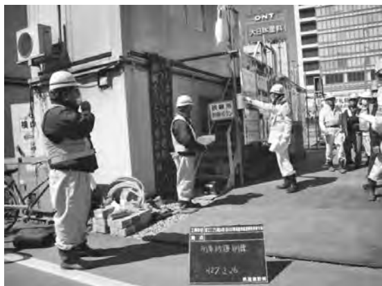
写真—6 列車防護訓練状況
