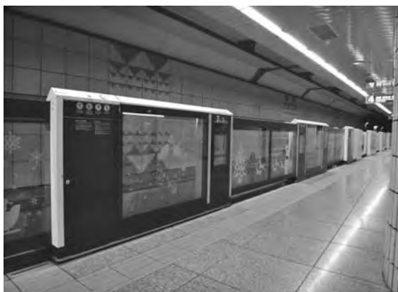
写真—3 透過タイプの可動式ホーム柵
