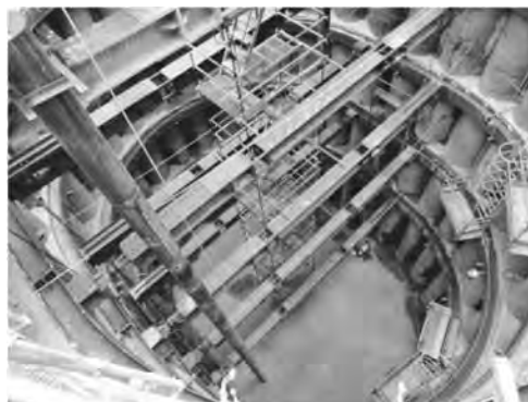
写真—4 鋼管井筒内支保工設置状況
