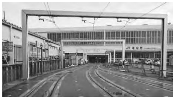
写真一〇 駅前広場部 完了全景
