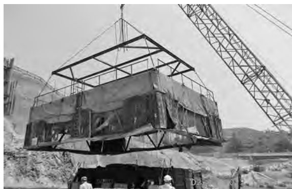
写真一6 ステージ1 発破防護工設置状況
