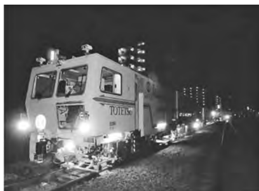
写真—8 MTT 編成群による軌道こう上状況
