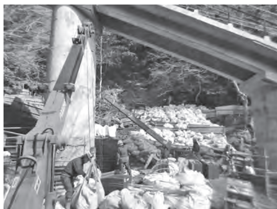
写真ー12 第2電車橋での土砂仮置き状況
