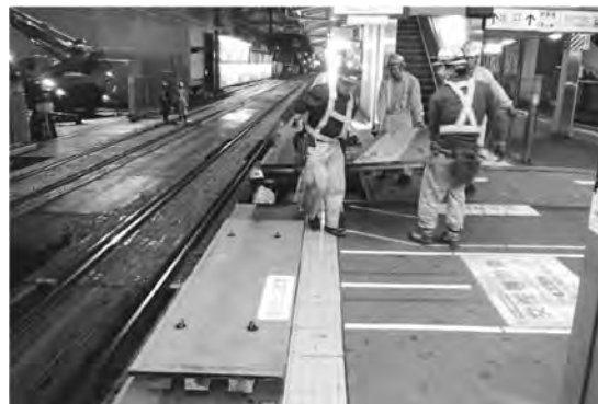
写真―1 人力による仮覆工の撤去状況
