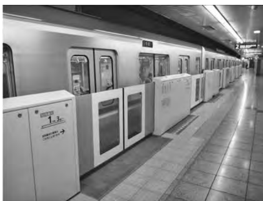
写真—2 腰高タイプの可動式ホーム柵
