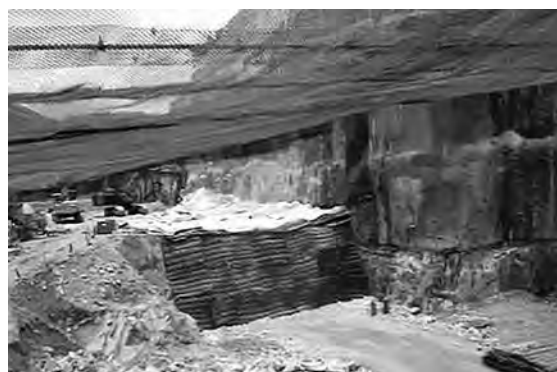
写真一7 ステージ3 発破防護工設置状況
