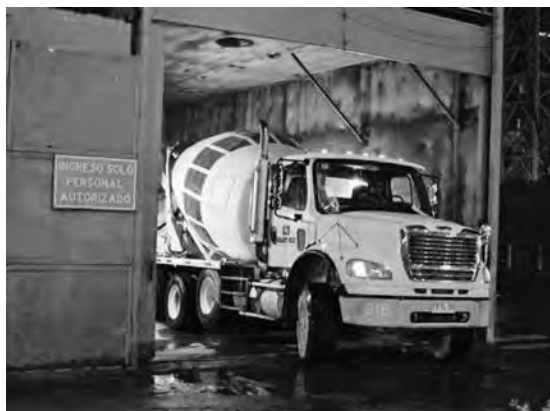
写真―10 夜間 市街地で防音ビットへ入りコンクリ攪拌作業中のモバイルミキサ
