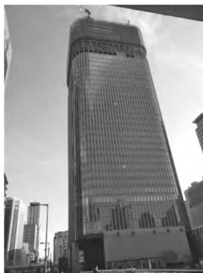
写真-6 現況の建物外観全景
