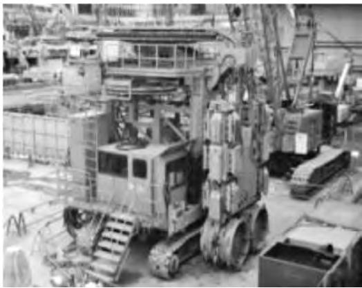
写真ー1 連壁掘削機
