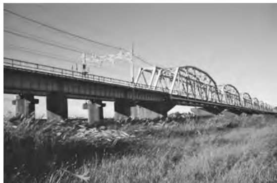
写真—1 現利根川橋梁全景
