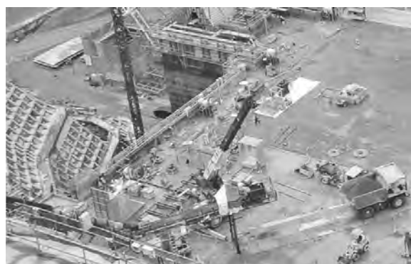
写真一4 固定式ベルコンをずらして配置（湯西川ダム）
