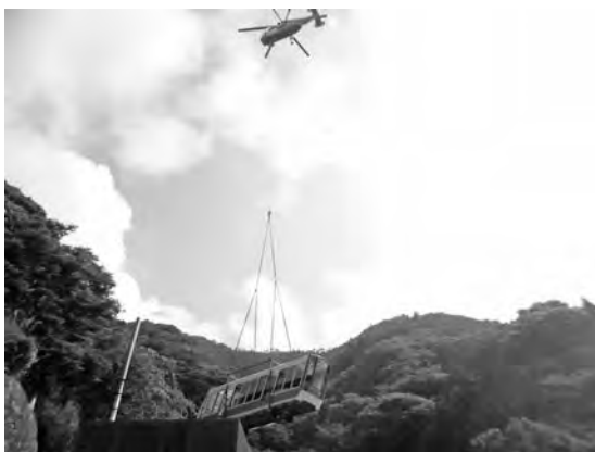
写真—8 新型車体搬入状況
