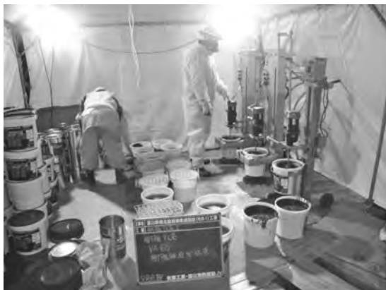
写真一七 樹脂練り混ぜ状況
