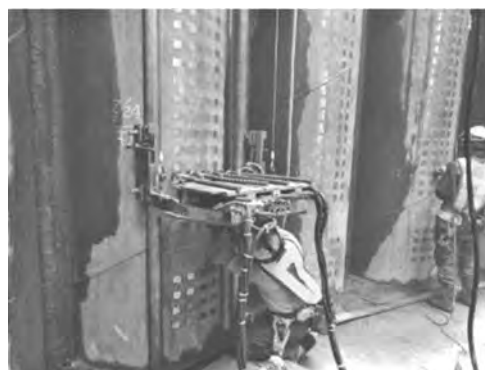
写真—5 スタッドジベル溶接状況
