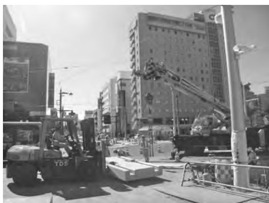
写真—3 PC版据付状況
