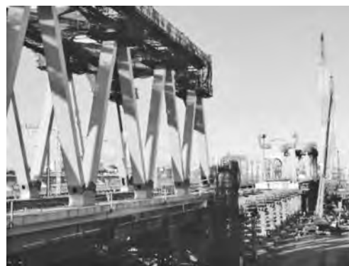
写真—6 架設状況（高水敷き部）
