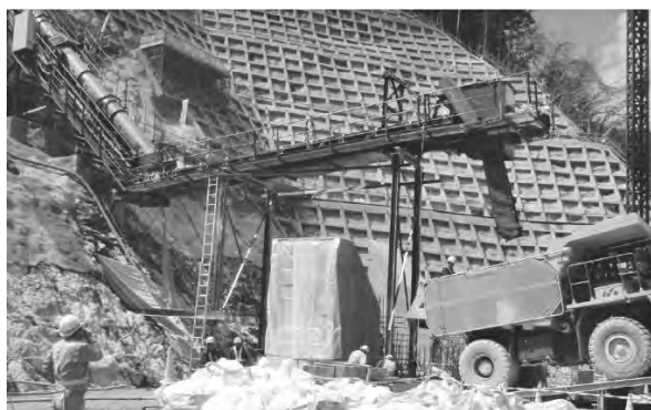
写真一3 監査廊回避 固定式ベルコン設置（湯西川ダム）
