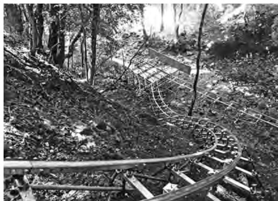
写真—2 スイッチバックと45°の急勾配
