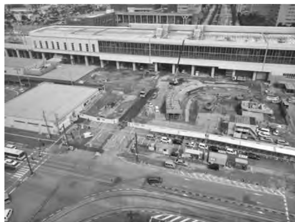
写真一1 交差点部及び駅前広場部 着工前全景
