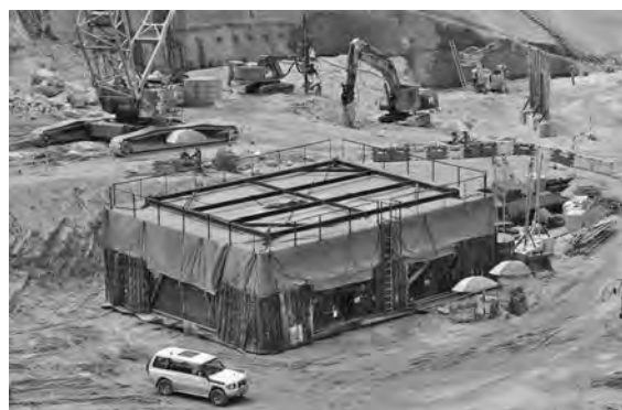
写真一4 ステージ1 発破防護工（ダブルケージ方式）
