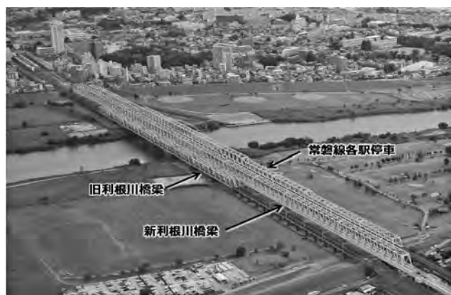
写真ー10 施工完了後
