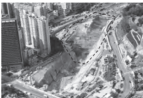
写真—5 ステージ2 発破防護工 (ルーフオーバー方式)
