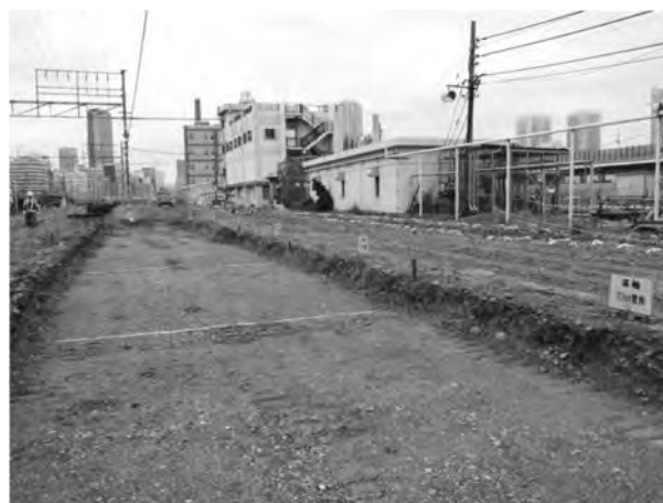
写真—2 路盤試験施工状況
