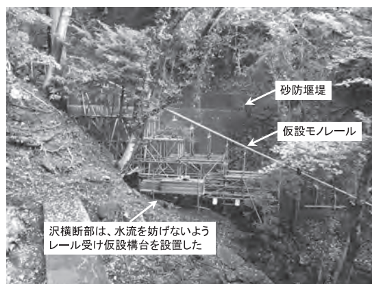
写真—3 砂防堰堤部
