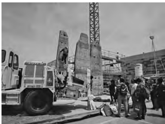
写真一6 ExpoHormigón 実演展示 (3)
