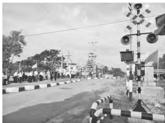
写真—2 日本製踏切警報機の設置
