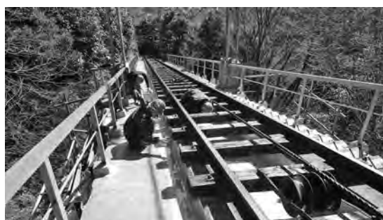
写真—11 橋面上での防水施工状況
