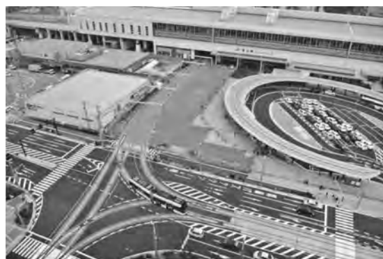
写真一九 交差点部及び駅前広場部 完了全景
