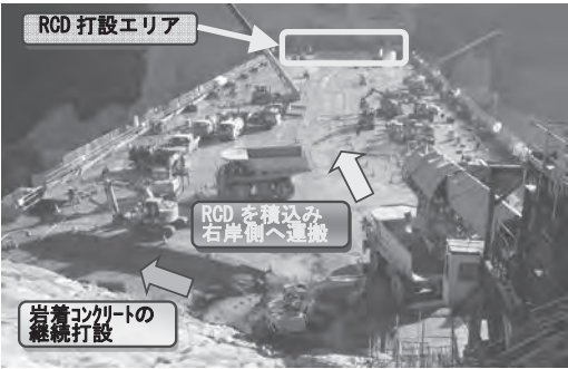
写真一七 岩着コンクリートと次層 RCD の同時施工
