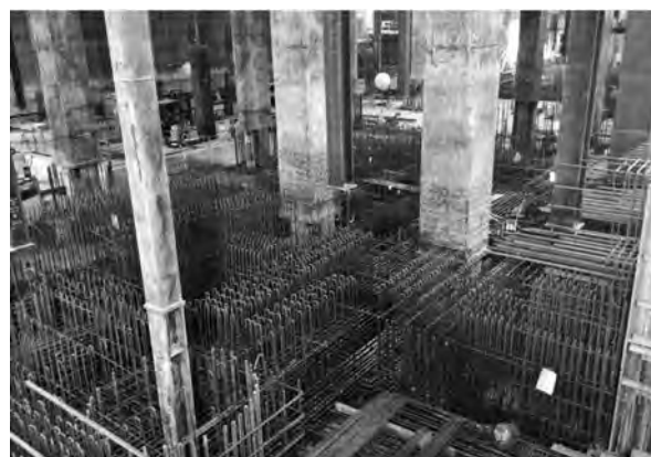
写真-5 地下工事の状況
