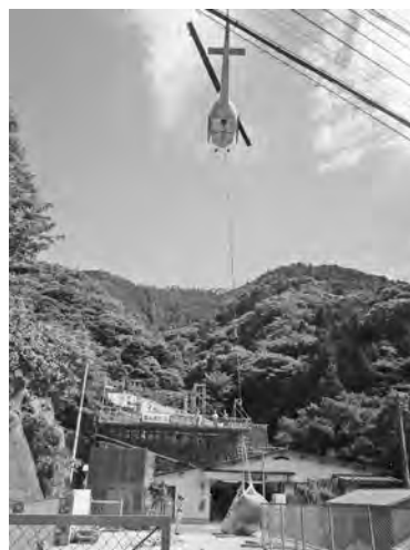
写真—6 仮設材空輸状況（大山ケーブル駅付近）
