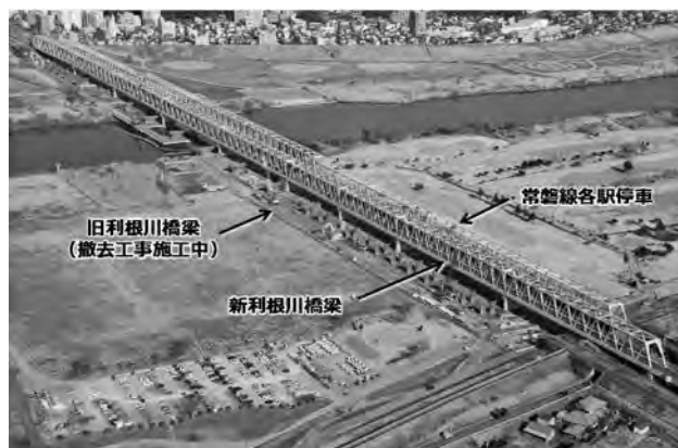
写真ー11 撤去工事施工状況（H28.1月現在）
