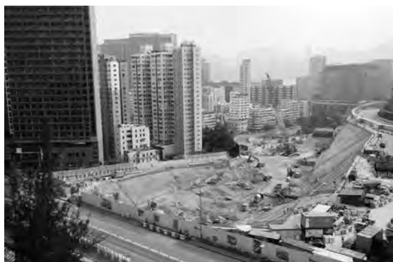
写真一2 何文田駅舎 オープン掘削状況（北側より望む）
