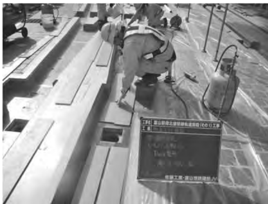
写真一六 レールパッド据付状況
