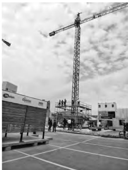
写真一5 ExpoHormigón 実演展示 (2)
