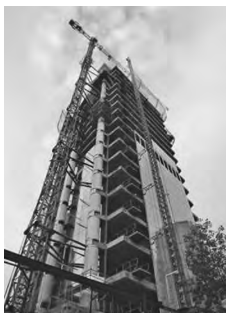
写真—7 Las Condes 地区で建築中のオフィスビル
