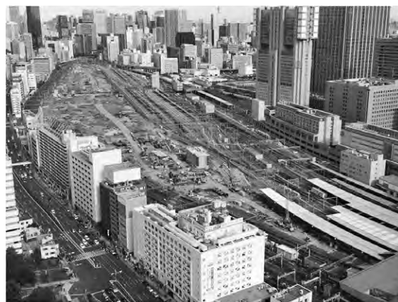
写真—1 品川車両基地全景 (左 旧車両基地撤去他工事中 右 暫定供用中車両基地)
