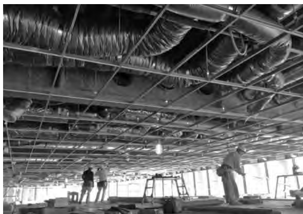
写真-4 天井工事の状況
