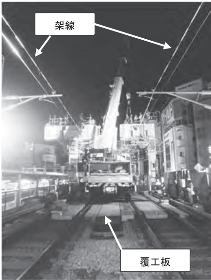
写真―8 鉄骨架設状況
