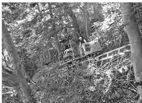
写真—4 小型バックホウ運搬状況
