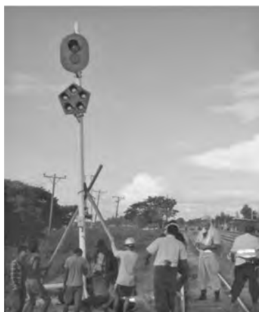
写真—3 「踏切動作反応表示灯」(柱上部)と「特殊信号発光機」(柱下部)
