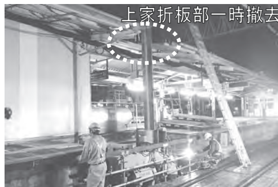
写真―2 上家を撤去しての鋼矢板吊込み
