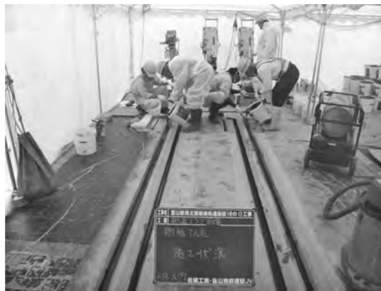
写真一八 樹脂打設状況
