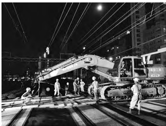
写真一3 重機線路横断状況 (0.16 m³ バックホウ)
