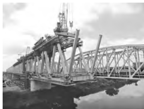
写真—7 架設状況（流水部）
