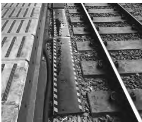
写真—7 転落検知装置の設置例
