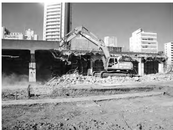
写真—5 旧高架橋撤去状況
