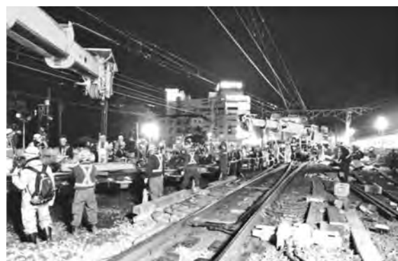
写真—9 50 t 軌陸クレーン合吊りによる分岐器挿入状況
