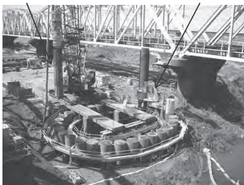
写真—3 施工状況（鋼管矢板圧入）
