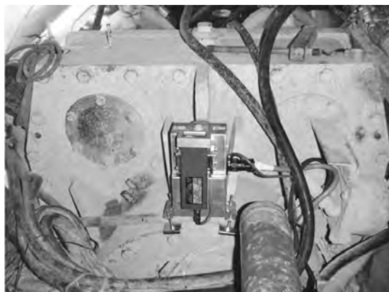
写真-5 計測機器設置状況（上側）
