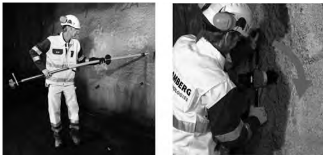
写真-5 レシーバーの挿入、モルタルの密着
