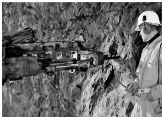
写真—2 受振・発振孔削孔状況
