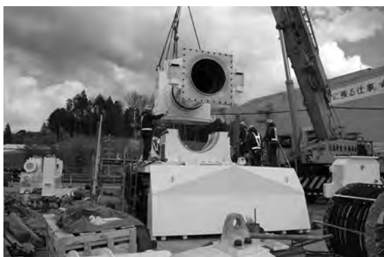
写真—7 組立中の本機
