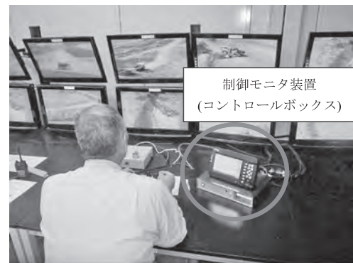
図一 6 MG 施工状況
