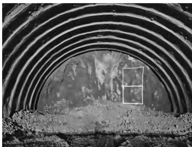
写真六 切羽へのレーザーマーキング
