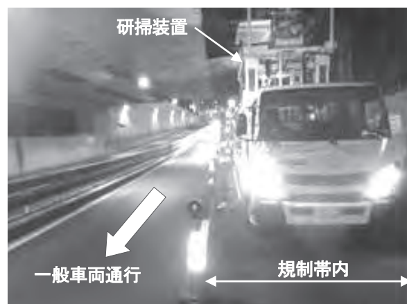
写真一九 施工状況（研掃装置の設置）
