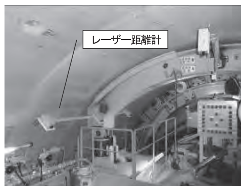
写真—2 真円計測システム稼働状況（上部側）
