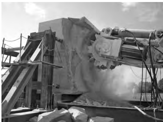
写真—5 掘削要素試験状況
