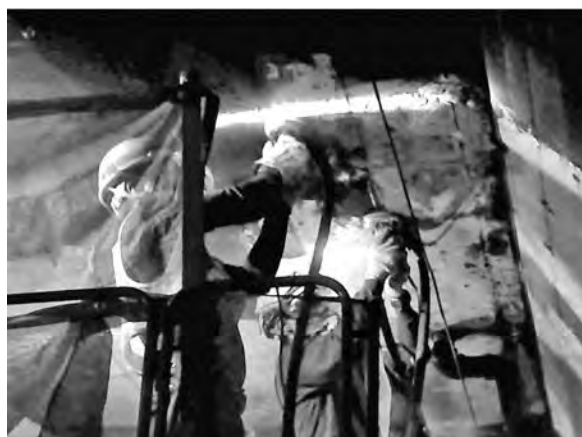
写真—2 人力によるトンネル天井面の表面処理
