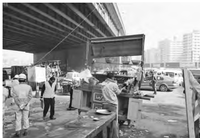
写真—4 街中での橋梁点検
