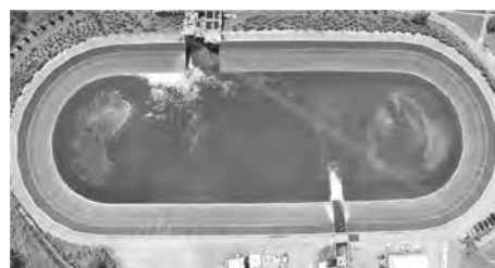
写真-8 現場完成写真
