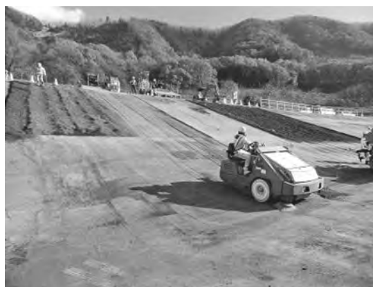
写真—3 スリーパによる清掃作業状況
