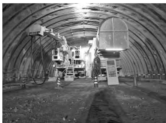
写真—10 掘削状況（掘削機と集塵機をセット）
