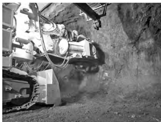
写真—9 掘削状況（切羽面）
