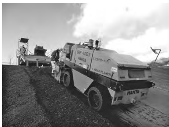
写真—2 切削機使用状況
