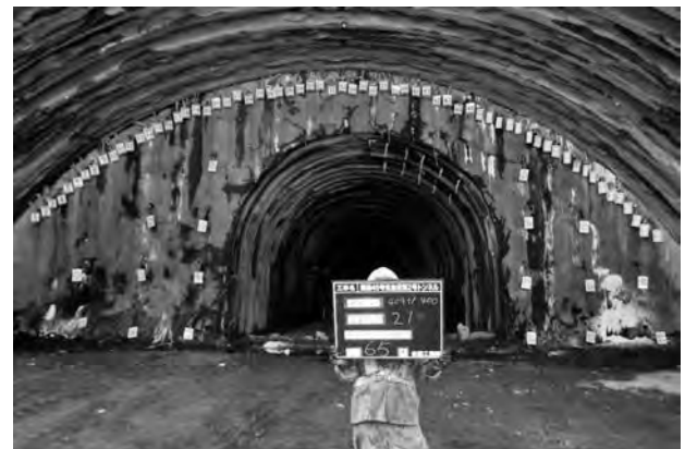
写真—4 補助工法施工状況（崩落箇所）
