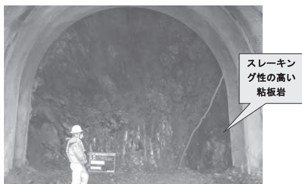
写真—1 支保No.11 切羽状況
