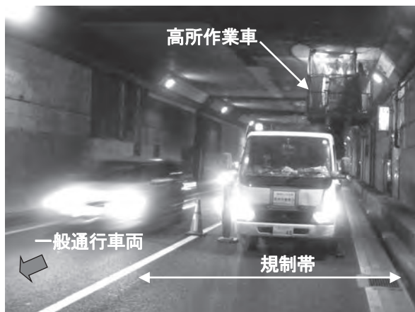
写真—1 トンネルの補修・補強工事
