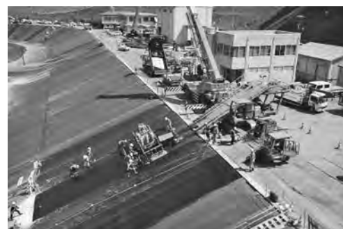
写真-7 斜面舗装施工状況全景
