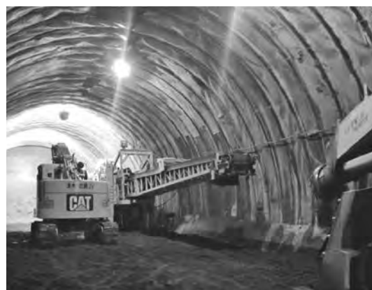
写真—2 実証実験状況（厚賀トンネル）
