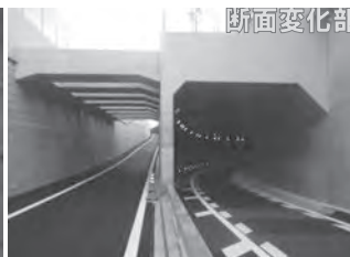
写真-16 完成トンネル坑口
