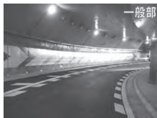
写真-15 完成トンネル内
