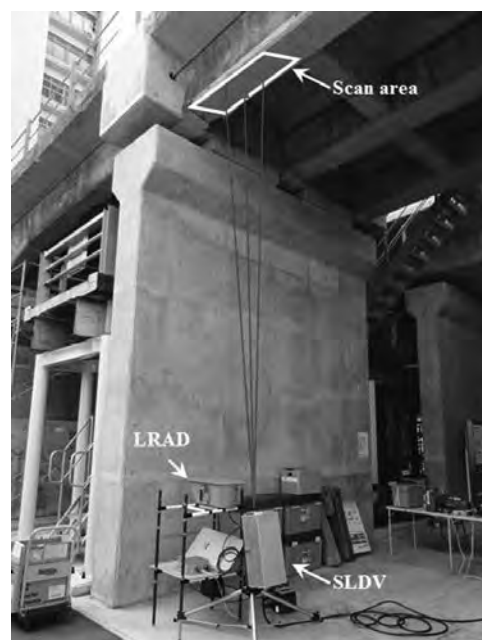
写真－1 音響探査法を用いた橋梁桁下面のはく離調査 N2Uブリッジ（名古屋大学）
