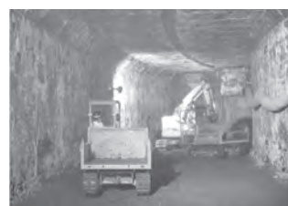
写真—11 内部掘削状況
