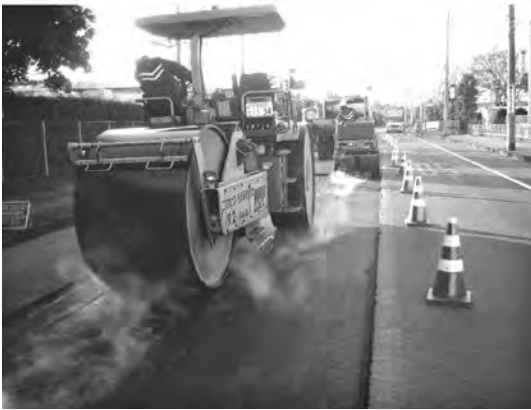
写真一4 転圧状況
