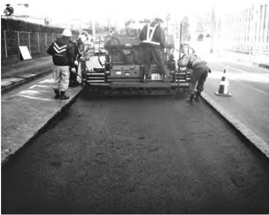
写真一3 敷きならし状況
