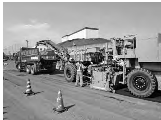
写真—1 切削作業風景
