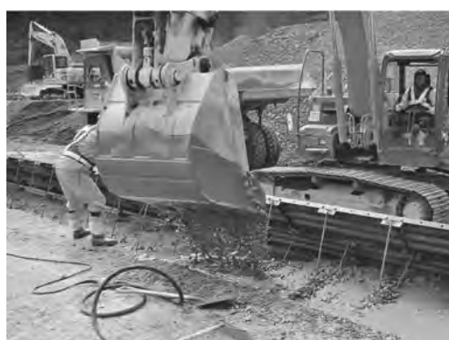
写真—2 流動化ソイルセメントの施工状況
