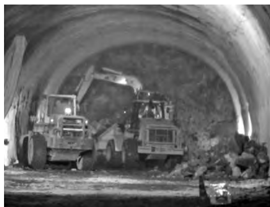
写真—1 実証実験状況（こばやし峠トンネル）
