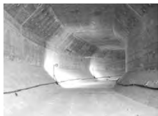
写真-13 トンネル完成
