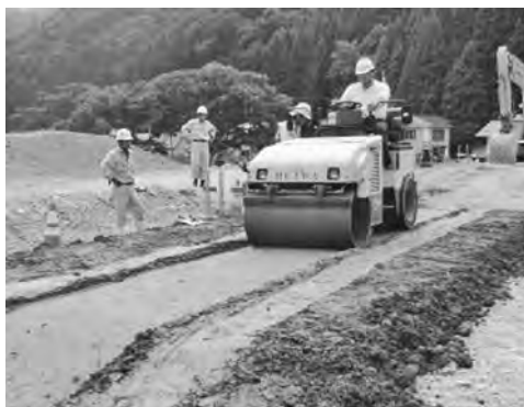
写真ー１ INSEM 工法の施工状況
