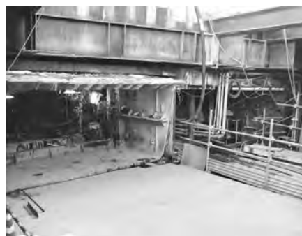
写真—6 上段シールド（横・開放型）
