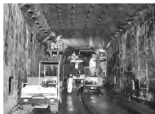
写真-12 セグメント撤去状況
