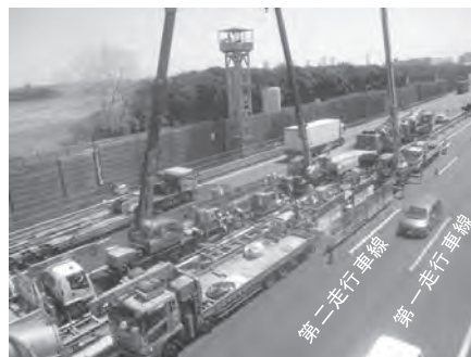
写真—7 地盤改良施工状況
