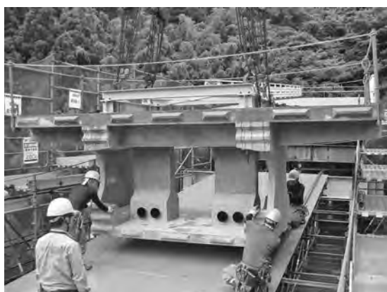
写真ー4 セグメント架設状況
