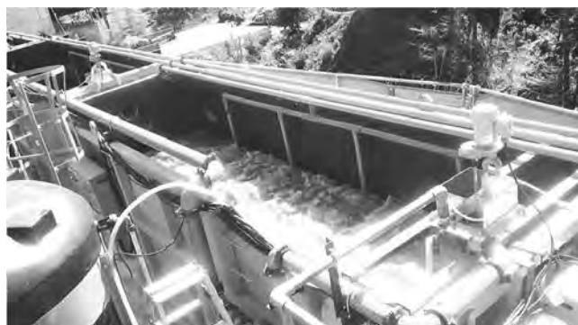
写真－１ 現場実証試験状況
