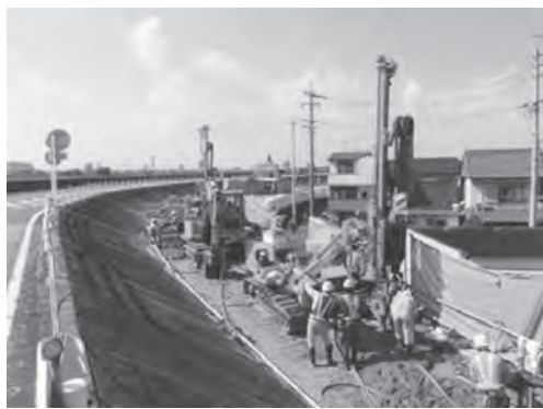
既設河川堤防上における施工状況
