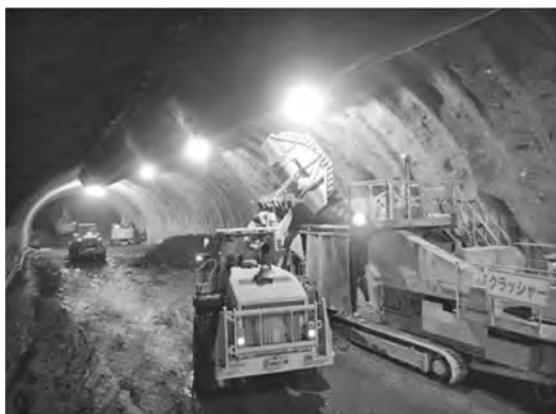
写真—4 ストックずり処理と切羽作業の同時作業
