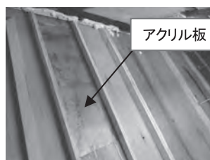
写真—10 アクリル板の型枠
