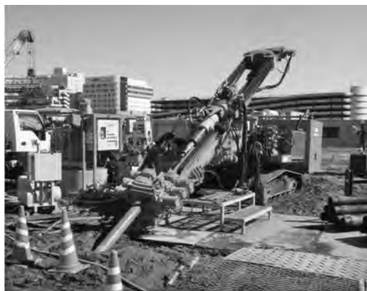
写真—3 斜め施工状況
