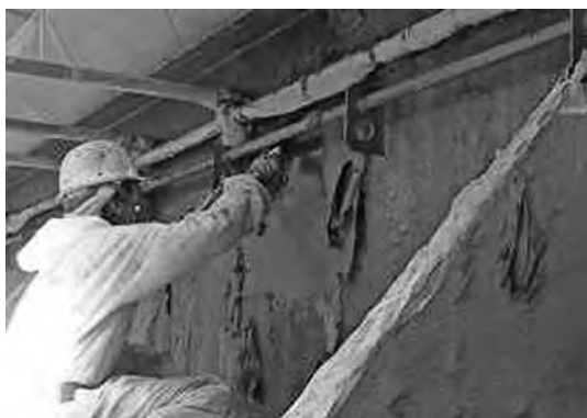
写真—2 施工状況
