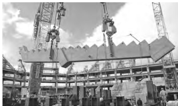
写真—9 圧着接合完了及び頂部サイト PCa 接合後の地切り状況
