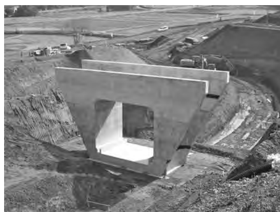
写真—12 函渠構造物完成写真
