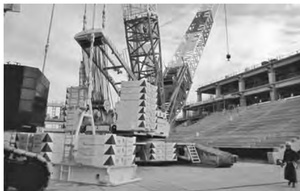
写真—10 600tクローラークレーン（追加ウエイト付）
