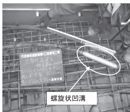
写真—3 スパイラルインナーバイブレータ
