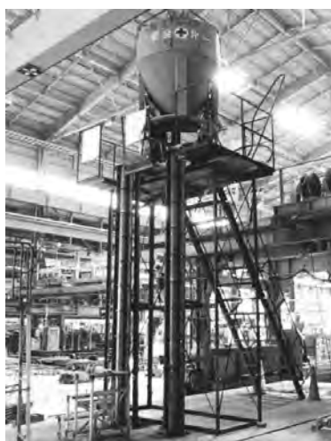
写真—5 コンクリートの打込み状況
