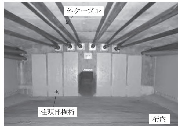
写真一10 完成（桁内）
