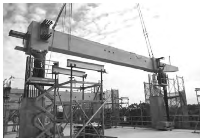
写真—2 柱梁接合部一体型 PRC 梁
