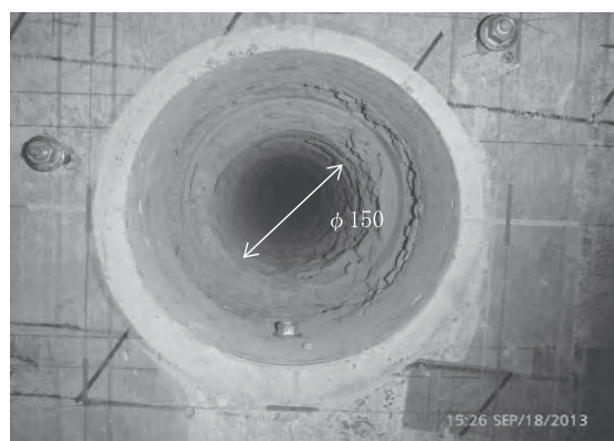
写真一6 WJ拡張削孔
