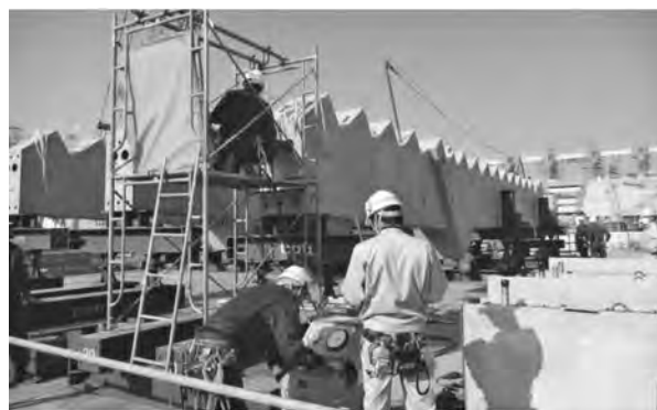
写真—8 地組ヤードでの安全な圧着接合作業
