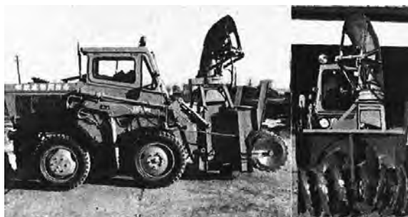
写真 7-26 小形除雪車 ロモート S31A 40 PS 北海道開発局， 日熊工機(株) 昭和 43 年
