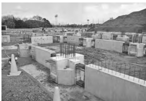
写真—4 基礎PCa配置状況
