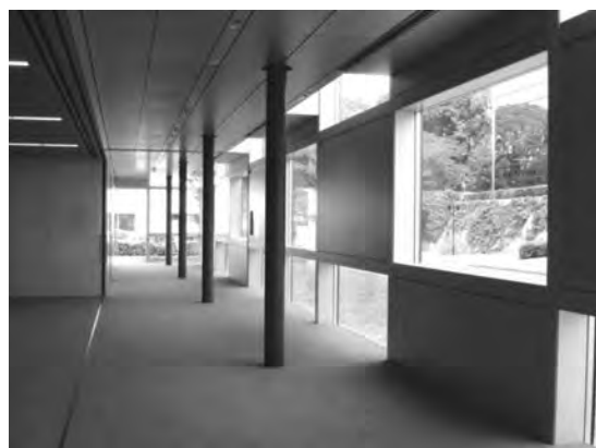
写真—7 RC 長柱の設置状況
