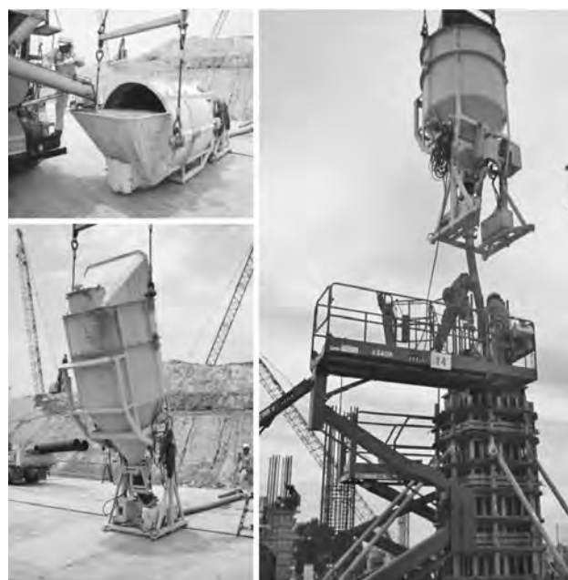
写真—6 大型ホッパー（ 5\text{ m}^3 ）によるCON打設
