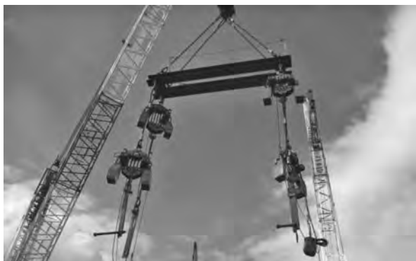
写真—12 傾斜回転用治具（トラバーサー &amp; 30tチェーンブロック）
