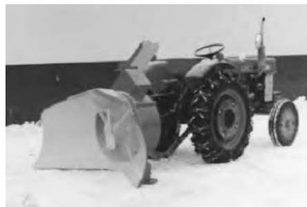
写真 7-28 小形ロータリ除雪機 SC81 プロア式ワンステージ， (株)日本除雪機製作所 昭和 44 年頃
