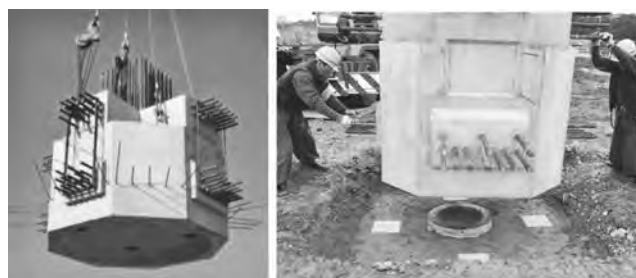
写真－3 フーチング PCa 取付状況
