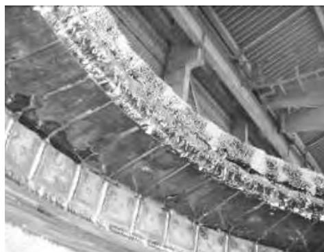
写真—3 FH ブラシ注入完了
