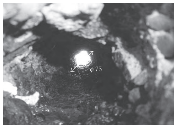
写真一5 WJ小径先行削孔
