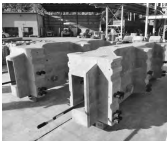
写真-2 プレキャスト化した中間横桁
