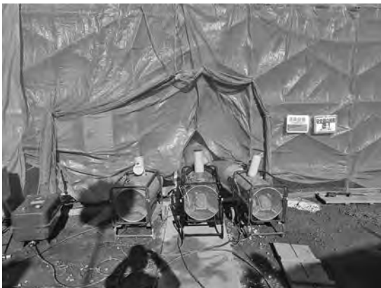
写真－9 ジェットファーンネス設置
