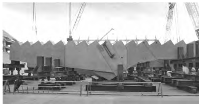
写真—7 大型 PRC 斜梁地組状況（コーナー部材）
