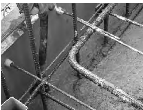
写真—4 細径バイブレータ（かぶり部）
