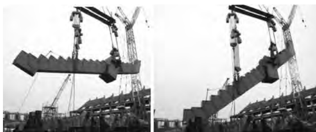
写真—13 電動チェーンブロックのリモコン操作にて35°傾斜実現
