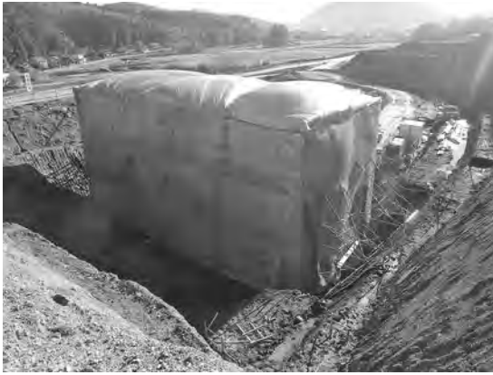
写真－8 給熱養生
