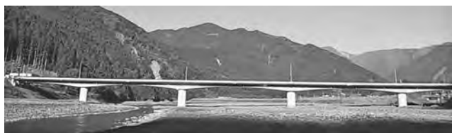
写真一 淙徳橋全景
