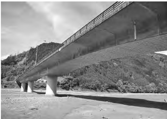
写真一9 完成全景
