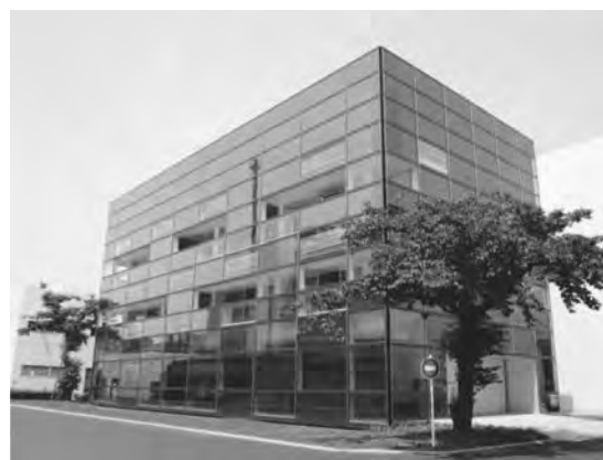
写真—4 建物の外観
