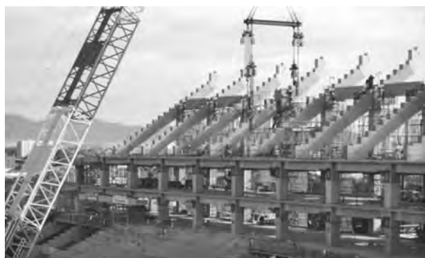
写真—11 600tクローラーによる広旋回範囲での揚重
