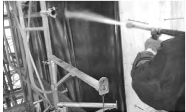
写真－10 養生マット散水状況
