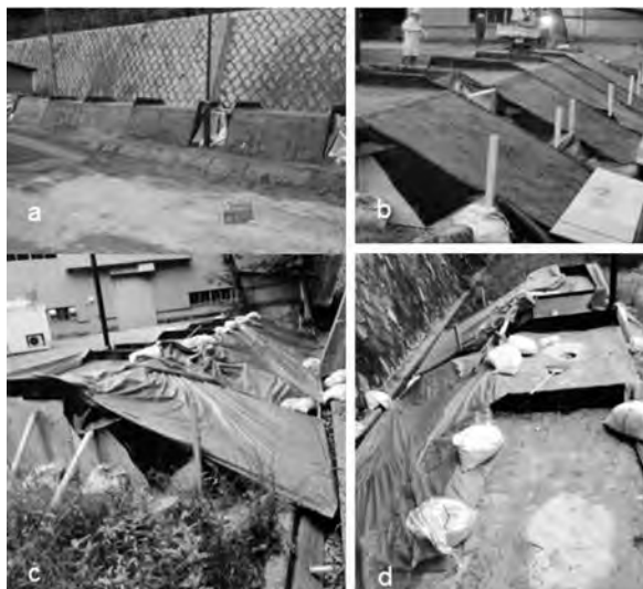
写真-1 小型盛土の様子 (a: 正面, b, c: 背面, d: 上面)
