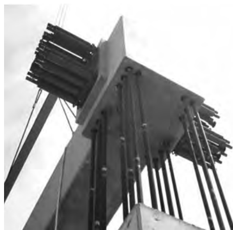
写真—5 無支保工でのPCa接合
