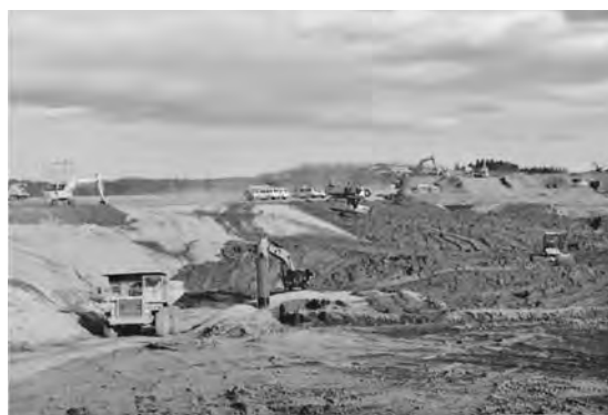
写真—2 大型重機稼働状況
