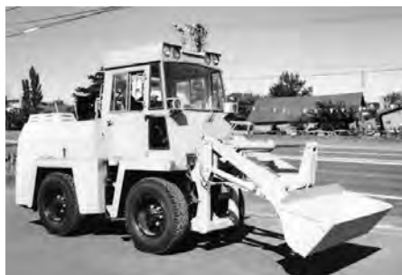
写真 7-83 小形除雪車 HTR140 のアタッチメント・バケット装置 (株)日本除雪機製作所 昭和 59 年
