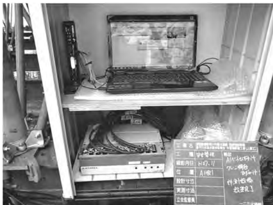
写真—1 現場内変位確認状況
