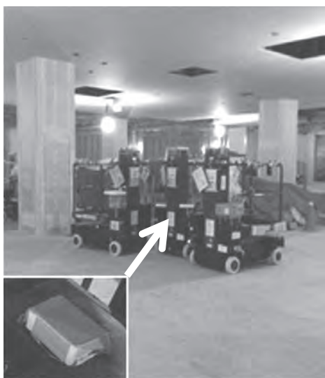
写真-4 高所作業車に設置した無線発信機
