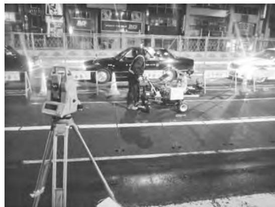
写真一三 本計測器による測量状況
