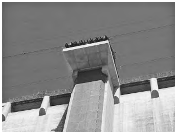
写真—1 取水塔の形状写真
