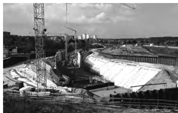
写真—28 A66-A661 Riederwald Tunnel の施工状況
