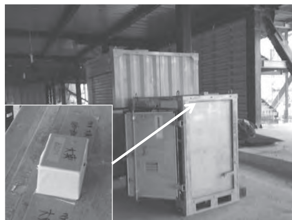
写真-5 資材置場の倉庫に設置したアプリケーション起動用 BLE 端末
