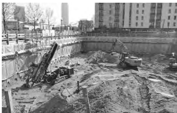
写真—27 基礎工事の作業状況
