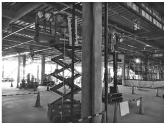
写真一2 高所作業車を使った作業例
