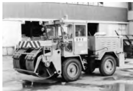
写真 7-80 ロータリ除雪車 MR120 のアタッチメント・パッチングローラ (道路用転圧機) (株)日本除雪機製作所 昭和 47 年
