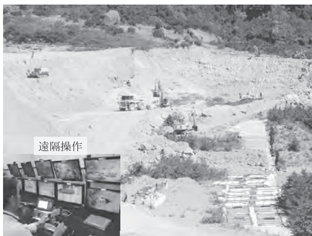
写真-1 無人化施工による施工状況（2013.9 雲仙復興現場より）
