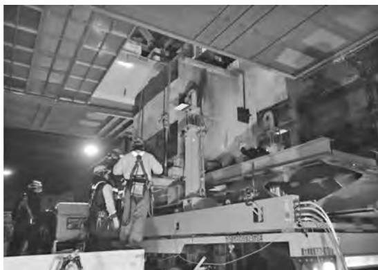
写真一6 既設橋脚の上層横梁の撤去状況
