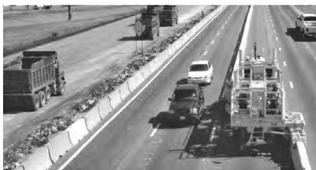
写真—3 工事車線規制運用用
