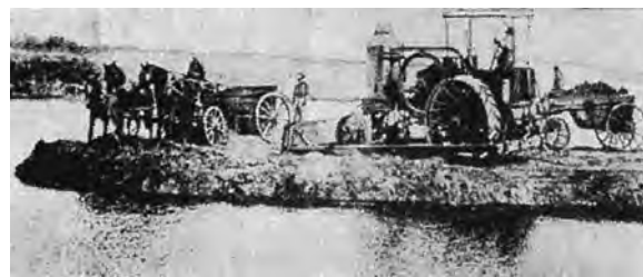
写真-13 蒸気ドーザ
