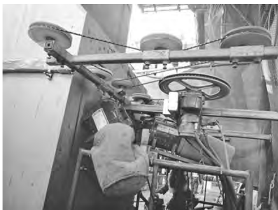
写真一7 乾式ワイヤーソーによる上層柱の切断
