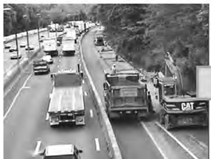
写真—6 交通量に合わせた車線規制（ニューヨーク州）
