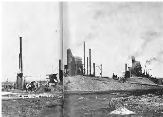
写真 2-14 高野式アスファルトプラント（2基併設）（株高野組） 兵庫県尼崎～宝塚（武庫川の河原に設置）
