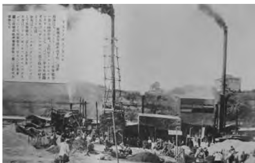
写真 2-10 新山下町プラント（日本石油道路部） 右：カンマー式 1000 yd 2 中央：ワーレン式スタンダード 800 yd 2 左：ワーレン式ポータブル 600 yd 2
