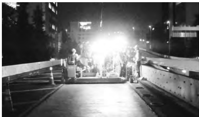
写真—14 高速1号上野線での夜間施工の様子
