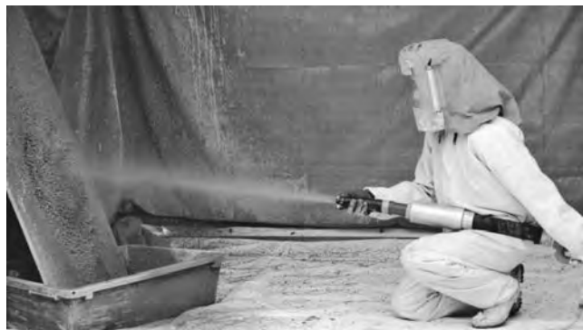
写真—3 ノズルから吹き出すモルタルの様子
