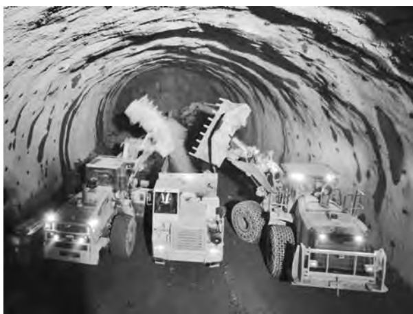
写真—2 3.5 m 3 級ホイロローダ 2 台によるずり積込
