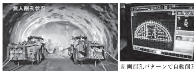
図一 2 フルコンピュータ制御ジャンボの稼働状況
