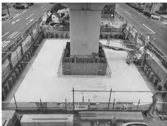
写真三 合成構造フーチングの構築完了
