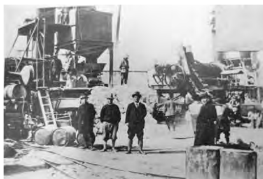
写真 2-12 横浜市山手本通りワービット舗装工事
