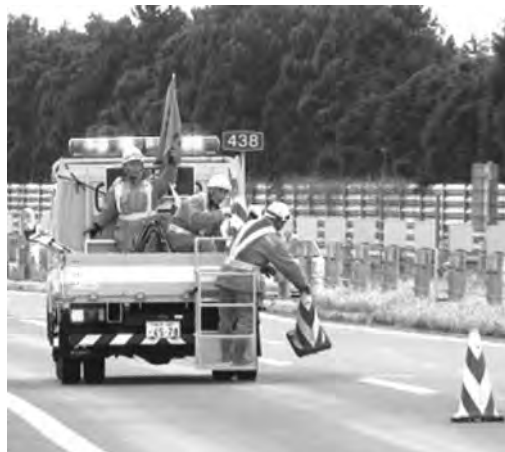
写真—1 ラバーコーンによる従来の規制状況
