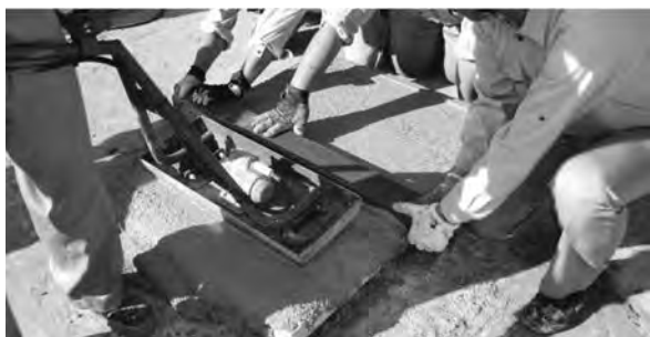
写真—10 パイブレータ+角パイプ
