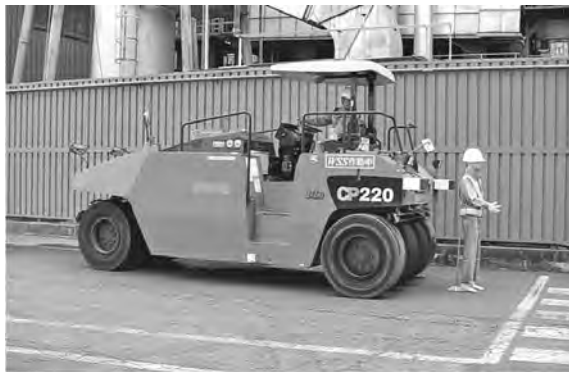
写真—6 ローラ自動停止システムの検証
