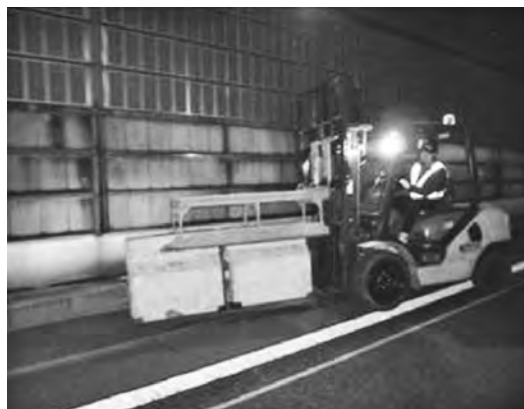
写真—7 防護ブロック設置状況
