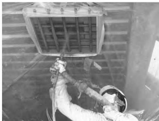
写真—1 鉄筋背面への充填性試験状況
