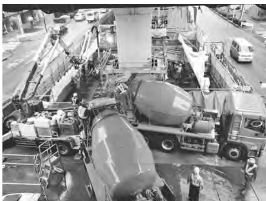
写真二 コンクリート打設状況
