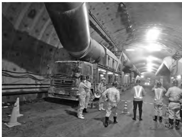
写真—5 吹付作業見学
