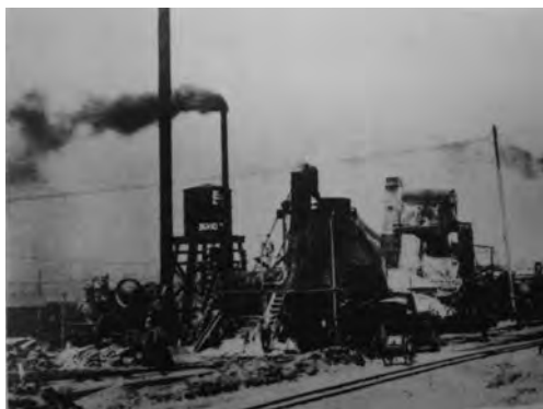
写真 2-5 イロコイス社 (米) 製 800 yd 2 プラント (日本石油道路部)
