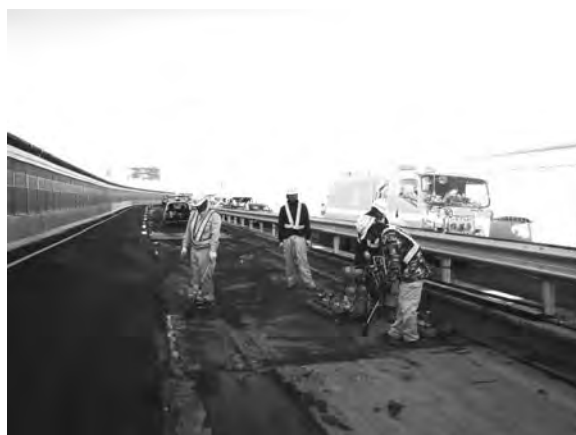
写真—2 ガスバーナを使用しての路面乾燥作業
