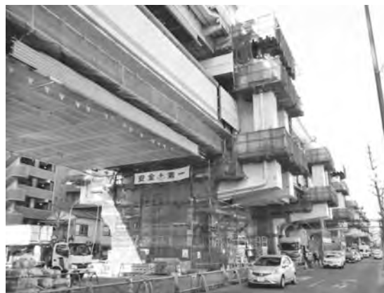
写真-5 本工法による橋脚の設置状況
