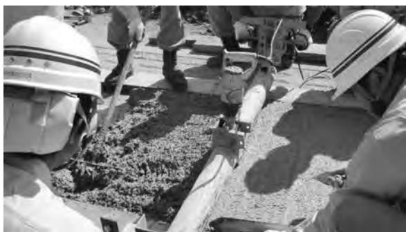
写真—11 パイブレータ付き丸パイプ
