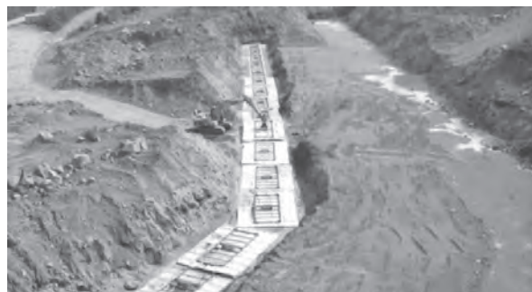
写真—2 養生マット設置状況
