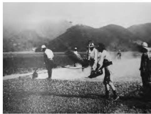
写真 2-16 ペノリシック舗装 （ペノリシック舗装：先にアスファルトモルタルを施工し、これに付着しや すいように灯油をまぶしつつ骨材を押し込む舗装 出展元：建設用語中辞典）
