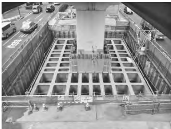
写真一 鋼製格子部材の設置状況
