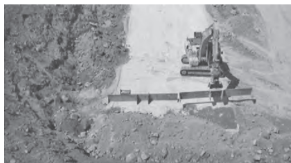
写真—1 鋼製型枠設置状況
