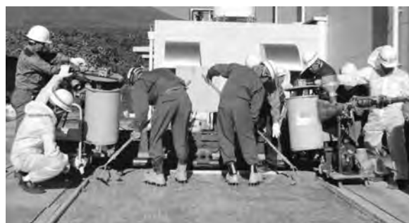
写真—7 輪荷重走行試験用試験体製作状況
