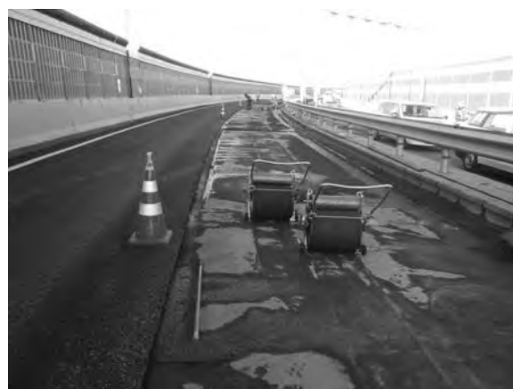
写真—1 スポンジローラを使用しての吸水作業
