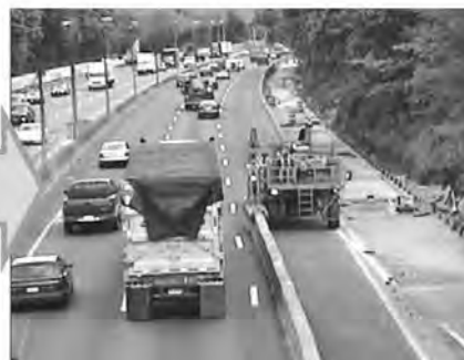
写真—6 交通量に合わせた車線規制（ニューヨーク州）
