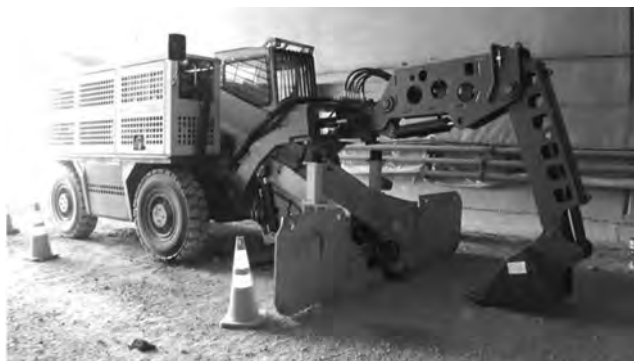
写真—3 ヘグローダ 10HR による避難坑掘削すり積込
