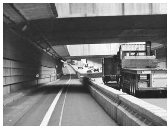
写真—12 防護ブロックによる規制状況
