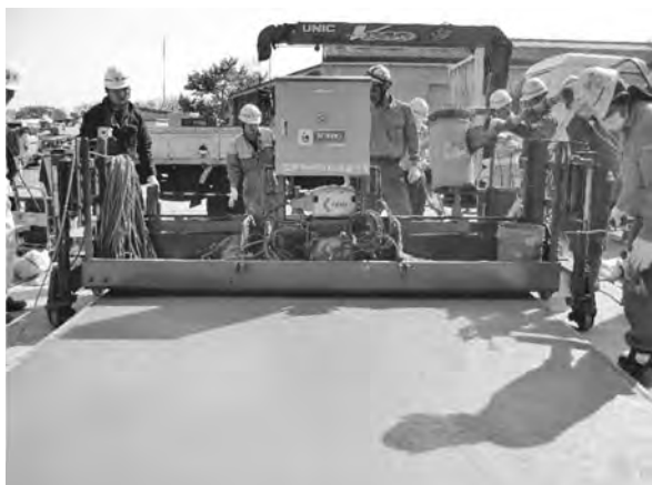
写真—12 スクリード通過後の仕上がり
