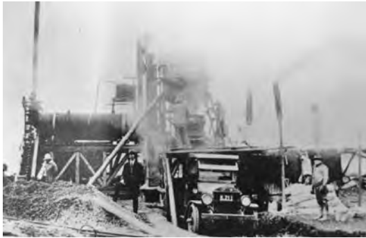
写真 2-13 静岡市両替町ワービット舗装工事 日石型（日本石油道路部）
