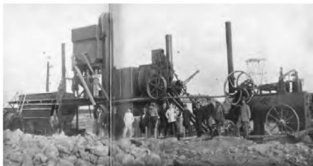
写真 2-2 カンマー社（英）製 1800 yd 2 プラント 復興局土木部道路課蔵前作業所 (高野政造氏 (株)高野組創業者：現 前田道路(株) 東京市土木局の吏員時代の写真)
