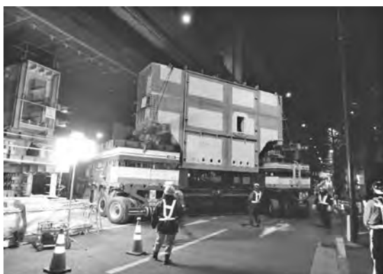
写真-4 新設橋脚の下層柱の架設状況
