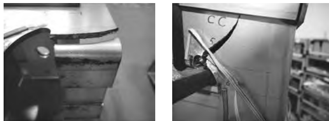
写真-10 損傷状況 (左: 曲げ加工部, 右: R部)
