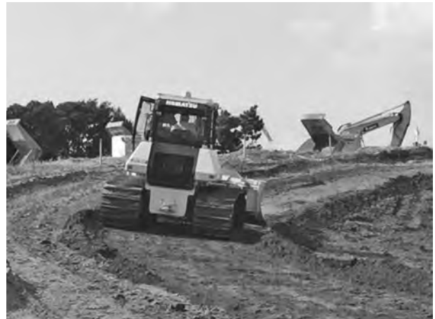
写真-2 ICTブルドーザ
