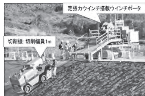
写真-1 斜面切削作業状況
