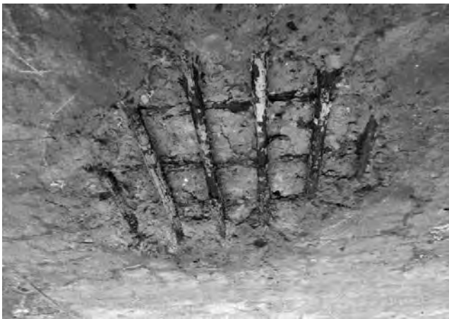
写真二 コンクリート床版の損傷
