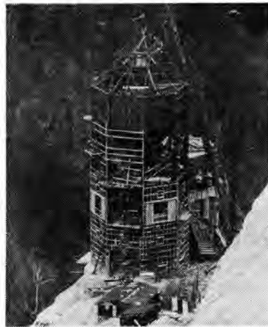
写真-2 組立中のパッチャープラント (手前が112S×4,先方が56S×4)
