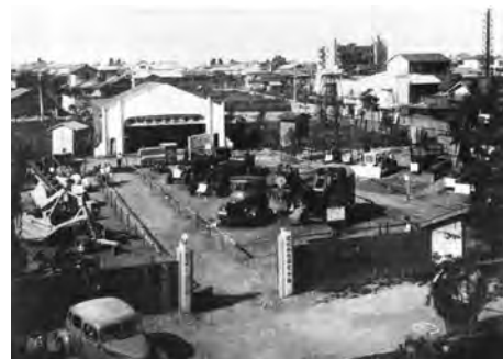
写真—14 第1回建設機械展示会 1949
