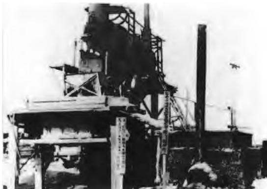
写真 2-17 熊野式アスファルトプラント 新浜アスファルト混合所 『東亜道路工業六十年史』
