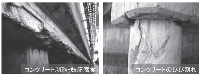
写真-1 東品川栈橋部の損傷状況
