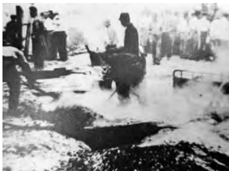
写真 2-21 アスファルト合材の鉄板練り
