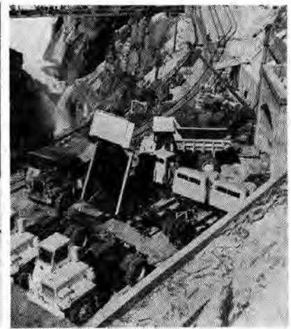
写真-3 現場で組立中のダンプトラック
