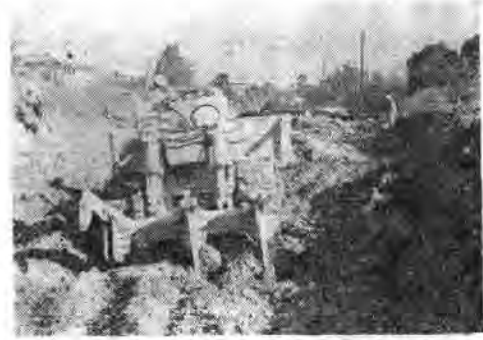
写真-6 リッパ付ブルドーザによる大田川掘削状況
