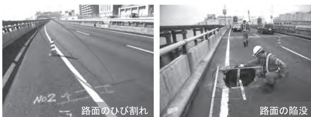
写真-2 鮫洲埋立部の損傷状況
