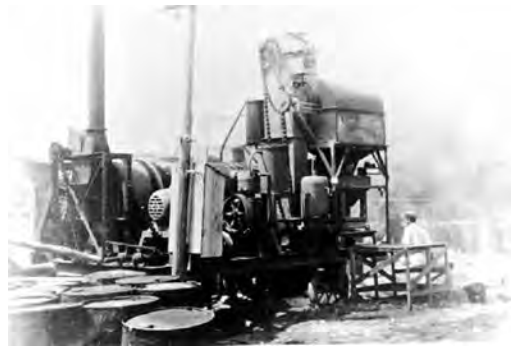
写真 2-36 東京工機製 400 yd 2 プラント 山科に設置 （東亜道路工業(株)）
