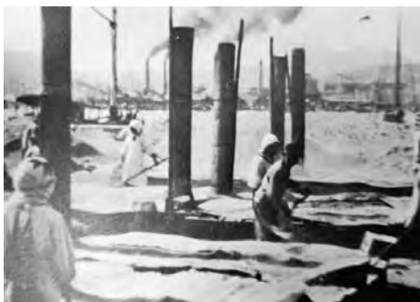
写真 2-20 骨材の鉄板乾燥 徳山町
