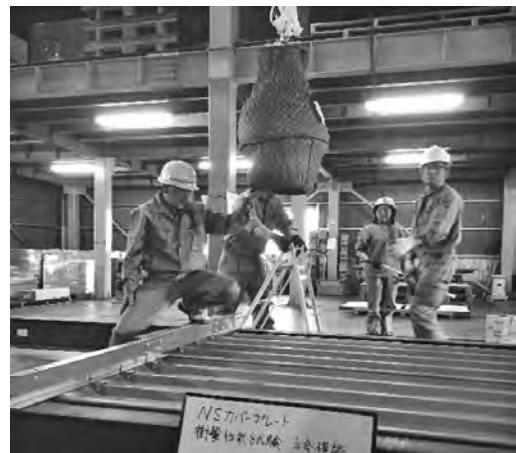
写真-6 作業員落下衝撃試験
