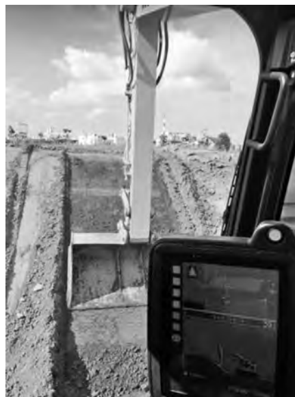
写真—5 インテリジェントマシンコントロールによる法面整形
