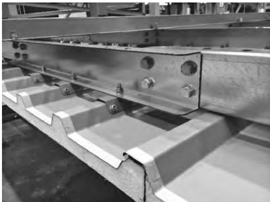
写真-5 裏面パネルの支持構造
