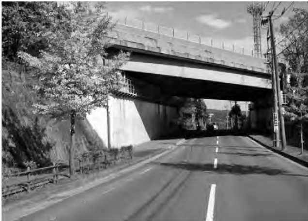
写真一 橋梁全景
