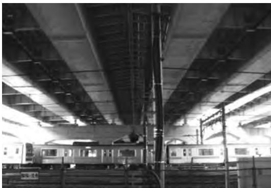
写真-1 鉄道上の鋼桁橋
