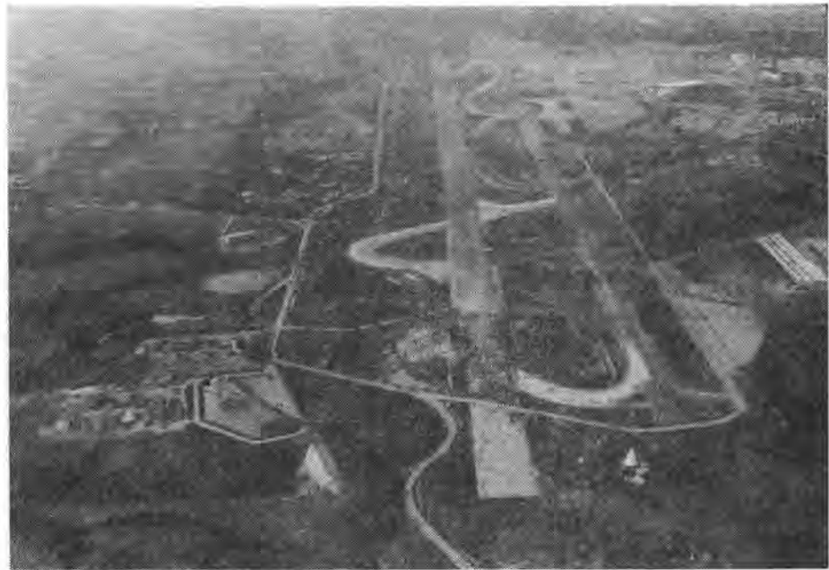
写真-1 新空港の建設状況 (昭和 46 年 11 月上旬)
