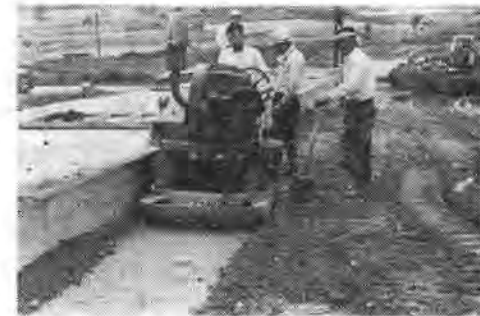
写真-3 ソイルコンパクタによる構造物裏込の締固め状況
