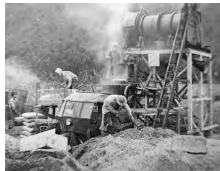
写真 2-30 杉村鉄工所製 400 yd 2 (4 ~ 6 t/h) 『世紀東急工業 40 年史』(世紀建設工業株)：現 世紀東急工業株)
