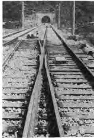
写真-2 ノーズ可動分岐器
