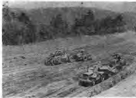
写真-5 DW-15 モータースクレーパーとタイヤドーザけん引スクレーパーの稼働状況
