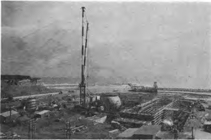
写真-4 原子炉压力容器の取込み、 据付け中 ↓ (昭和44年5月21日)
