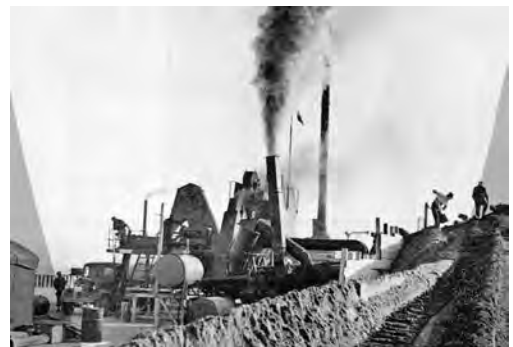
写真 2-37 バーバーグリーン社製 840-B 型 コンティニuas型 40 ton/h 『日本舗道五十年史』（日本舗道(株)）
