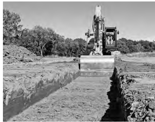
写真一 2 本改良システムを使った溝掘削
