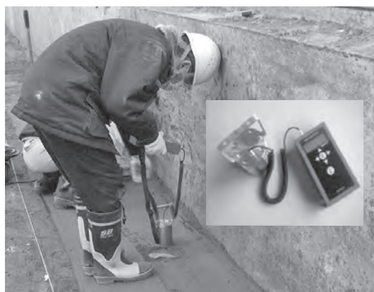
写真四 地盤剛性測定状況
