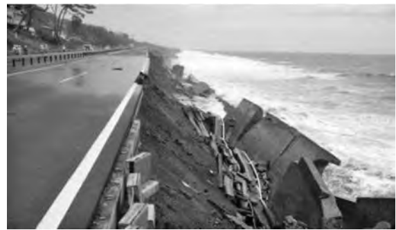
写真—6 被災時の様子 (出典：横浜国道事務所 WEB サイト 6) )
