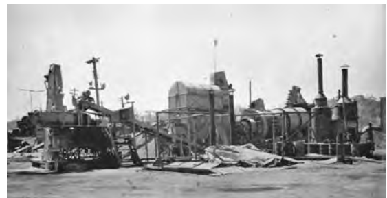
写真3-7 拜島瀝青混合所 バーバークリーン 80～100 ton/h(株高野建設)
