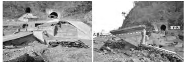
写真-3 東日本大震災における津波による被災例 3)
