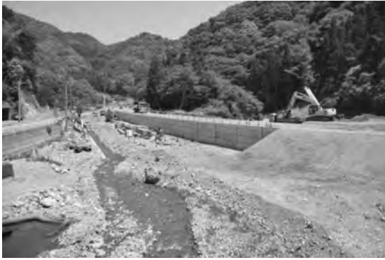
写真—5 「GRS擁壁」の施工状況 4)
