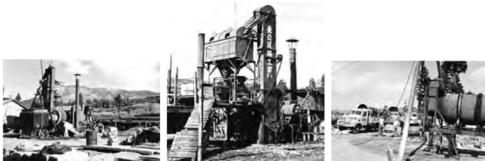
写真3-1 東京工機製 1,500yd 2 アスファルトプラント 『東亜道路工業六十年史』(東亜道路工業(株))
