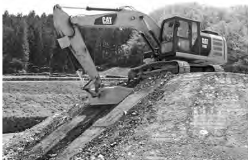
写真-1 2次元セミオートマシンコントロールシステムを搭載した油圧ショベル
