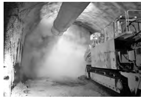
写真一6 RE-2400QDP 機械掘削の切羽の状況
