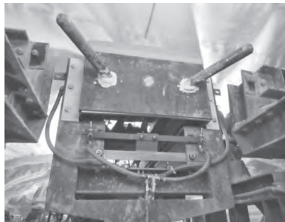
写真三 スライド式型枠先端部の圧力計とバイブレータ
