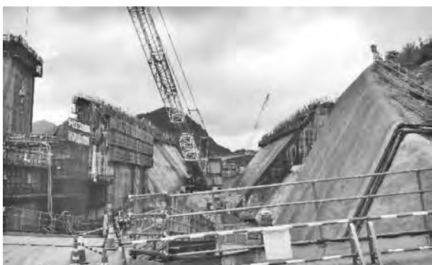
写真一九 洪水吐構築
