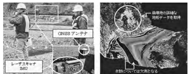
図—13 可搬式による計測事例
