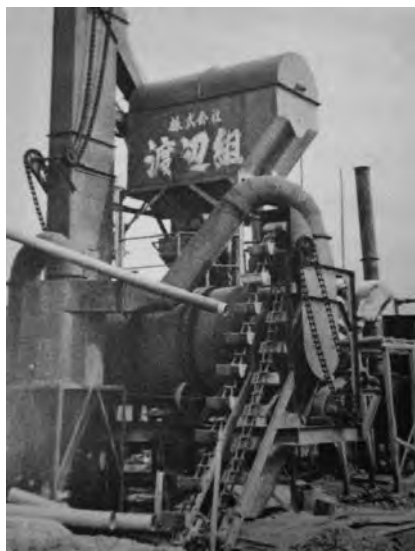
写真 3-2 1,600 yd 2 アスファルトプラント 『株渡辺組 五十年の歩み』(株渡辺組)
