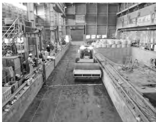
写真二 振動ローラ実験状況
