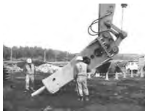
写真-4 超大型ブレーカ
