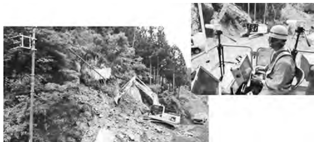
写真—1 災害復旧で活躍する無人化施工機械（玉石重機㈱提供）
