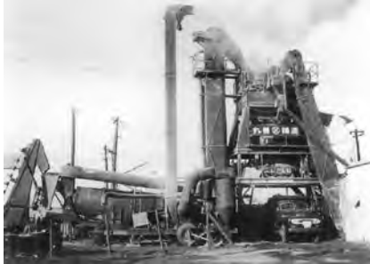
写真3-6 バーバークリーン社製 892型(日本舗道株) バッチタイプ 60 ton/h 名神高速 京都山科工区
