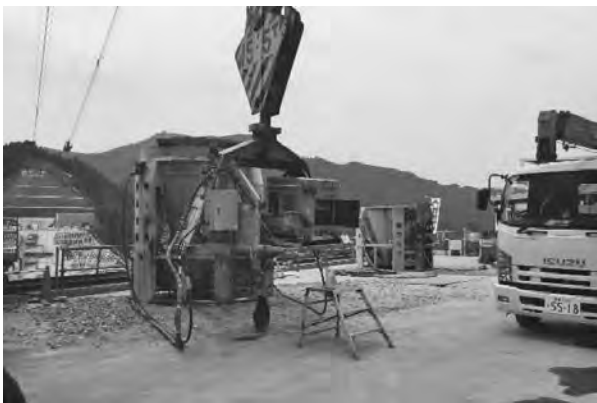
写真一 3 5.0m 3 コンクリートバケット
