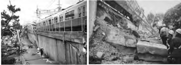
写真-1 兵庫県南部地震での従来工法の被災例 1)
