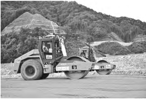
写真一 2 無人自動ローラー稼働状況
