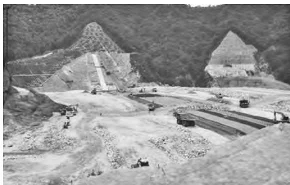
写真一 7 左岸から右岸を望む
