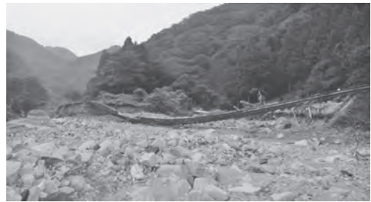
写真一四 名賀川近接部被災状況 4)
