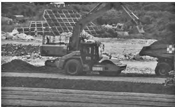
写真一八 振動ローラ自動運転
