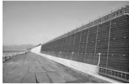
写真-7 施工(補強盛土の盛り立て)状況 5)
