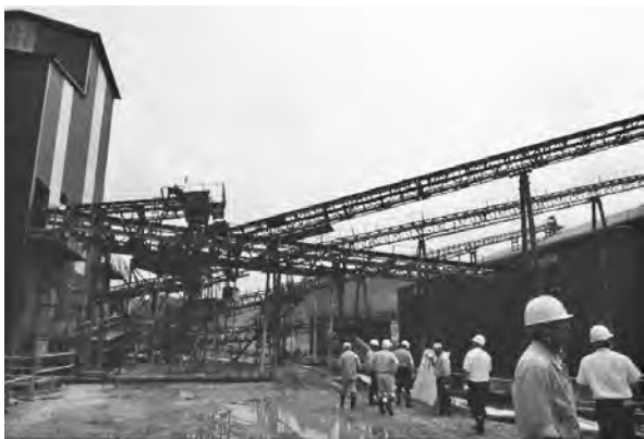
写真一 2 骨材製造設備
