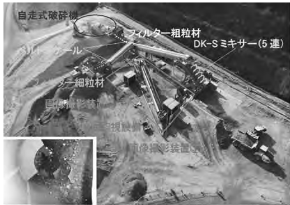
図-12 フィルター製造設備
