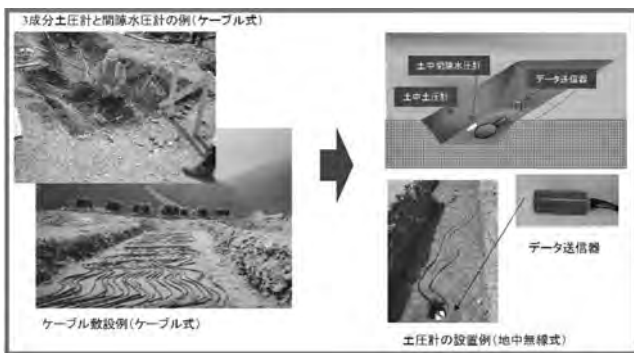
図一 9 従来設置状況→無線設置状況
