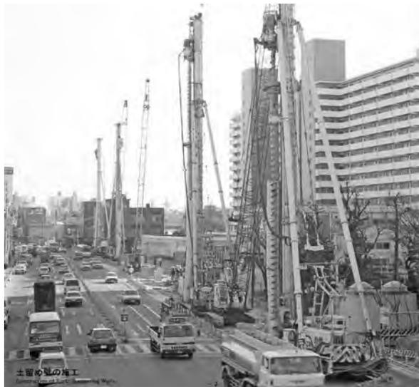
写真一 10 アースオーガによる柱列式地下連続壁の施工
