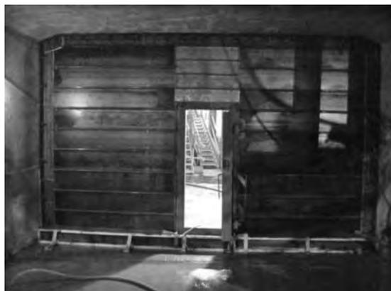
写真一4 扉付止水壁 設置状況
