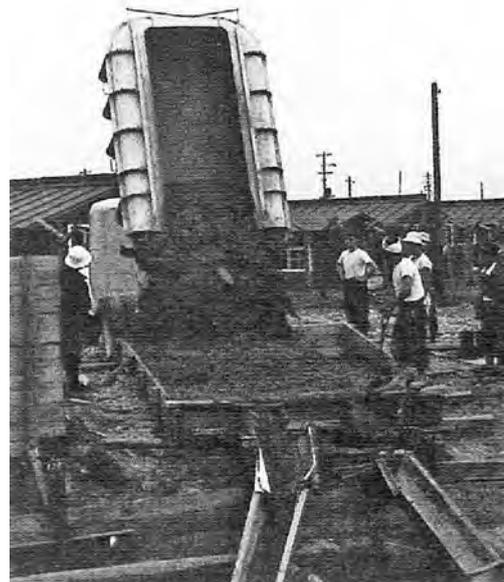
写真—7 丸ノ内線建設初期の生コン運搬車
