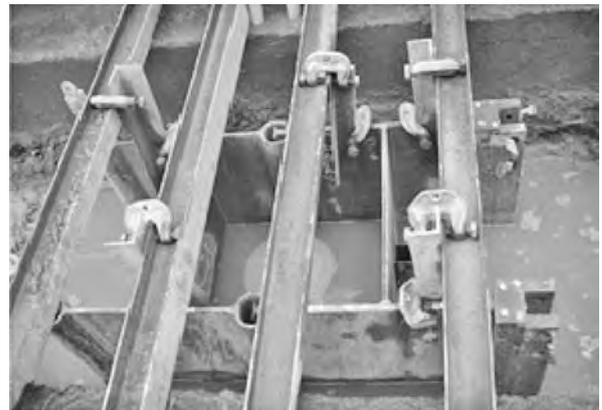
写真一〇 鋼製連壁部固定状況
