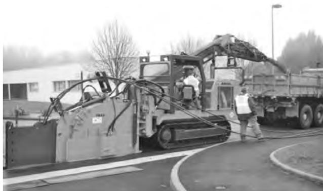
写真一 トレンチャーによるケーブル埋設状況の一例
