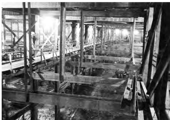
写真一 11 全面的に鋼製支保工を採用した日比谷線銀座駅の工事
