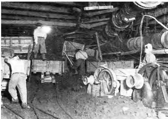
写真—6 丸ノ内線掘削工事、土工軌道と牽引用のウインチが見える
