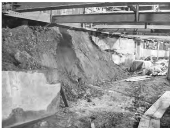
写真一6 小段掘削状況
