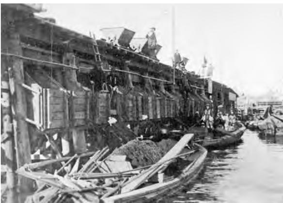
写真—3 仮設栈橋での土砂運搬、栈橋設備はほとんど木製である
