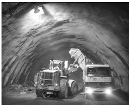
写真—1 貯槽アーチ部の掘削状況
