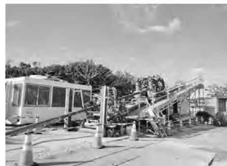
写真-2 水平掘削機設置状況
