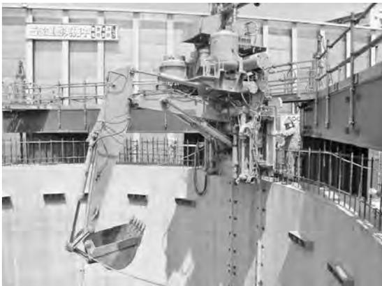
写真—1 水中掘削機 全景
