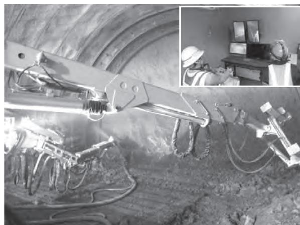
写真-2 遠隔操作による吹付け状況
