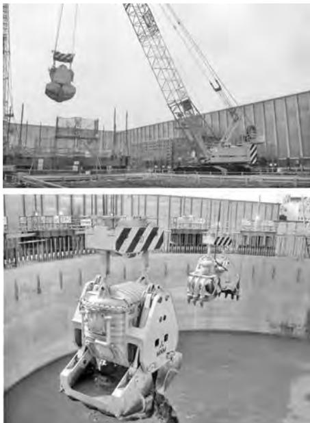
写真一7 掘削揚土クレーンと電動油圧グラブ
