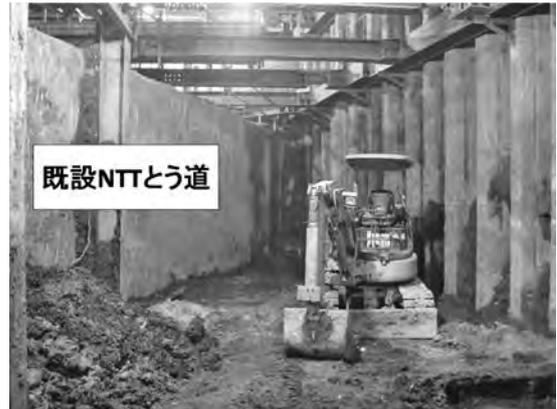
写真-1 既設NTTとう道(掘削時)
