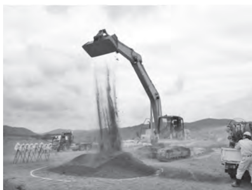
写真一 4 バックホウ作業時の噴霧状況
