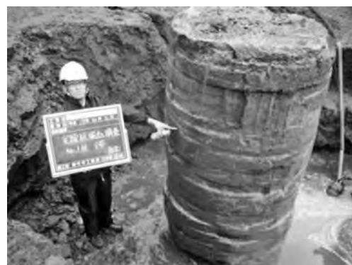
写真—2 本セメントを用いた場所打ち杭の例
