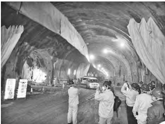
写真—4 現場見学状況
