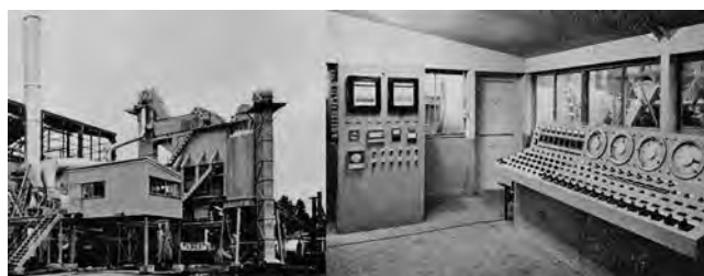
写真 3-49 NP-2000 遠隔自動制御盤
