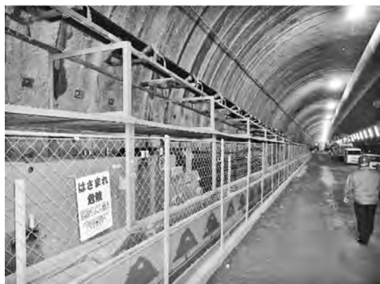
写真—9 移設したベルトコンベア
