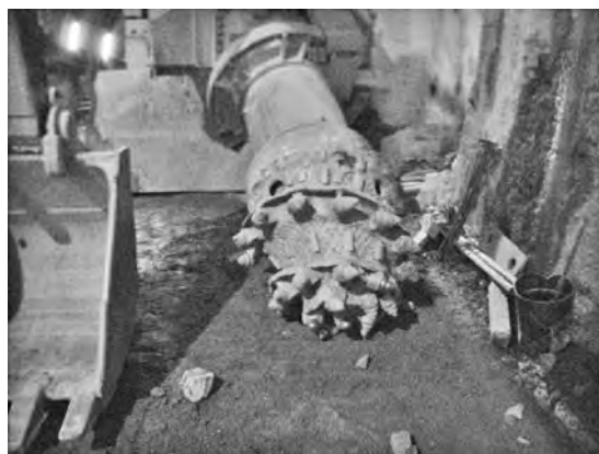
写真一 全断面掘削機のビット
