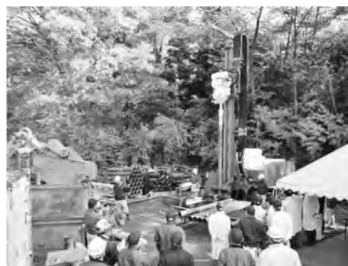
写真—3 自動掘削テスト状況 (2016.10.28)
