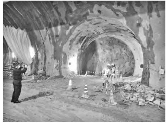
写真—5 避難連絡坑切羽
