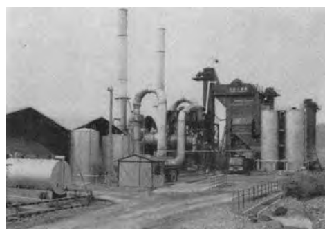
写真 3-60 昭和 48 年中国縦貫道滝野舗装工事
