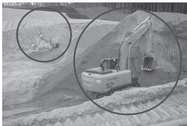
写真—2 バックホウの稼働状況 (B 現場)
