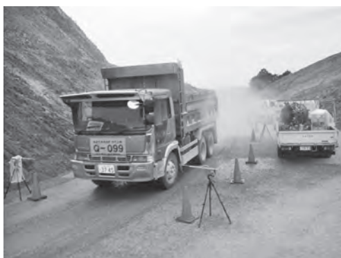
写真一 5 ダンプ走行時の噴霧状況
