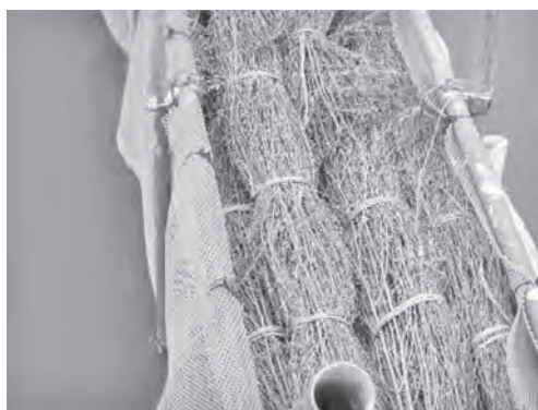
写真一3 竹粗朶（沈砂池内設置状況）
