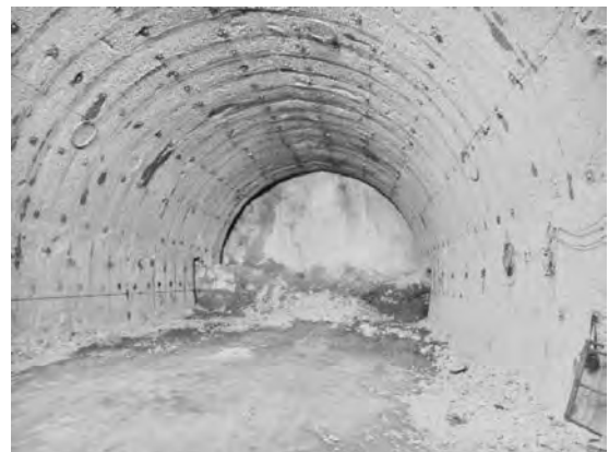
写真—7 下り線東側本坑切羽
