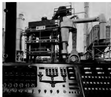
写真 3-62 CNAP-1000 + IC ロジック制御盤
