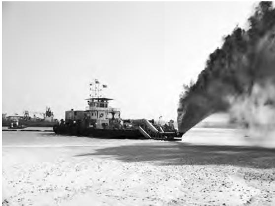
写真—2 埋立砂散布状況
