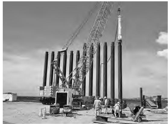
写真—7 鋼管矢板打設状況
