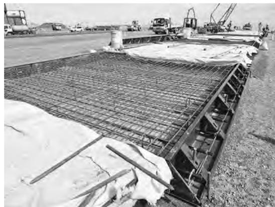
写真—16 舗装用型枠
