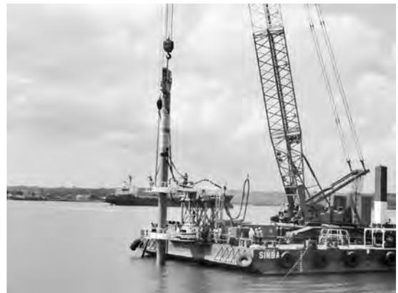
写真—4 鋼管杭打設状況
