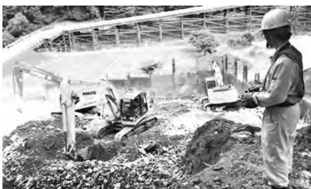
写真一1 バックホウの遠隔操縦による無人化施工
