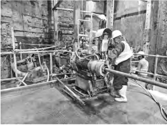
写真一 水平 JGP 施工状況
