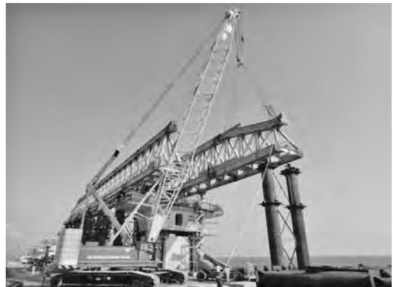
写真-13 架設桁組立
