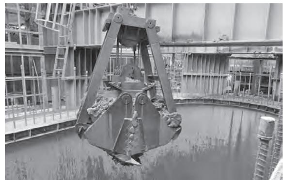
写真一3 クラムシェル型0.8m<sup>3</sup>級バケット
