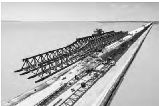
写真一 4 2 列のトラス構造の架設桁
