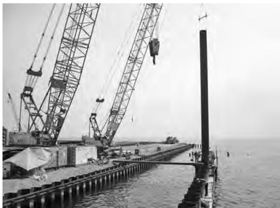
写真一 鋼管矢板打設状況
