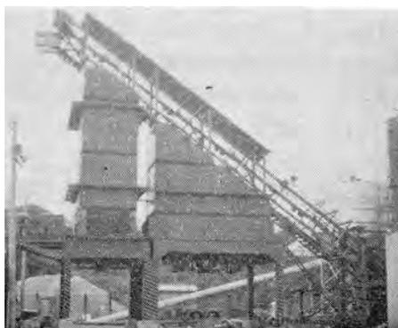
写真 4-14 合材貯蔵積出装置
