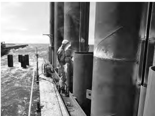
写真—6 鋼管矢板溶接状況
