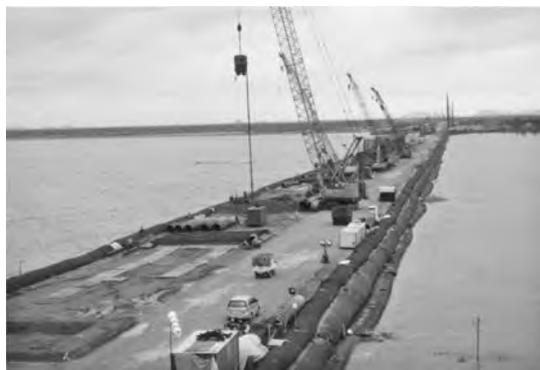
写真一 ジオチューブによるアクセス道路
