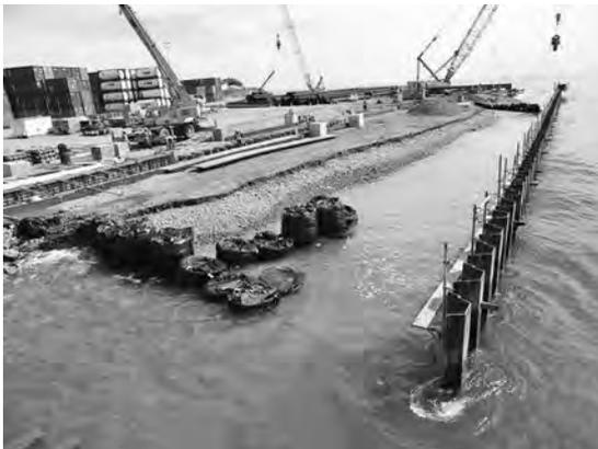
写真—5 仮鋼矢板壁打設状況
