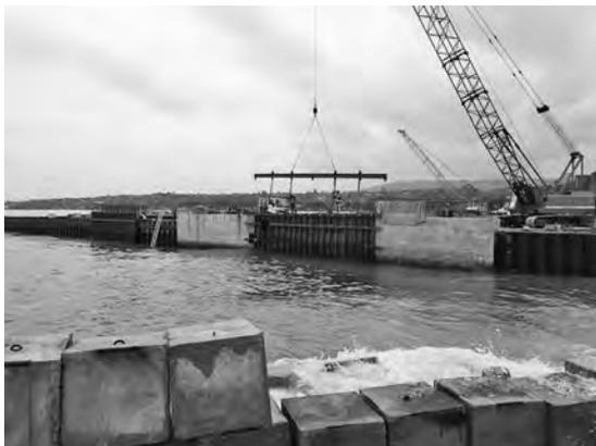
写真一9 型枠設置状況
