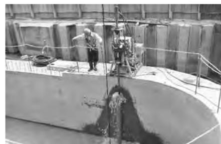
写真一6 高圧水による刃口洗浄
