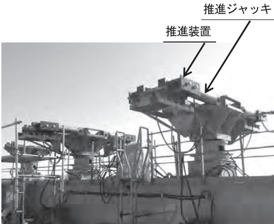
写真-10 架設桁支持台上の推進ジャッキと推進装置
