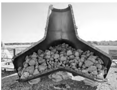
(a) 消波ブロック（プレパッキング工法）
