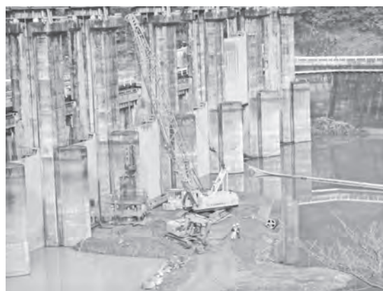
写真—1 オールケーシング掘削状況 (全景)
