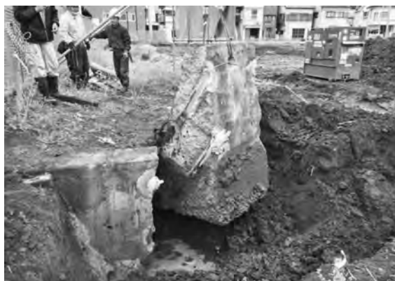
写真—2 解体した擁壁の撤去状況
