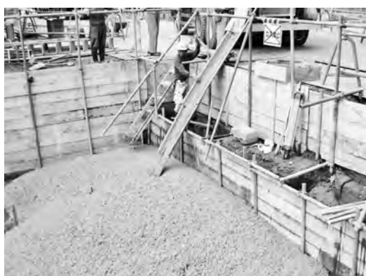
写真一3 本流動体の打設状況
