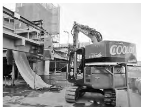
写真ー7 大梁の切断状況
