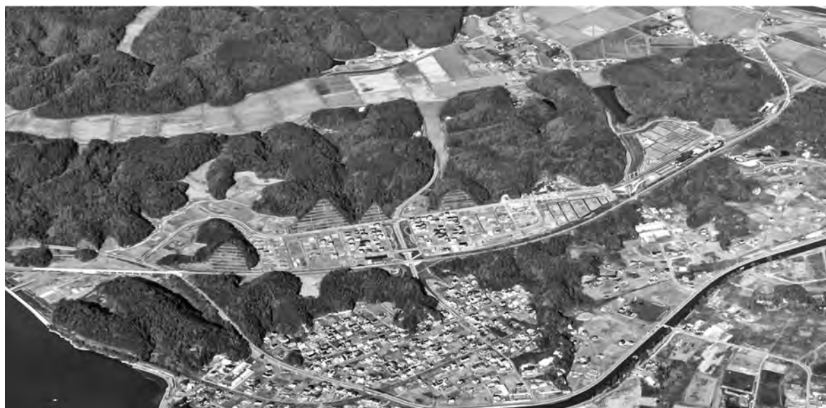
写真—1 松島湾側から見た全景
