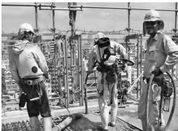
写真—1 バックパック式バイブレータ
