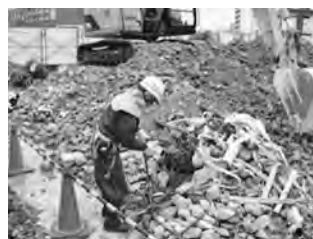
解体工事での選別作業
