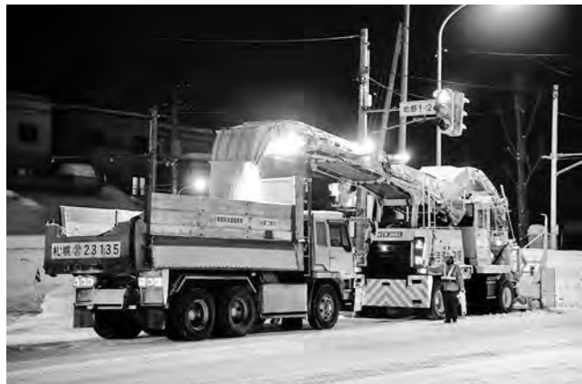
写真一 2 運搬排雪の様子
