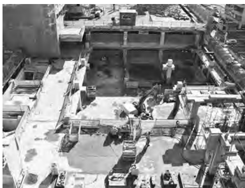
写真—1 本工法適用による解体状況
