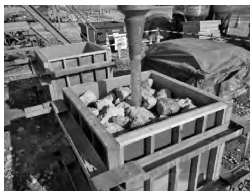
写真—7 ブロックの作製状況 (プレバッキング工法)
