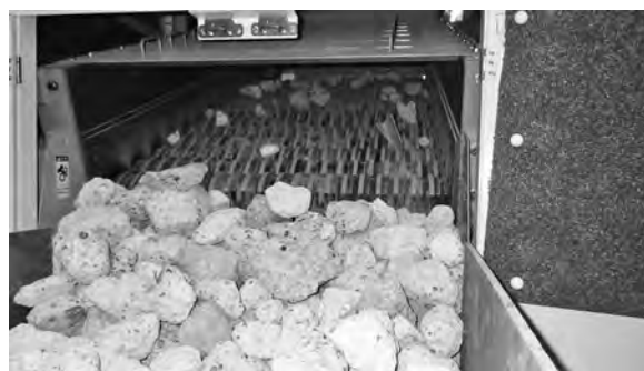
写真—3 ロールスクリーンから排出されたコンクリート塊
