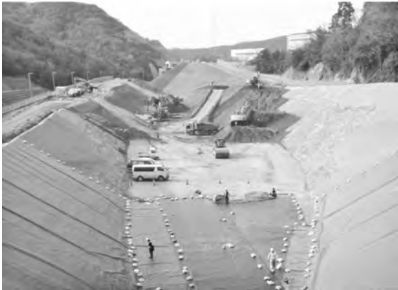
写真―3 遮水層施工状況
