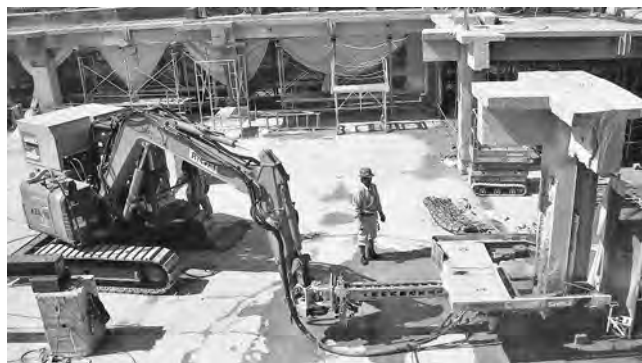
写真—9 柱の切断
