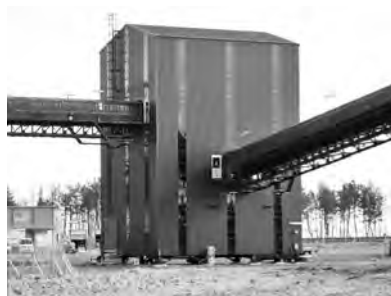
ベルトコンベヤカバー及び乗継部の建屋
