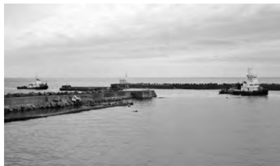
写真—2 施工状況（2F → 1F 土運船海上運搬）
