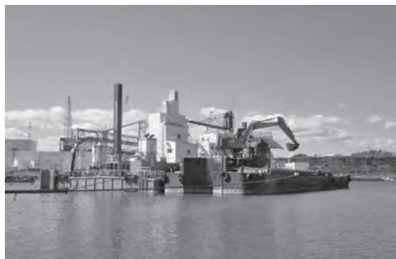
写真—3 施工状況（1F 固化材供給船，圧送）
