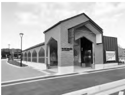
写真—13 階段室上屋
