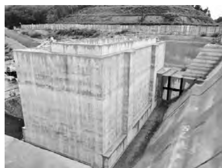
写真一12 階段室躯体
