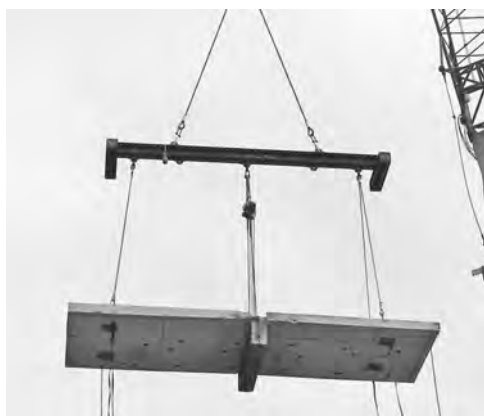
写真ー6 床版の吊上げ
