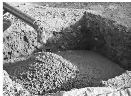
写真一九 配管打設の状況
