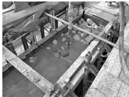
写真一八 防潮堤でのモルタル注入状況
