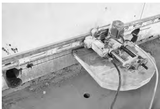
写真—3 ウォールソー (壁切断)
