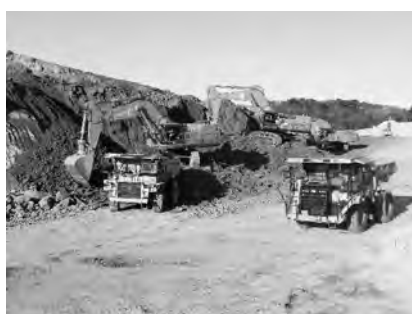
写真—2 大型重機による掘削・積込・運搬状況
