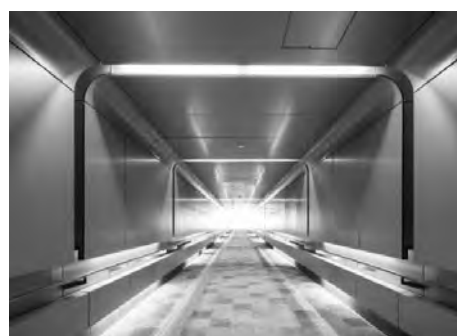
写真一11 ボックスカルバート内装
