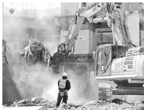
写真—2 従来の破碎による解体作業の状況
