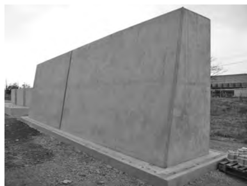
写真一九 防潮堤の完成後外観
