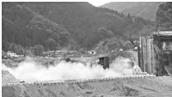
写真— 4 P2 倒壊発破 倒壊の瞬間
