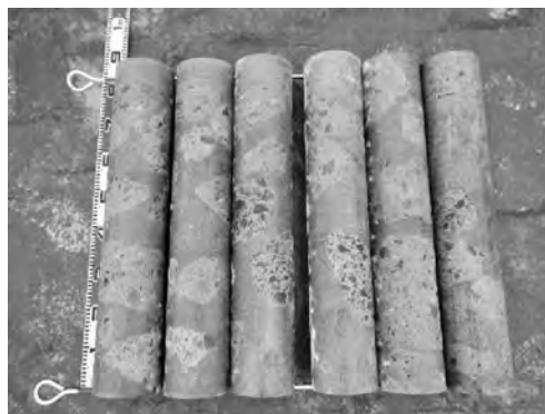
写真—5 試験用ブロックより採取したコア供試体 (プレバッキング工法)
