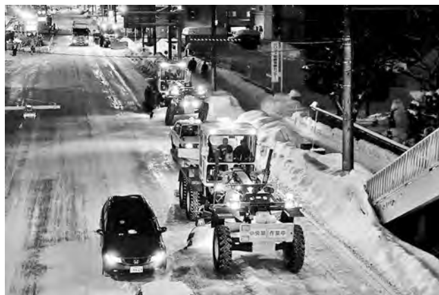
写真一 3 路面整正の様子
