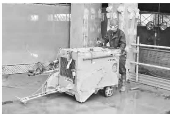
写真ー5 道路カッターによる床版切断
