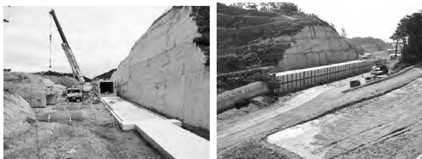
写真一9 ボックスカルバート設置
