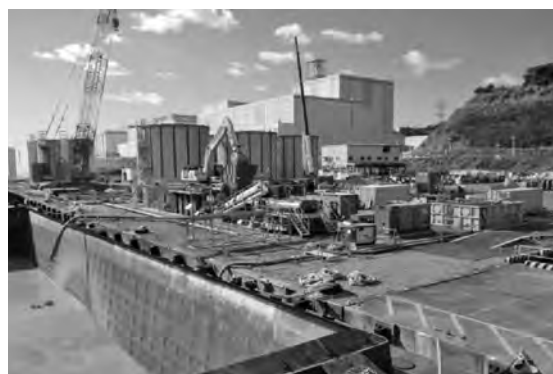
写真—1 施工状況（2F サンドスラリー製造プラント）
