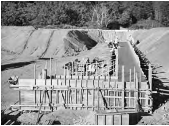
写真―4 雨水排水管
