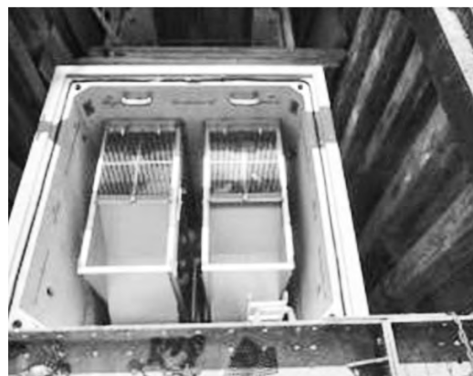
写真—2 ゴミ除去フィルター設置状況
