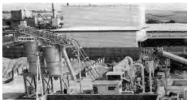
写真 5-12 アスファルト・リサイクルプラント
