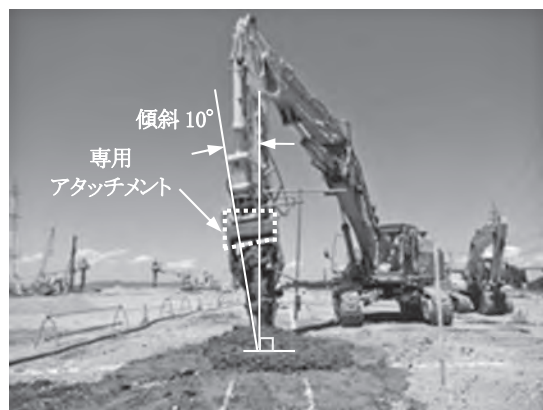
写真—1 ソイルセメント壁の造成状況
