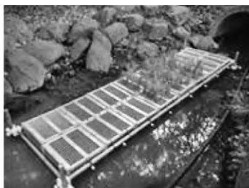
写真一 3 礫間接触酸化槽の設置状況
