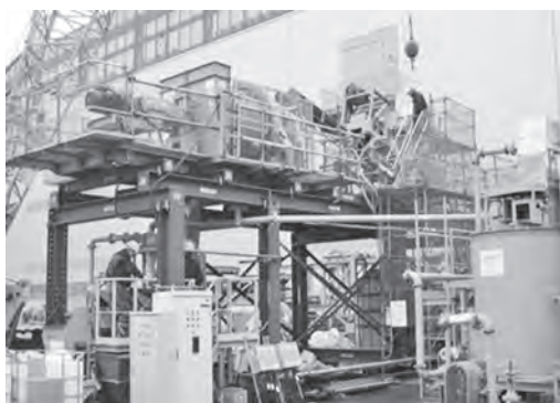
写真—2 粉碎分級設備
