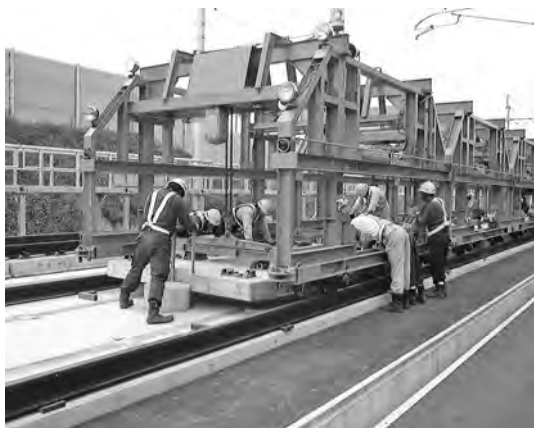
写真一 2 スラブ運搬敷設車
