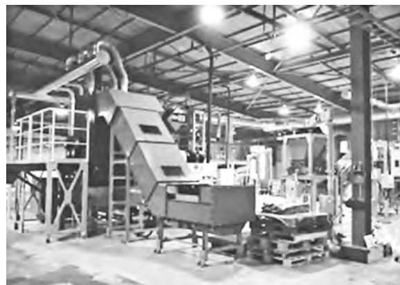
写真—1 破砕・選別設備の外観
