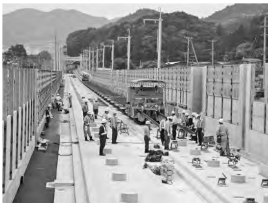
写真一 1 レール送込み装置車
