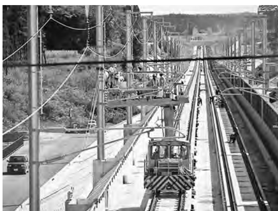
写真—12 張力調整装置取り付け
