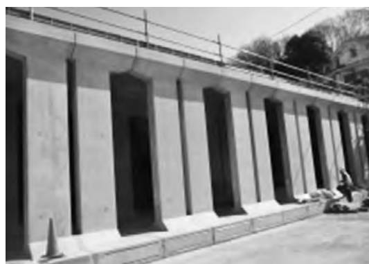
写真—1 プレキャスト貯留施設施工状況
