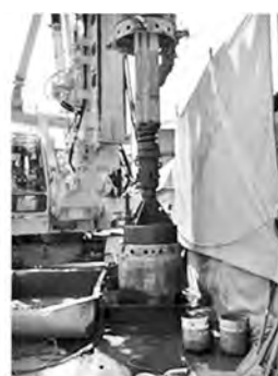
(b) ケーシング掘削
