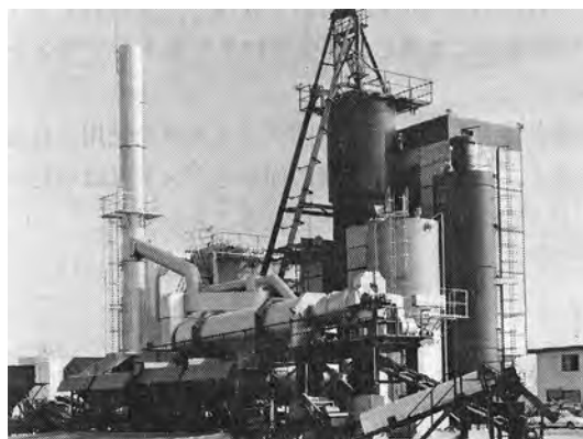
写真 5-4 TRD30 再生アスファルトプラント
