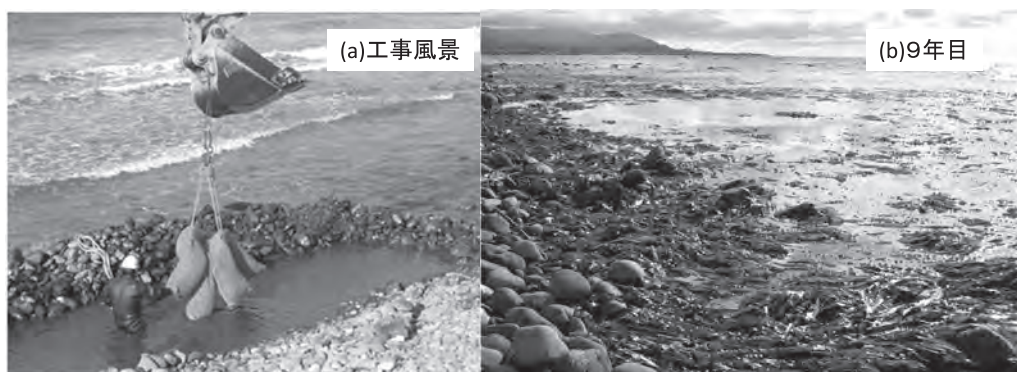
写真—3 鉄分供給ユニットの施工事例 1)
