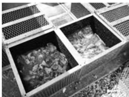
写真一 2 カキ殻充填状況
