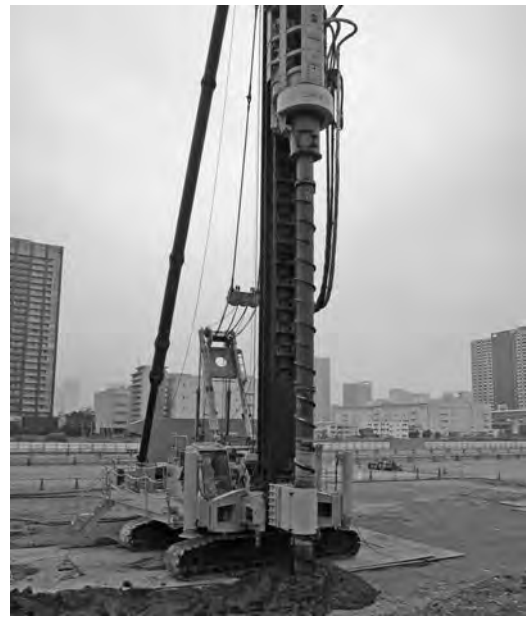
写真-2 施工全景
