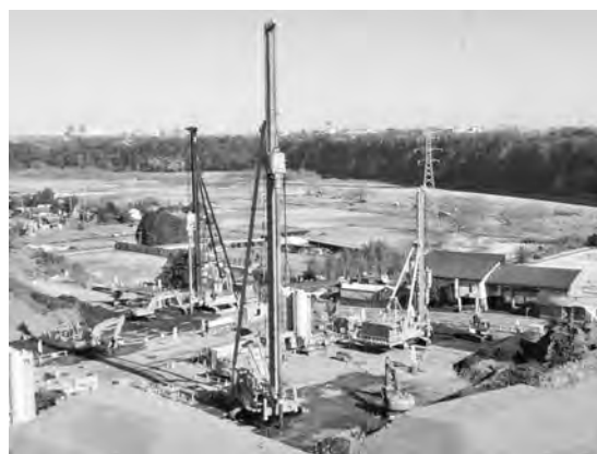
写真一2 国内建設現場(手前:本機種, 奥側:従来機種×2台)
