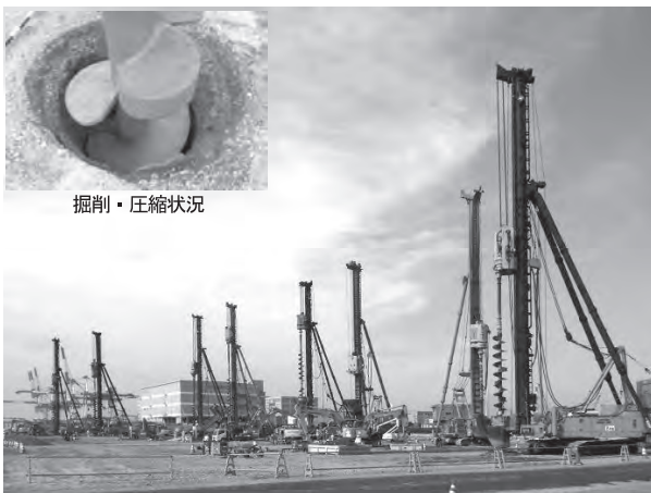
写真一1 本工法の施工状況 (南本牧)
