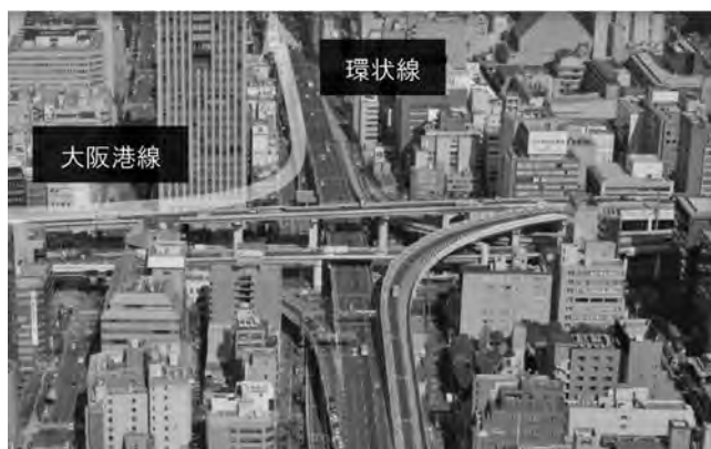
写真—1 西船場 JCT の事業箇所
