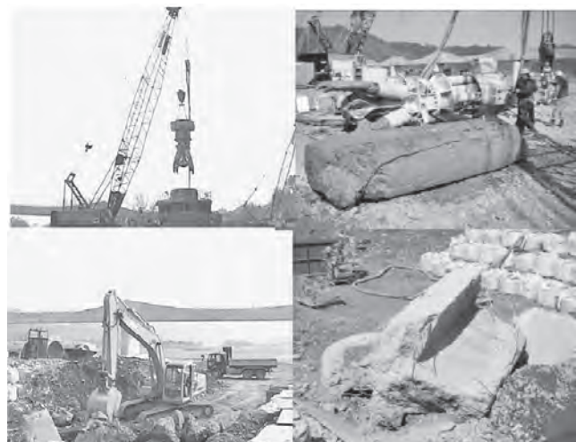
写真-15 装置構成(左上) 圧砕片集積状況(左下) 多様な圧砕片1(右上) 圧砕片2(右下)
