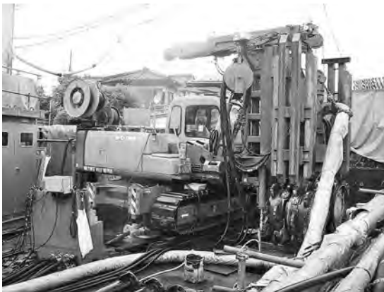
写真一九 直打式施工
