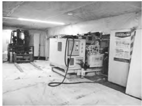
写真一 4 スライドジャッキを利用した自走
