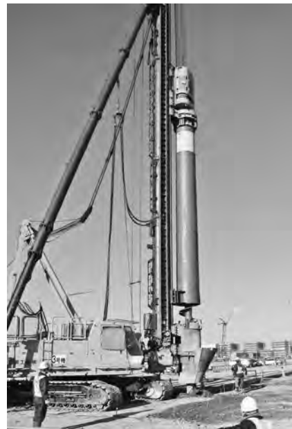
写真—5 鋼製スライド風管
