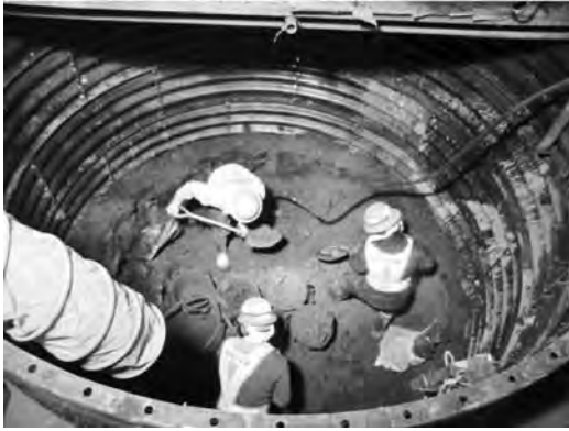
写真-1 深礎工法
