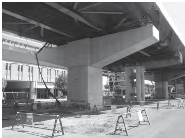
写真一八 再構築橋脚
