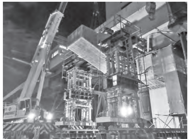
写真—7 切断ブロック搬出作業
