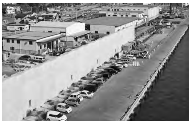
写真一四 施工スペースが限られた地域での防波堤構築 (岩手県宮古港鉾ヶ崎地区)
