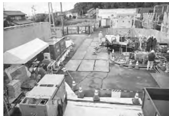
写真—6 実施工検証試験の状況
