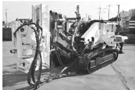
写真一 1 超低空頭型本工法施工機全景
