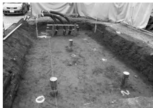
写真—8 鋼管杭打設完了状況
