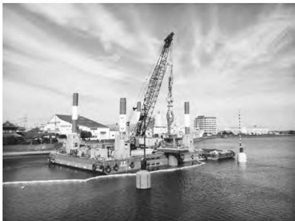
写真—17 SEP上から実施する本工法
