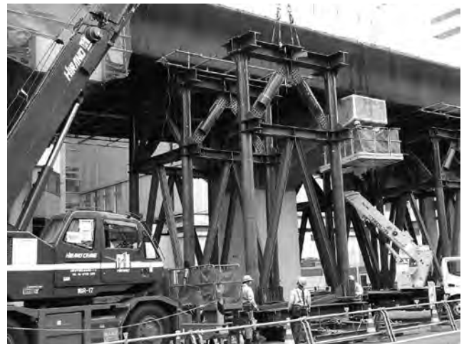
写真—4 仮受け構造地組状況
