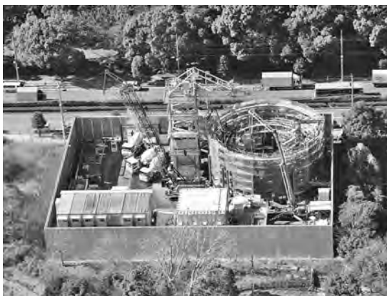
写真一 立坑構築状況全景
