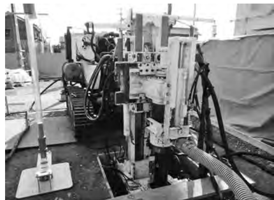
写真—7 鋼管杭削孔状況
