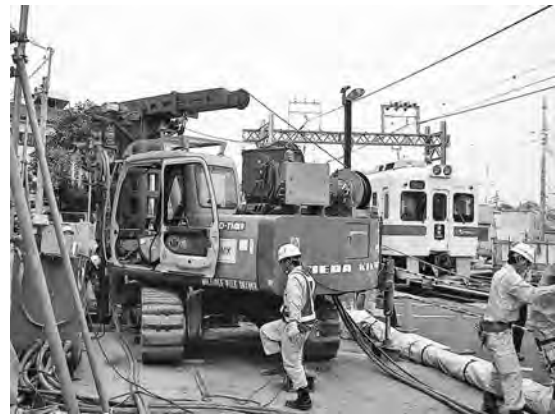
写真一〇 斜打施工 姿写真
