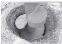
掘削・圧縮状況
