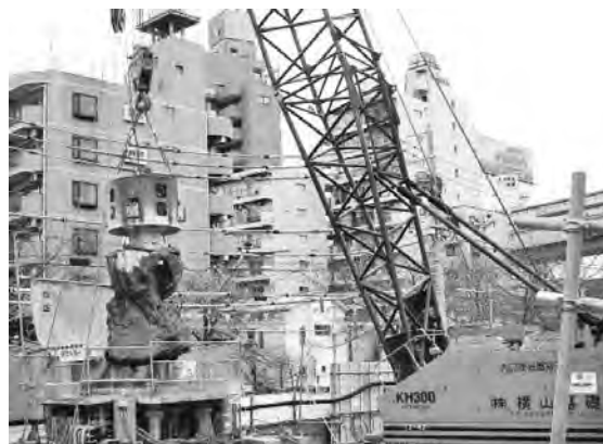
写真一 7 油圧グラブによる障害物の排出状況
