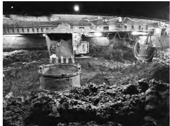
写真一 3 作業室内掘削状況
