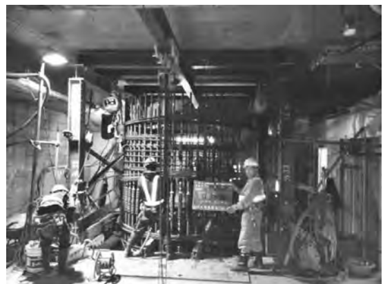
写真一 7 鉄筋かごの吊り込み状況
