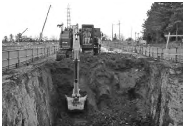
写真-3 土留め内部掘削
