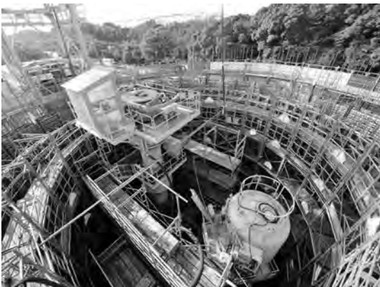
写真一 2 立坑構築状況
