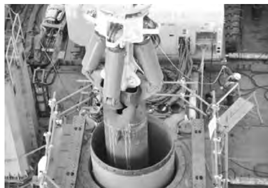
写真一 8 本工法施工機による鋼管杭引き抜き状況
