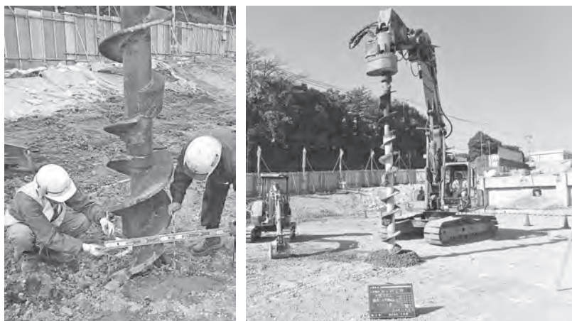
写真一8 締固め施工状況
