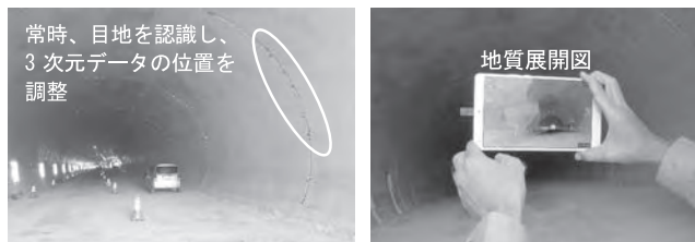
写真-3 空間認識技術 写真-4 3次元データの出力表示
