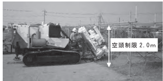
写真一3 施工機移動状況
