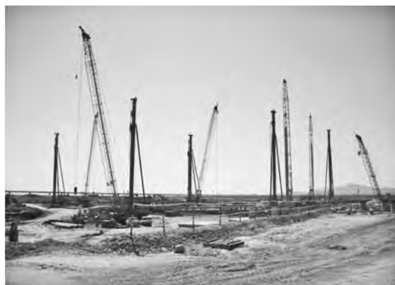
写真一1 韓国(仁川) カジノ建設現場
