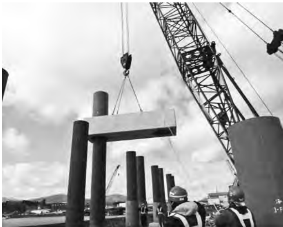
写真一 2 底版ブロック据付状況 (宮城県気仙沼港)
