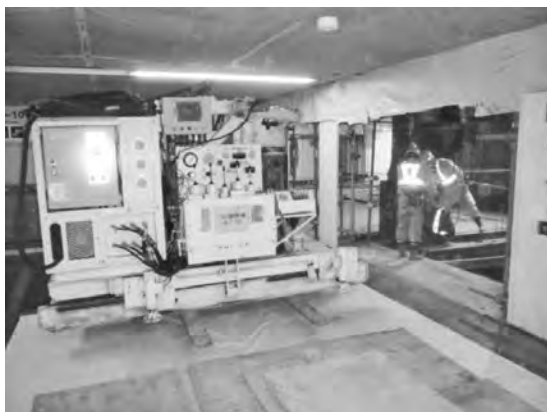
写真一 3 フォークリフトによる超低空頭機運搬
