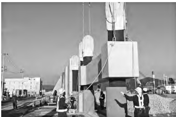
写真一 3 防波版ブロック据付状況 (宮城県気仙沼港)
