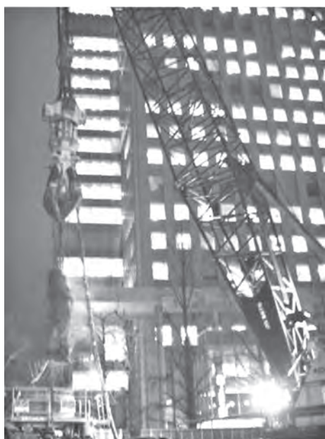
写真-13 本工法施工機の夜間施工
