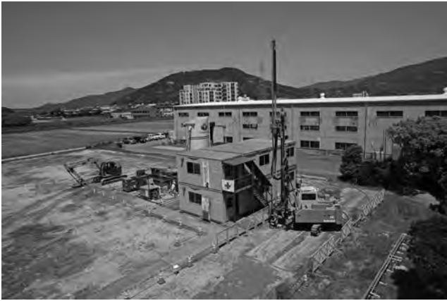
写真—1 試験施工状況
