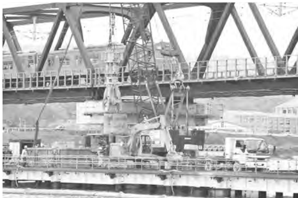
写真—16 旧鉄道橋基礎撤去工事
