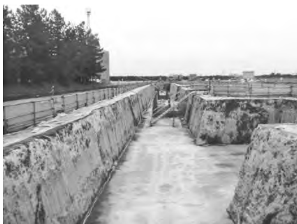
写真-4 掘削・均しコンクリート打設完了
