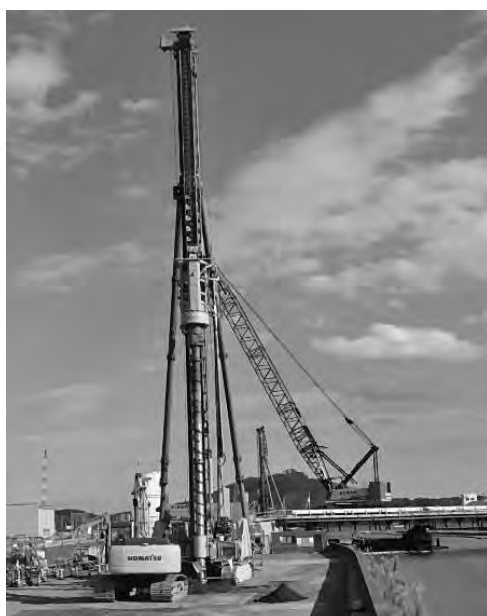
写真一四 施工全景
