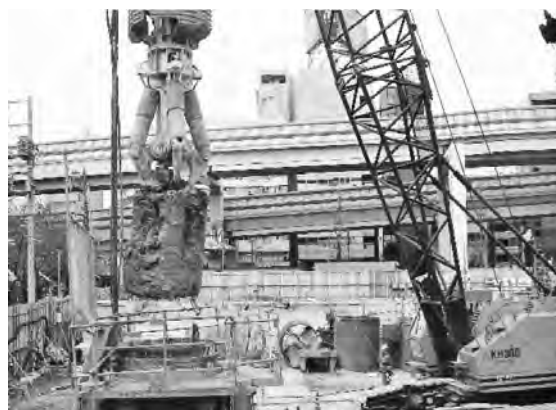
写真一 6 本工法施工機による障害物の排出状況
