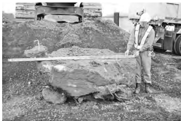
写真一11 撤去された2mを超える鉄筋コンクリート
