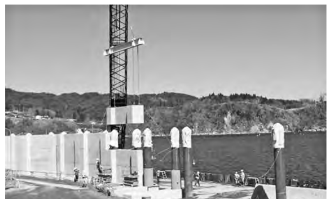
写真一五 作業用足場を用いない防波版の据付状況 (宮城県気仙沼港)
