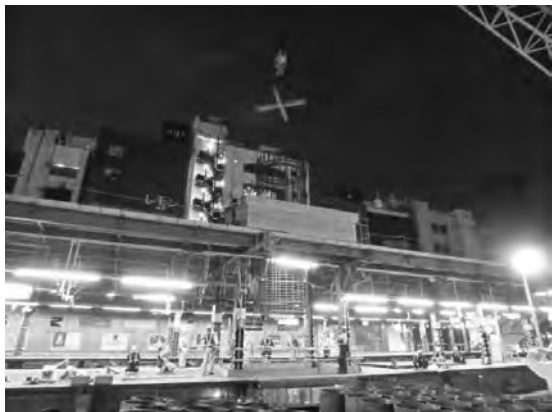
写真一 10 鉄筋かごの吊り込み状況
