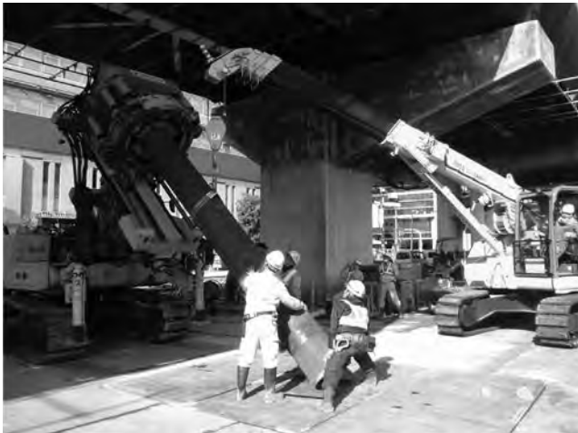
写真—3 鋼管杭取り込み状況
