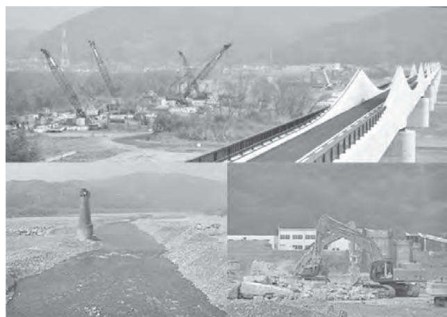
写真-14 某河川内の旧橋脚撤去の現場
