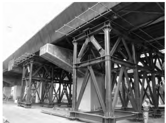
写真—5 鋼製仮受け構造完成
