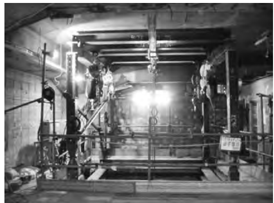
写真一 6 吊り込み架台
