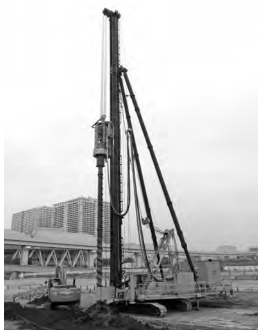
写真-1 施工機全景
