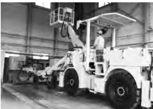
写真—6 ドリルジャンボ 試験削孔状況
