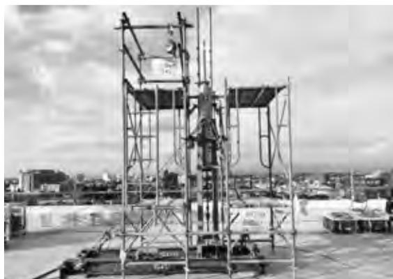
写真—4 上部吊上げ装置
