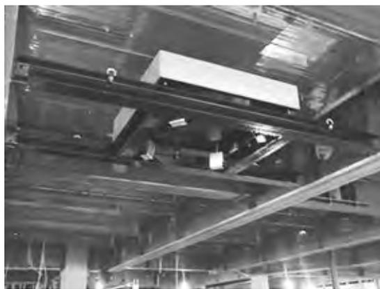
写真-1 床振動制御用動吸振器の例
