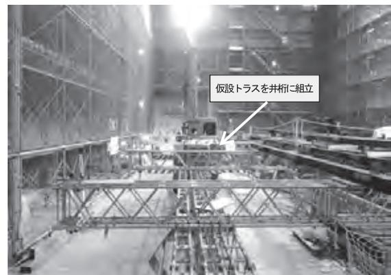
写真-1 仮設トラス、スノコ天井地組状況
