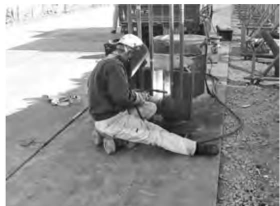
写真一四 杭頭接合筋の溶接
