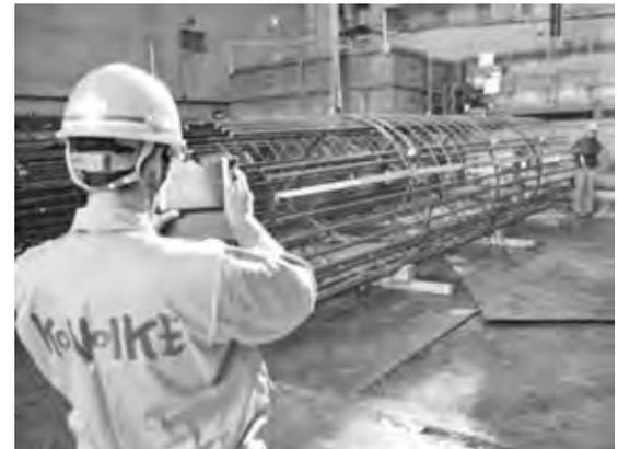
写真—2 場所打ち杭配筋写真撮影状況
