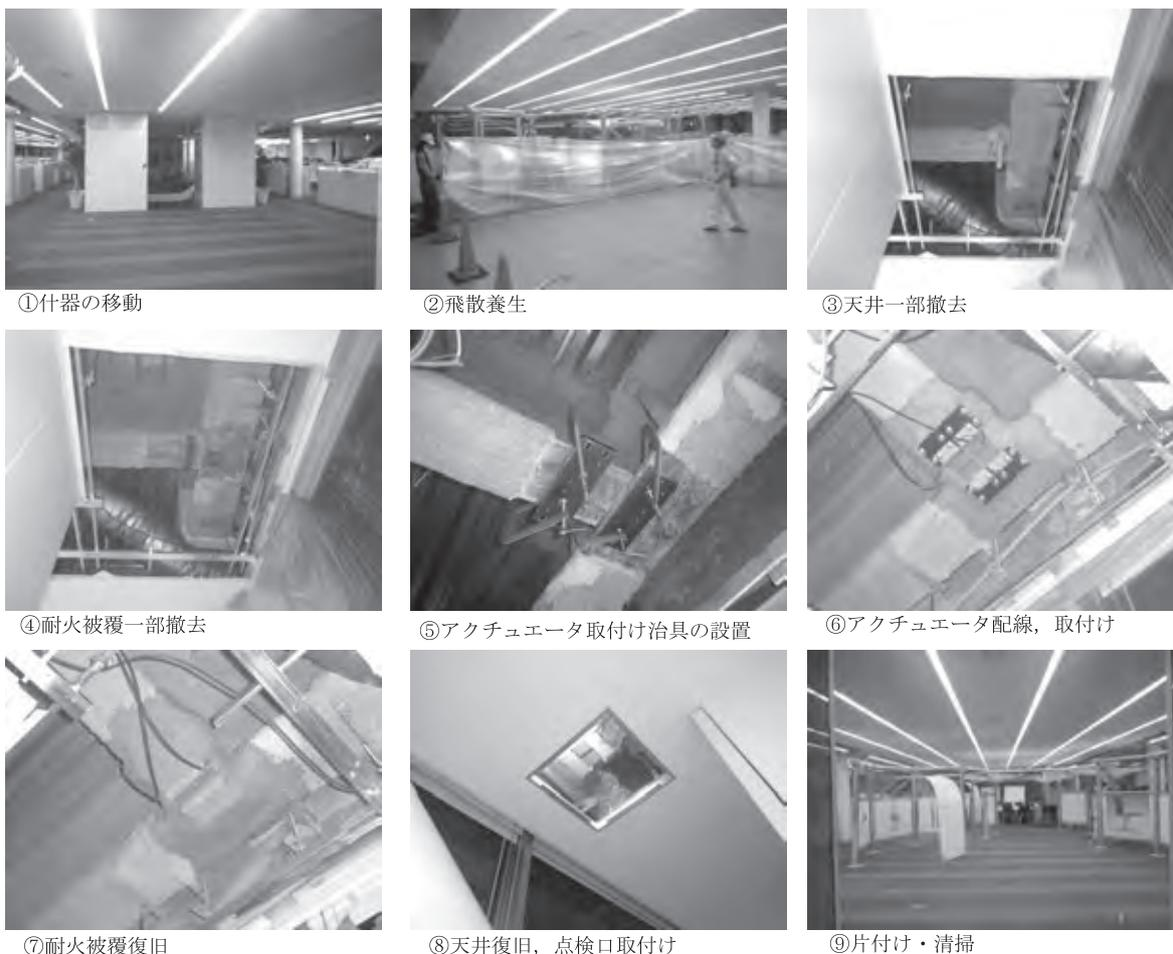
図一六 施工状況の例
