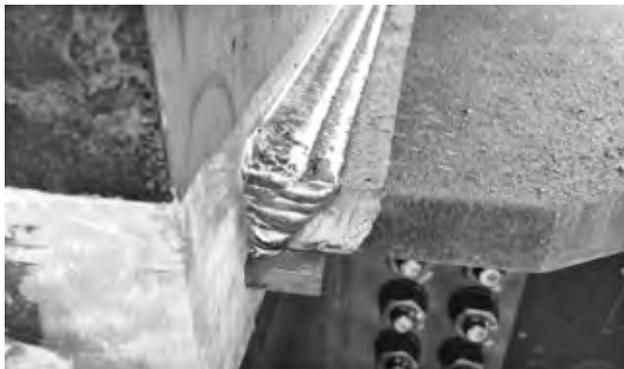
写真一 10 ロボット溶接外観状況（下向き代替タブ）
