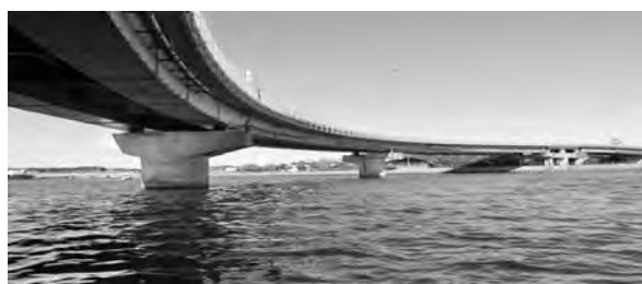
写真―4 第 2 勝関橋
