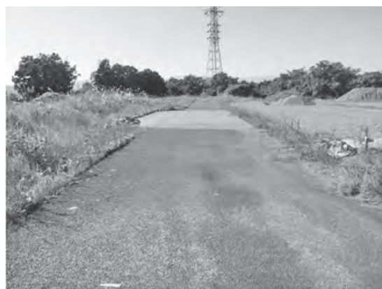
写真一 3 試験ヤードの状況
