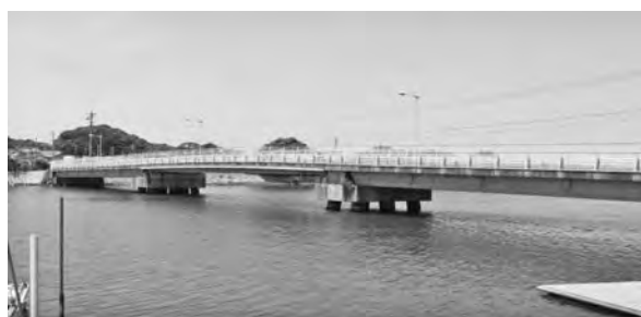
写真―3 競艇大橋
