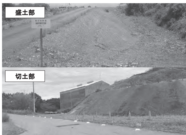
写真-1 試験ヤードの状況
