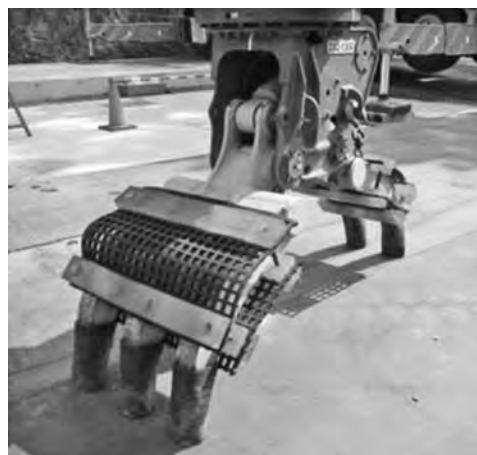
写真—12 緩衝材取付状況
