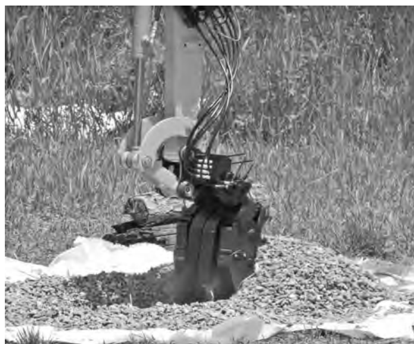
写真—6 土砂掘削
