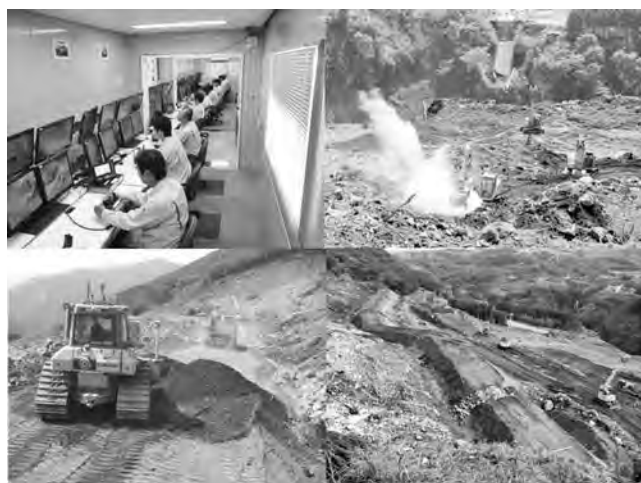
図—2 土留盛土工施工状況
