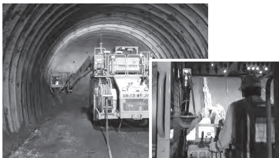
図—12 ロックボルト誘導技術の使用状況
