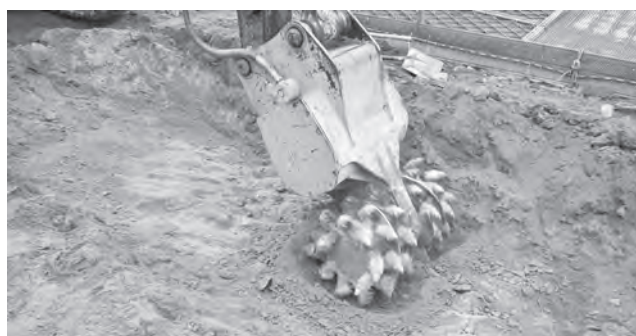
写真—1 地盤改良体の凹凸部（コッター）の施工状況
