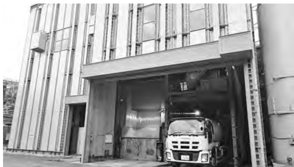
写真一七 コンクリート製造設備外観(ヤード奥行きの関係上全景は不可能)
