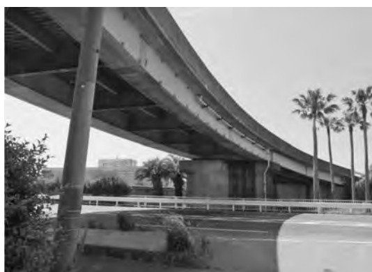
写真―1 新居跨線橋 (国道部)
