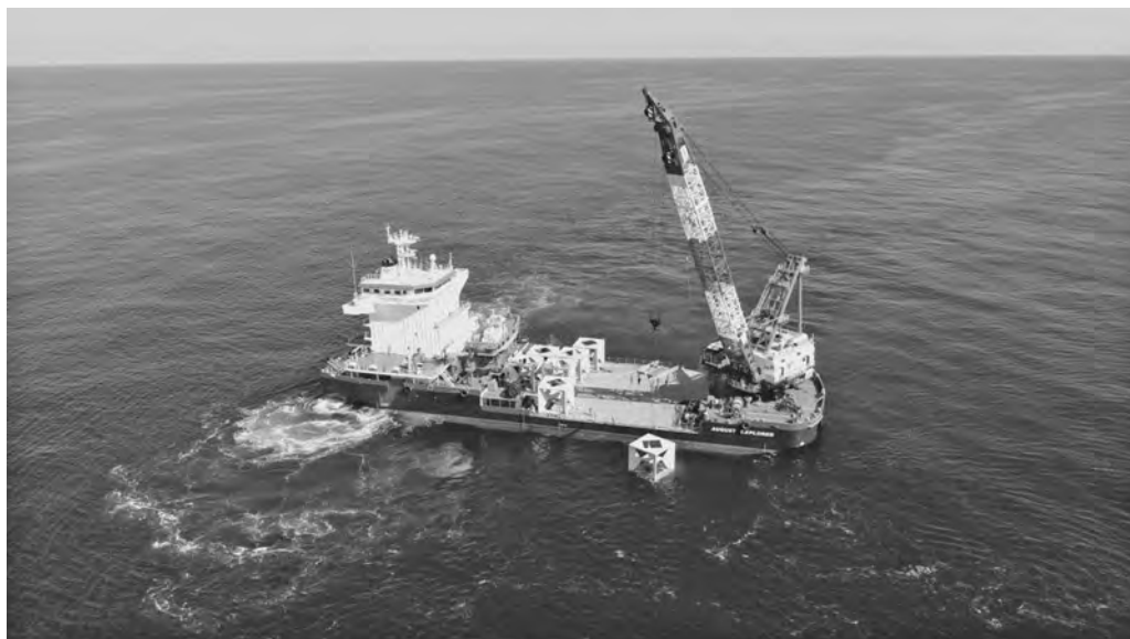
写真—2 本船による魚礁据付空撮
