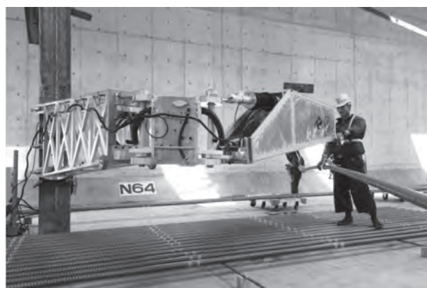
写真-3 鉄筋移動状況 1
