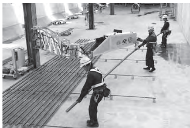
写真-4 鉄筋移動状況 2
