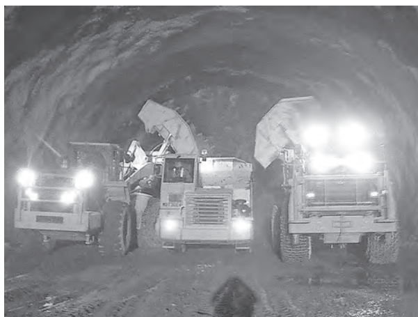
写真－2 高速ずり出し (2台積み)
