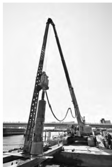
写真ー4 オーガケーシング工法
