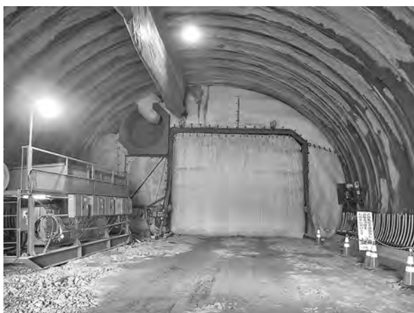
写真—5 マルチバルーン（飛び石防護時）
