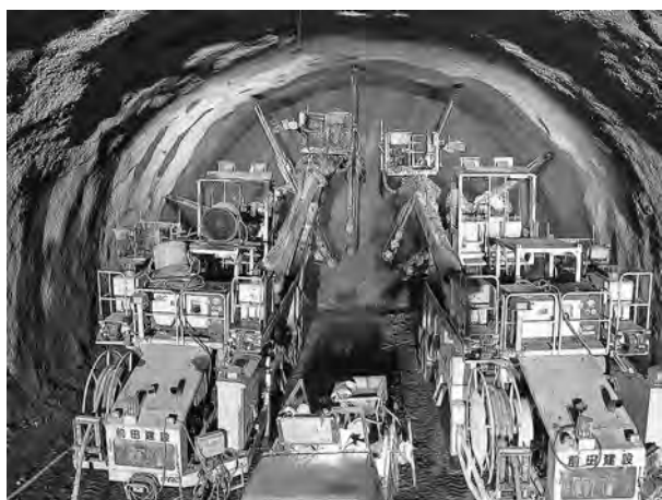
写真一4 ロックボルト時間短縮 (2台施工)
