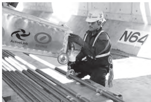
写真-2 鉄筋把持状況
