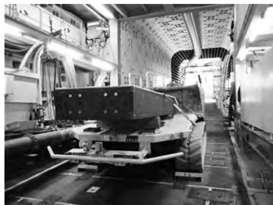
写真一五 セグメント坑内運搬状況
