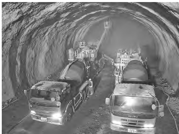
写真一3 吹付け時間短縮 (2台吹付け)
