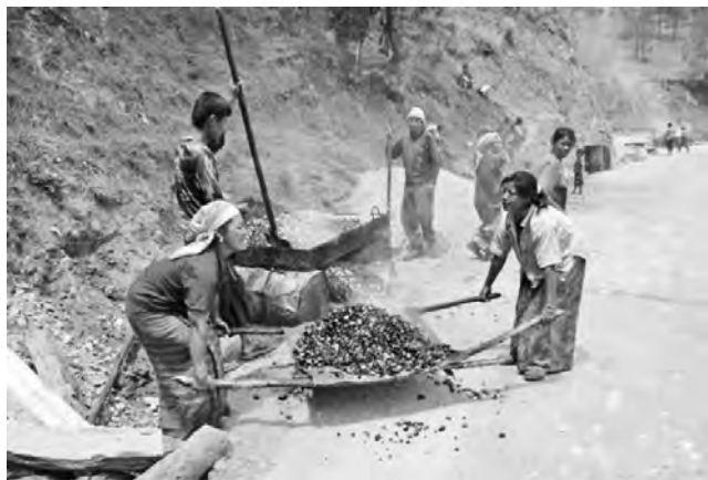
写真2 2004年当時のアスファルト舗装
