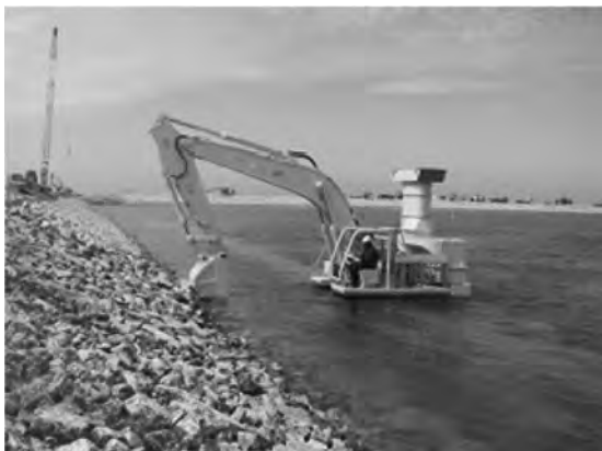
写真—5 護岸法面均し状況
