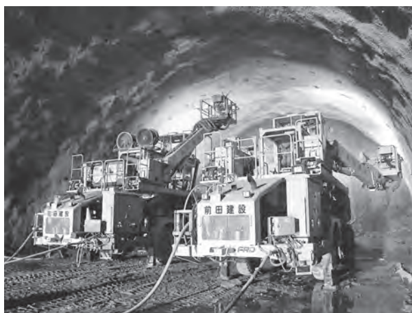
写真－1 穿孔速度向上 (2台穿孔)
