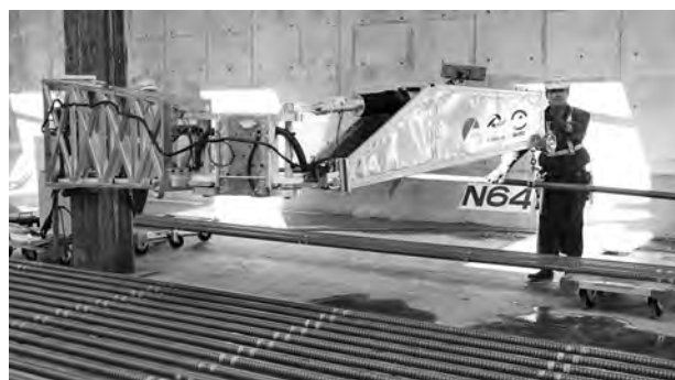
写真-1 本ロボット全景
