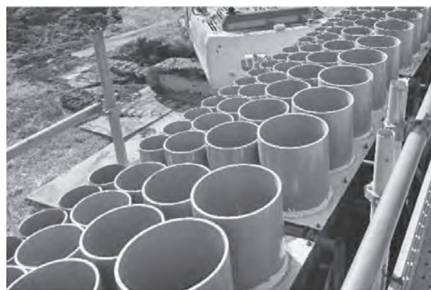
写真—2 音響管設置状況
