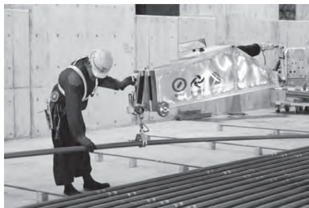
写真-5 鉄筋配筋状況
