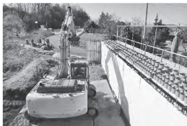
写真—1 音響管付二重防音壁設置状況
