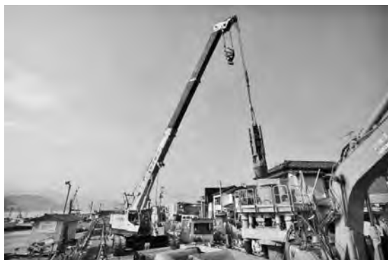
写真-5 オールケーシング工法
