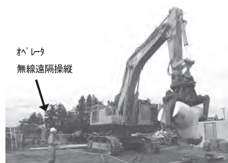
写真一 5 HETORONIC 社 無線遠隔操縦装置
