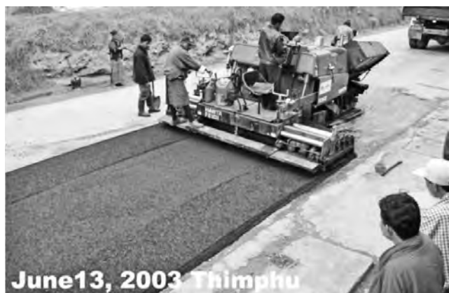
写真1 技術指導前のフィニッシャー舗装
