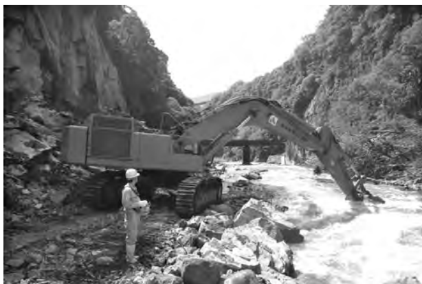
写真—8 熊本県立野ダム災害復旧状況
