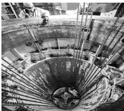
写真—4 上向きシールド機坑内回収状況②
