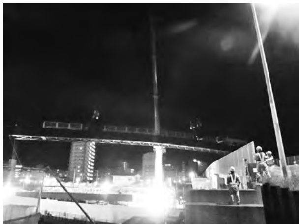
写真—2 実工事での架設状況
