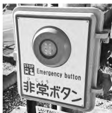
写真—6 列車防護訓練（踏切支障報知装置）
