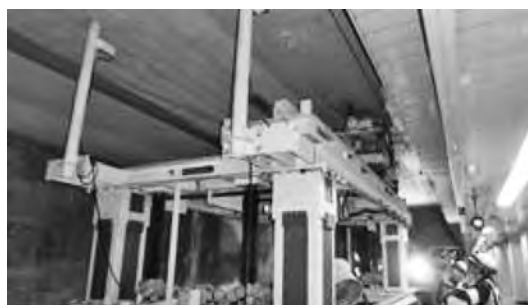
写真—3 施工状況
