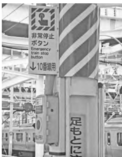
写真—5 列車防護訓練（列車非常停止警報装置）
