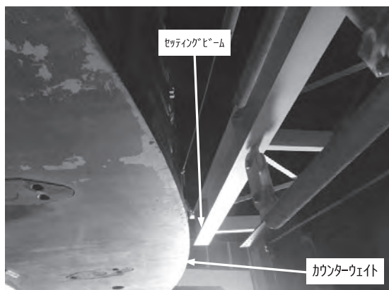
写真—1 実工事でのカウンターウェイトとセッティングビーム
