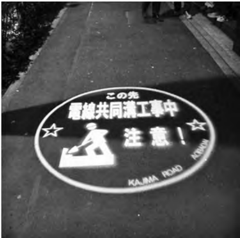
写真—2 投射状況
