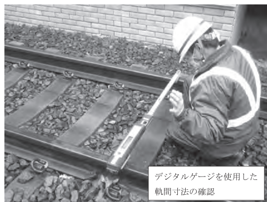
写真—7 軌道※10 検測体験研修（軌間寸法※11の確認）
