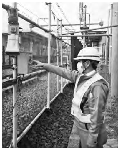
写真—4 列車防護訓練（工事用列車停止装置）
