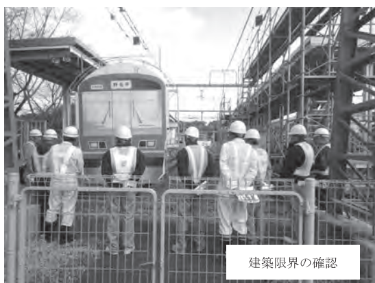
写真一 目で見てわかる建築限界*6 パネルによる建築限界確認の研修
