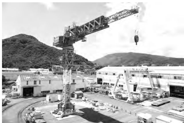
写真—1 エクスター全景写真
