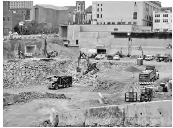
写真ー14 ブロードウェイの再開発現場で稼働中の建設機械群
