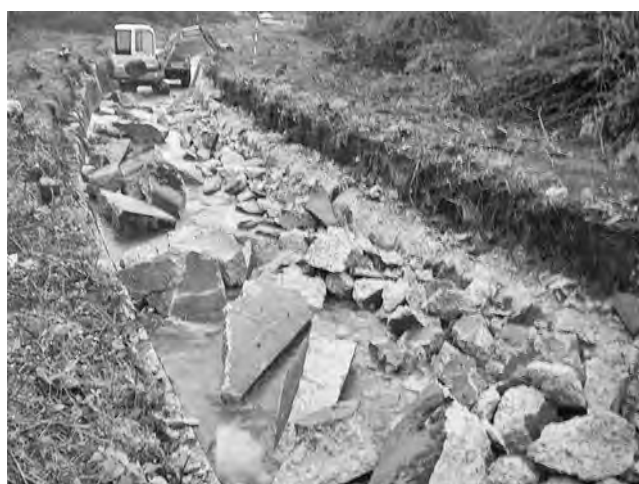
写真ー1 霧ヶ谷湿原の中央にあった排水路コンクリート護岸の除去 (工事期間の2007～2008年)
