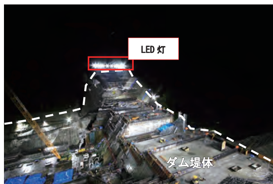
写真一九 ダム堤体と周辺の照射状況（平瀬ダム）
