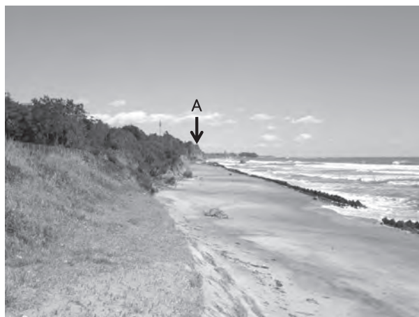
写真—12 背後地上より北側に連なる浜崖の広がり状況を撮影（地点5）
