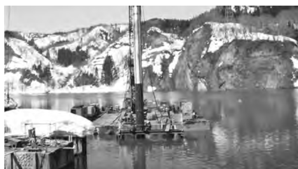
写真—6 台船とアイ・ゼッターによる鋼管杭打設
