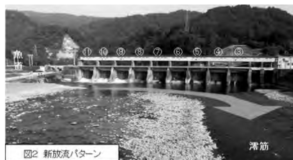
図一2 右岸側のゲートから放流する新しいパターン
