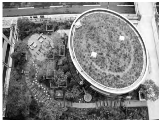
写真—2 建物屋上などの人工地盤上でのビオトープ整備
