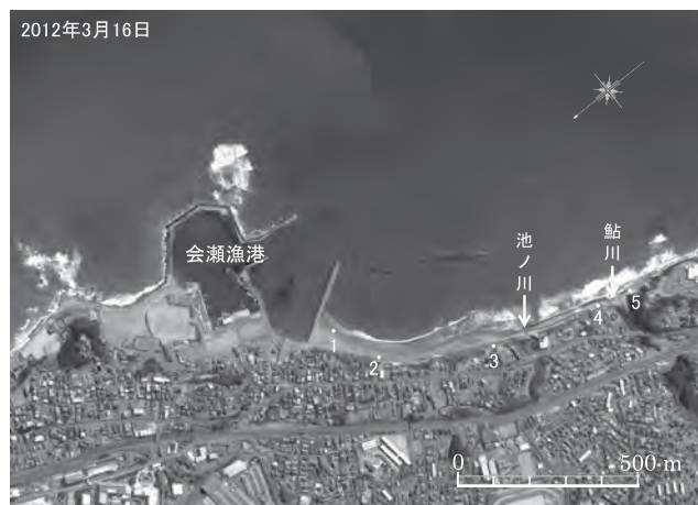
図—8 会瀬漁港周辺の衛星画像と写真撮影地点
