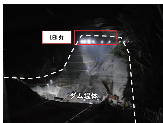
写真一一 ダム堤体と周辺の照射状況（築川ダム）
