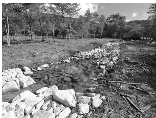
写真ー2 完成した導水路 (2007～2008年)
