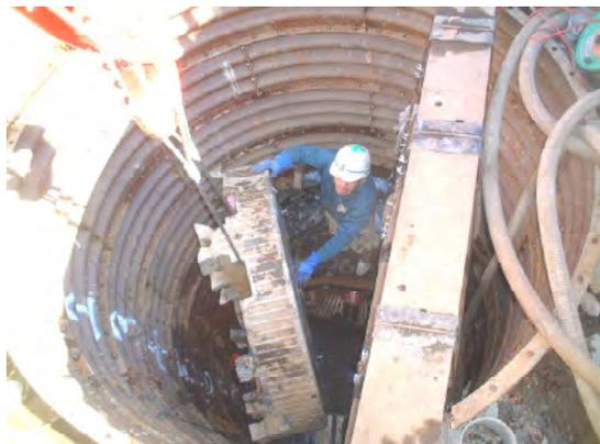
写真-4. 面盤解体引揚げ状況
