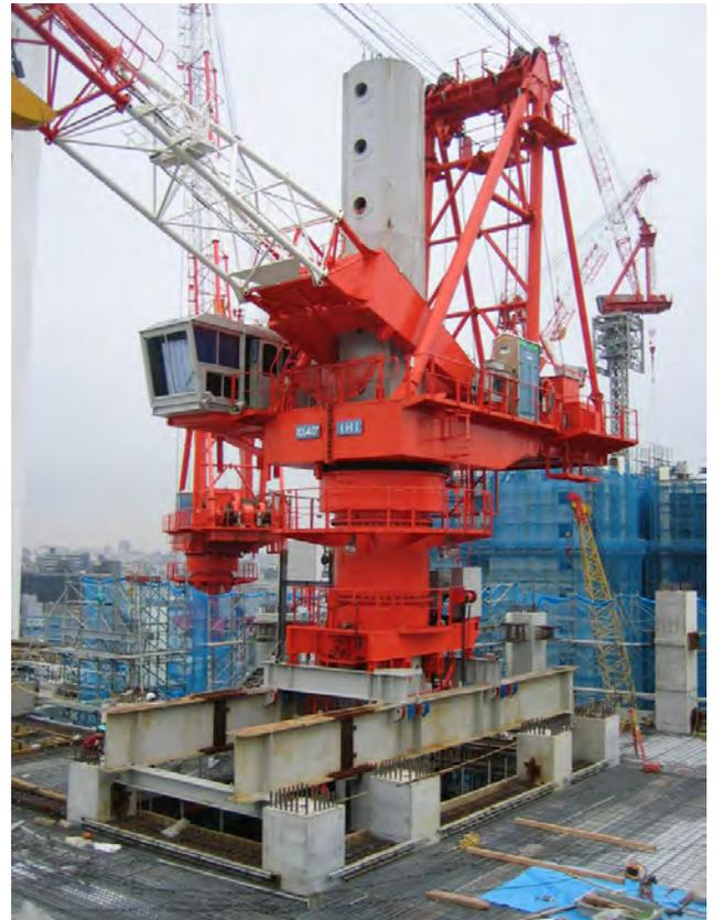
写真2 タワークレーンクライミング状況
