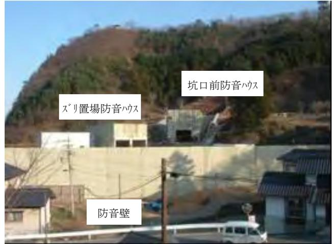
写真-1 坑外防音設備
