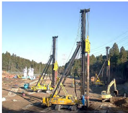
写真-3 レムニ2/3工法の施工状況
