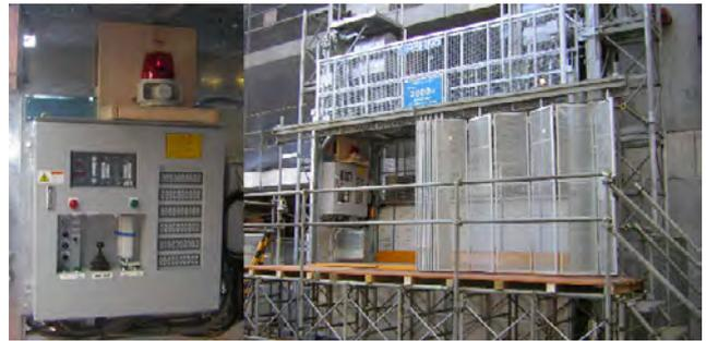
写真3 工所用エレベータと操作盤・ブザー付回転灯
