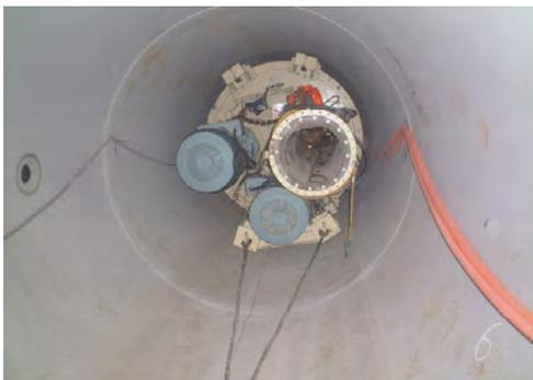
写真-11. 駆動部引戻し状況(発進側より)
