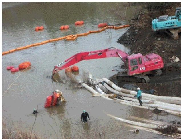
写真2 限られた重機での排水ポンプ設営状況
