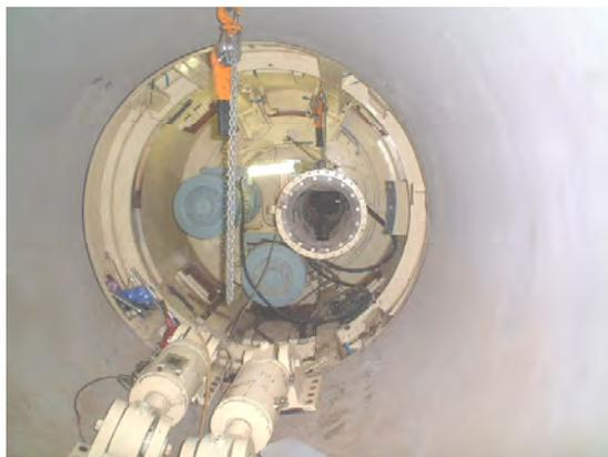
写真-5. 方向修正ジャッキ他解体状況
