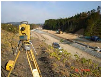
写真-3 情報化施工の路盤整形作業
