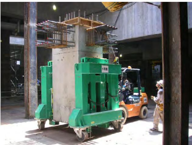
写真5 フル PC 柱搬送装置 稼動状況
