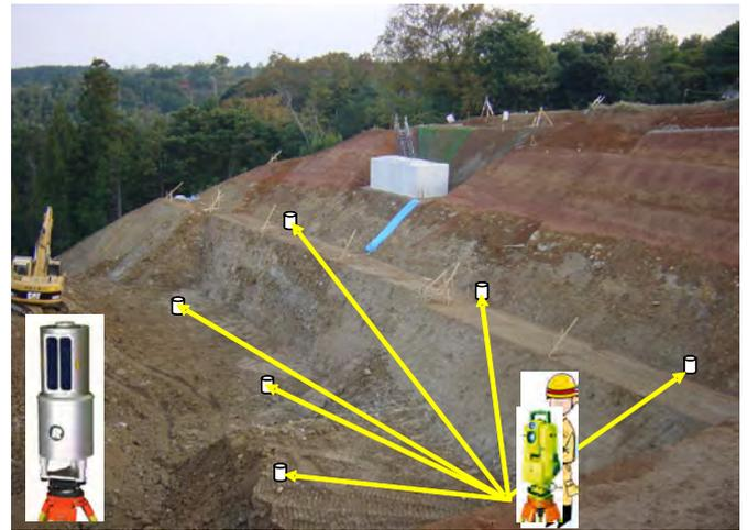
図-2 計測方法の概念図
