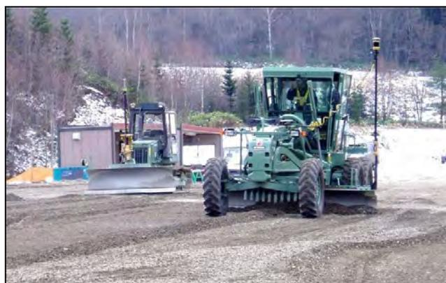
写真1 高精度GPSグレーダによる現場作業状況
