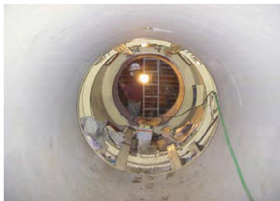
写真-7. 外殻-駆動部切離し完了
