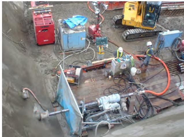
写真-4 脚部補強対策工施工状況
