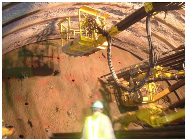
写真-5 注入式長尺鏡補強工施工状況
