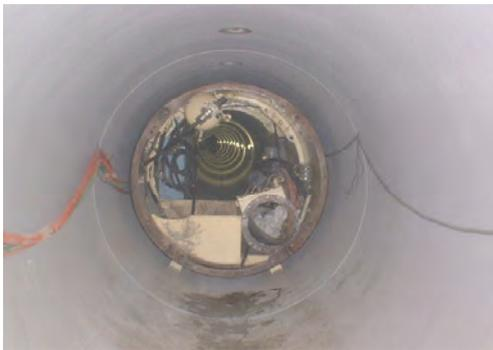
写真-9. 後続管引戻し状況(到達側より)
