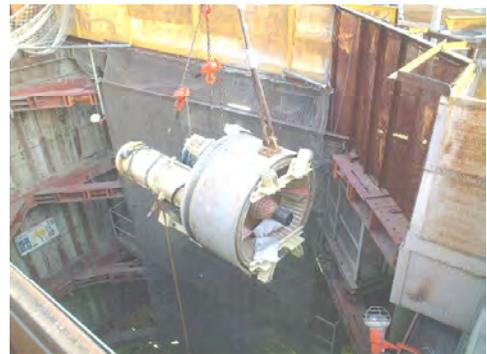
写真-12. 駆動部引揚げ状況(発進立坑部)
