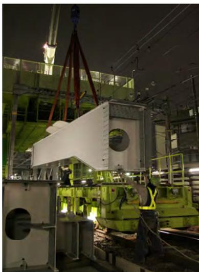
写真-3 直接高架施工機による荷おろし
