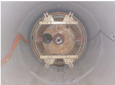
写真-10. 駆動部引戻し状況(到達側より)
