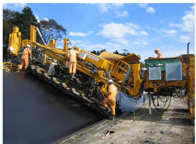
写真—6 斜面全幅施工状況
