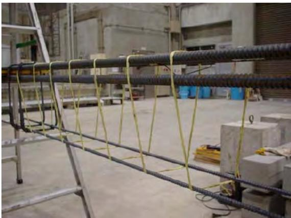
図1 せん断補強(新設構造物)
