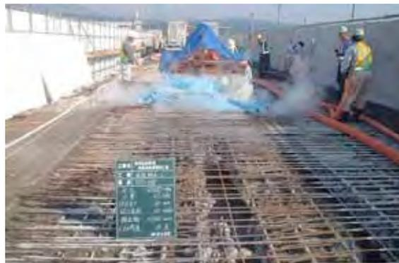
写真-2 WJによる劣化コンクリート撤去状況
