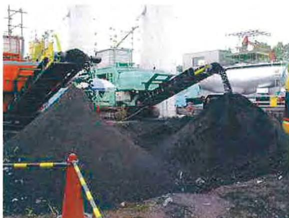
写真 2 アルミ系固化助材の混合攪拌状況
