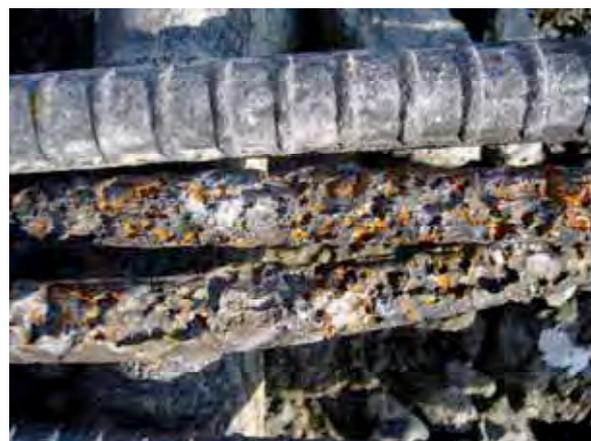
写真-1 マクロセル腐食状況
