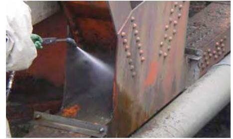
写真-7 トラス部材格点部の洗浄
