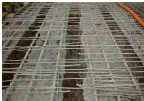
写真-4 上面劣化コンクリート撤去完了時の状況
