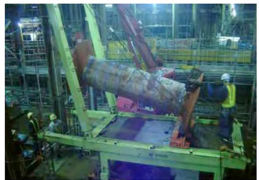
写真-9 建起し状況 下部スライド装置
