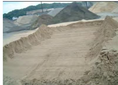
写真-3 気中部での水平掘り出来形確認体
