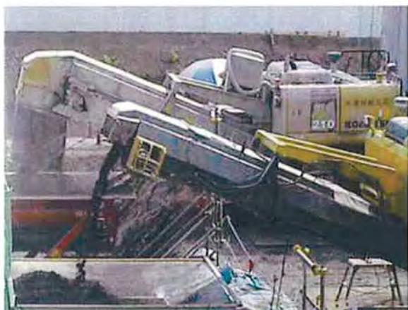
写真 1 石灰系固化材の混合攪拌状況
