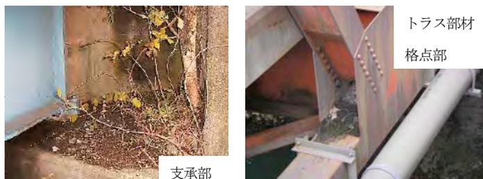
写真-1 土砂詰りによる損傷例
