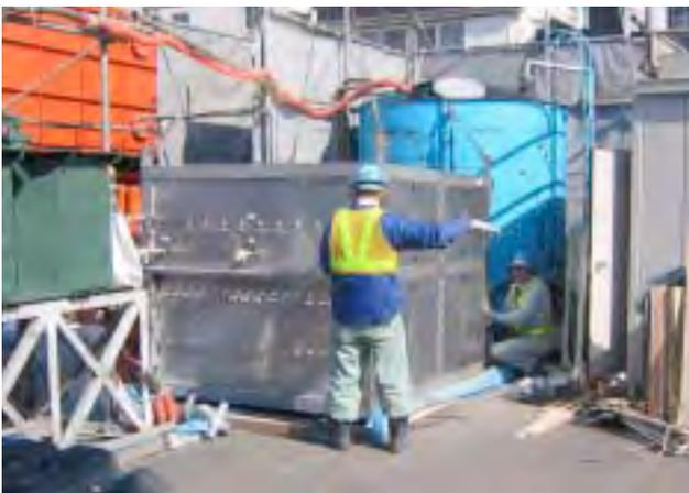
図-5 多連注入ポンプの設置例
