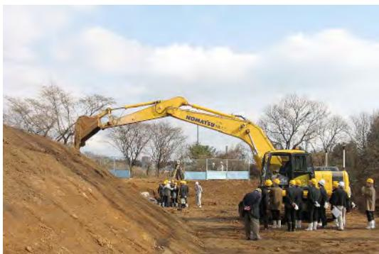
写真-1 試験ヤードにおけるバックホウの情報化施工(試験施工)のようす
