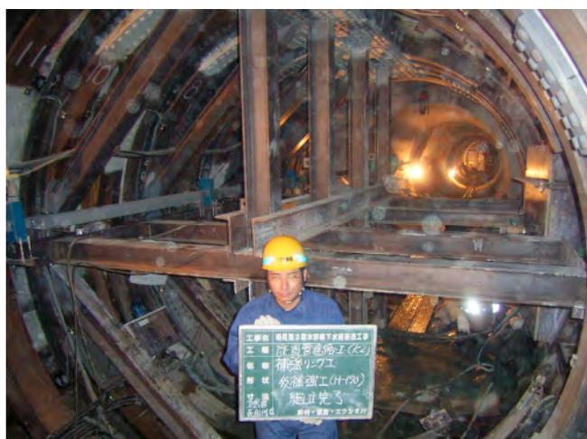
写真-4 既設管補強
