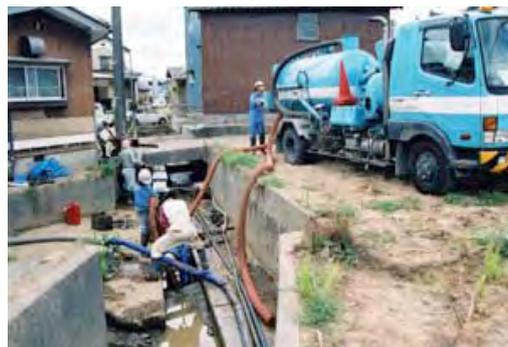
写真-3 汚泥吸引車による作業状況
