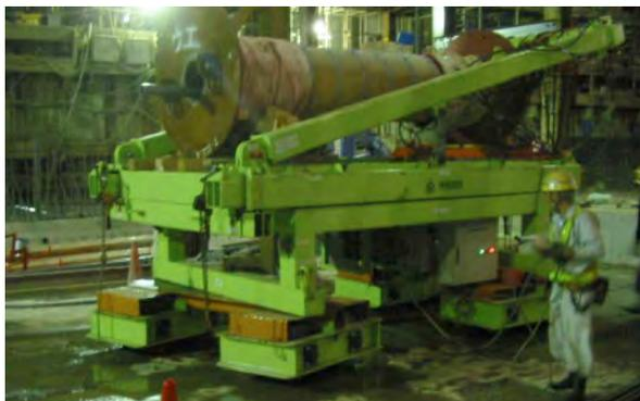
写真-7 円筒柱運搬状況(前方)
