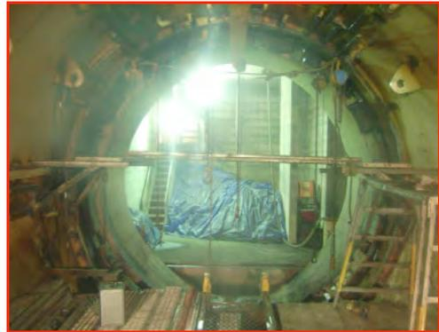
写真－11 カッタヘッド内殻・中殻撤去完了
