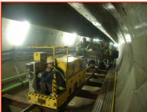
写真－10 駆動部運搬状況
