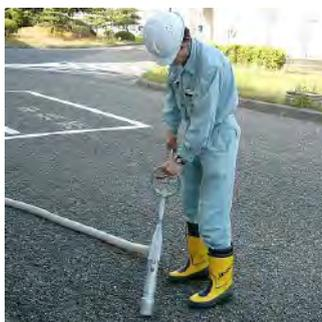
写真-6 堆積用ノズル
