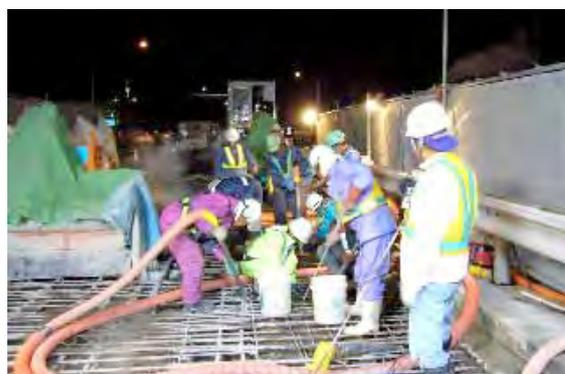
写真-3 コンクリート殻の回収状況
