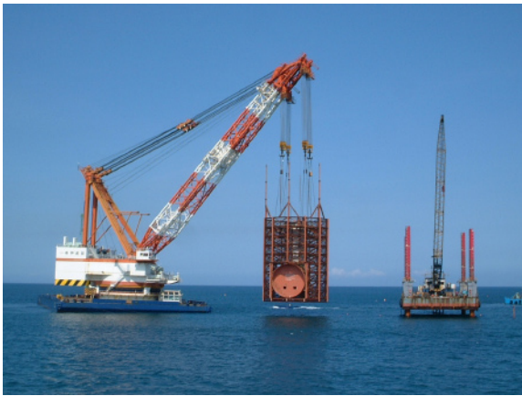
写真-5 J字型放水管（J字管）据付 J字管（重量約530t×2基）を1,600t吊全旋回起重機船により井筒内の鋼管支持杭上に一括据付した。
