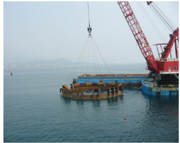
写真-2 腹起し設置
