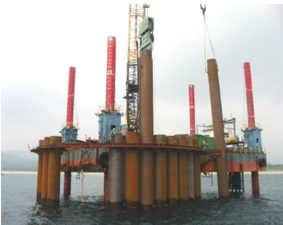
写真-1 鋼管矢板打設
