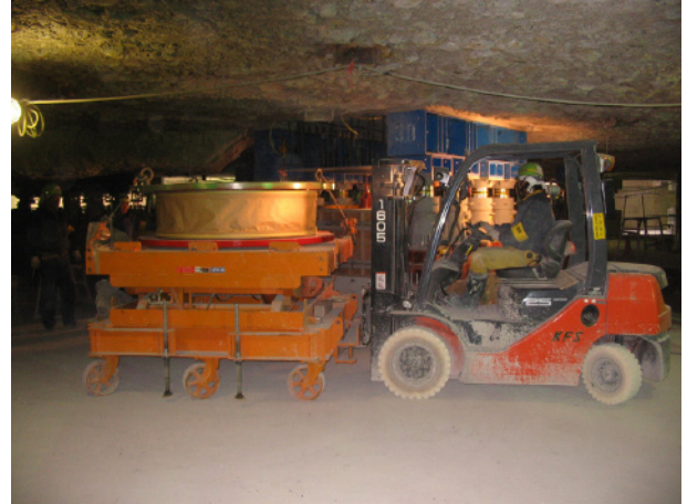
写真-5 免震装置運搬
