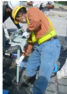
写真-3 拘束ベルト挿入
