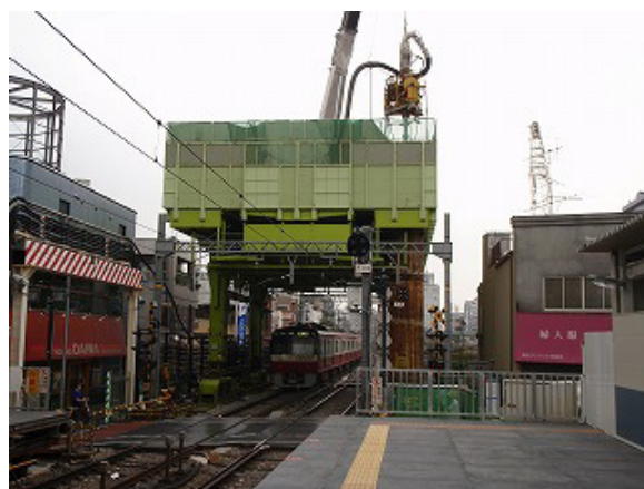
写真-6 基礎杭施工状況
