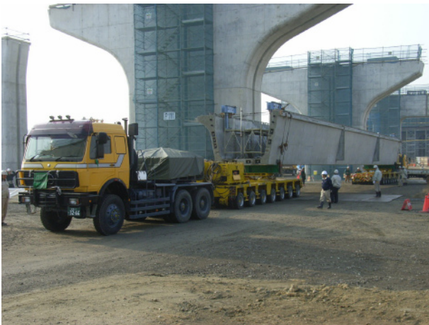
写真-2 U桁場内運搬状況
