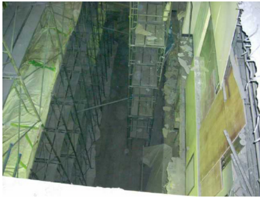
写真・3 エスカレータ撤去後の開口部
