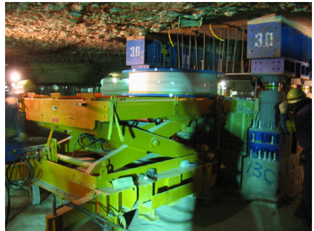
写真-6 免震装置据付
