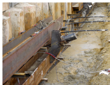
写真-4 通電状況
