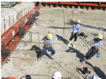
写真-11 人力による引抜き状況
