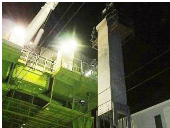
写真-7 PCa 柱架設状況
