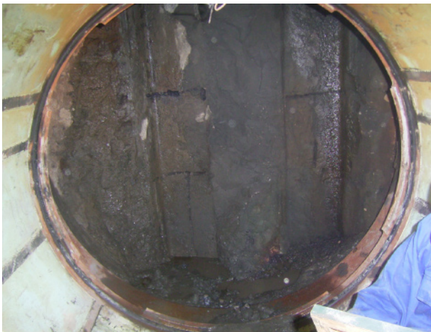
写真 - 5 鋼矢板撤去完了状況
