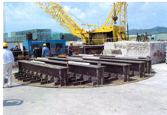
写真-16 J字管上蓋撤去完了
