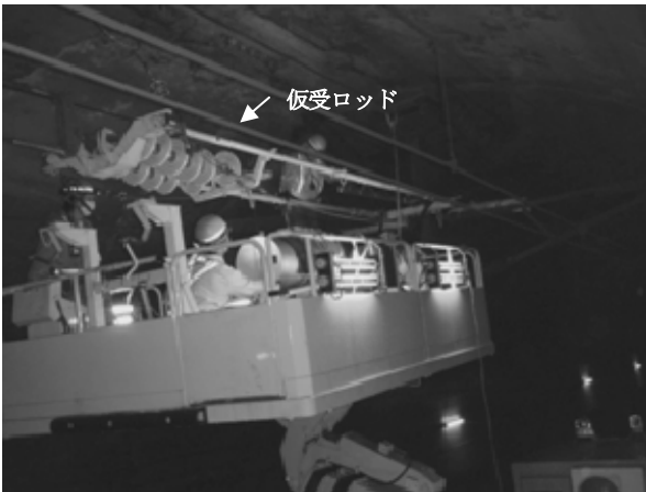
写真6 仮受ロッドによる張力移し替えの様子
