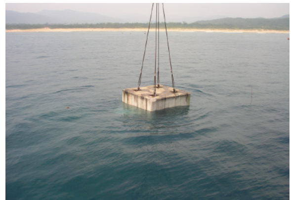
写真-9 洗掘防止工 写真は海中放水口の基礎周囲の洗掘防止用の被覆ブロック設置状況。
