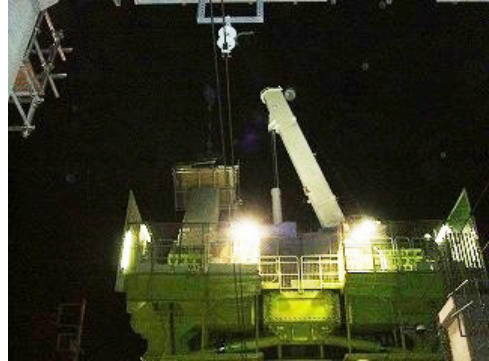
写真-11 PCa 柱建起し状況
