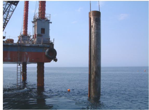
写真-8 シールド機到達部鋼管矢板切断撤去 シールド機が到達する部分にある鋼管矢板7本を水中で切断し撤去した。（抜きながら、CB注入）
