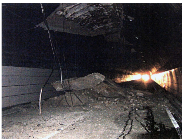
写真-1 コンクリートの剥落
