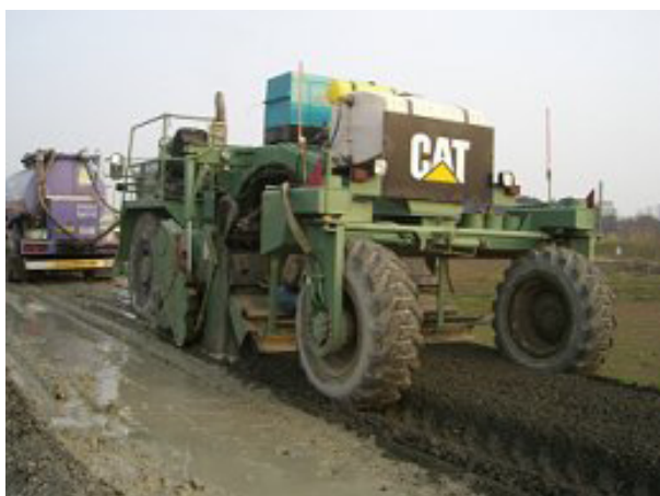
写真-4 破碎・混合状況
