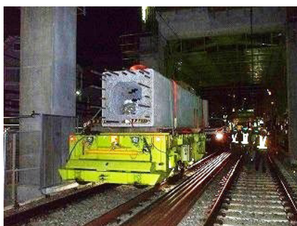
写真-10 軌道内運搬状況
