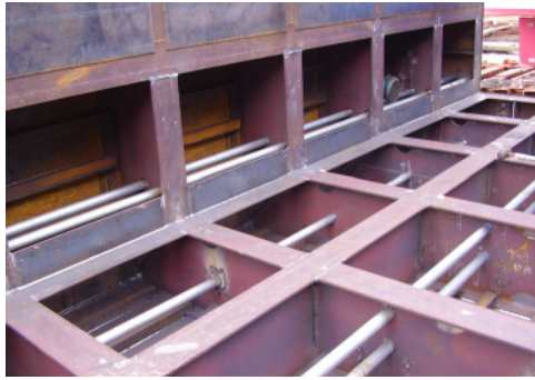
写真-5 函体内部分割構造
