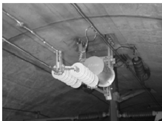
写真1 新設したTTB(青函トンネル内) TTBは、軌道上約7mのトンネル中心部の天井に
