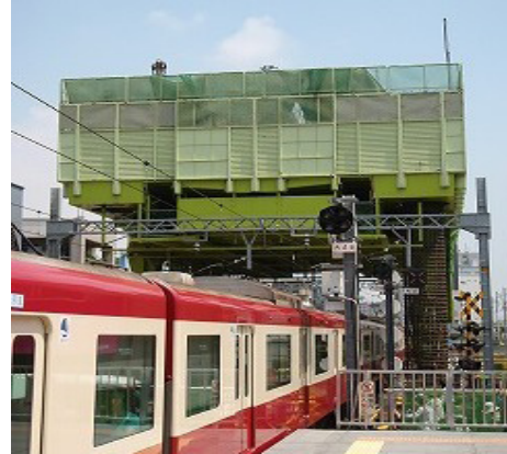
写真-1 杭施工機導入状況
