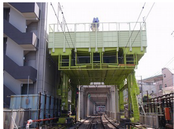
写真-2 柱梁架設施工機導入状況
