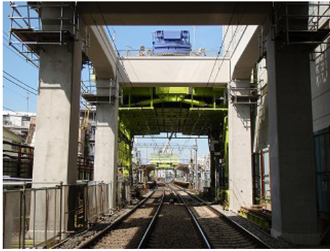
写真-8 PCa 部材架設箇所
