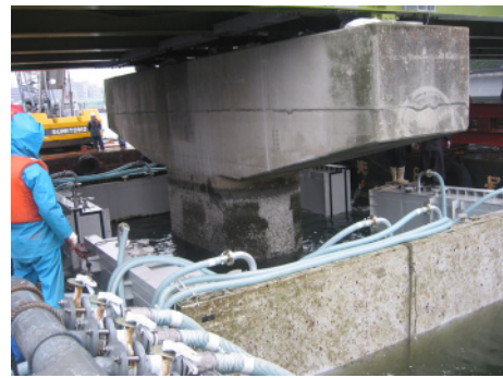
写真-3 函体据付状況
