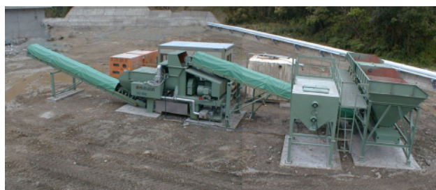
写真-3 フォームドアスファルトプラント
