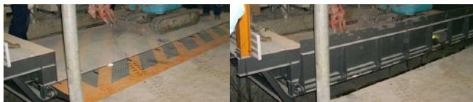
写真・6 搬器(ステージ)回転デッキ
