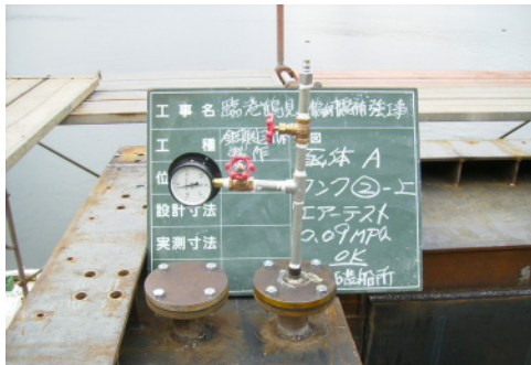
写真-6 加圧試験
