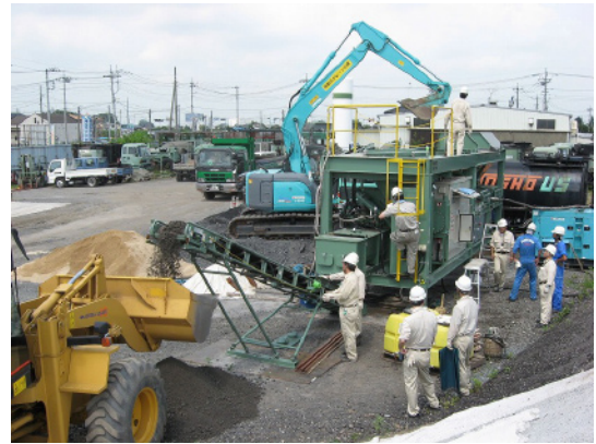
写真-9 混合物出荷状況
