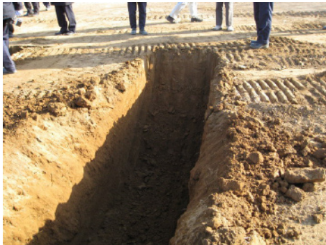
図-12 自動掘削作業終了後の出来形
