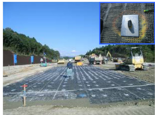
写真-5 完成状況
