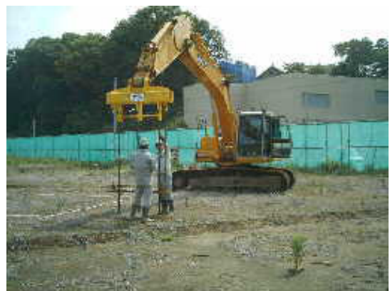
写真9 実績宅地での補修改良状況
