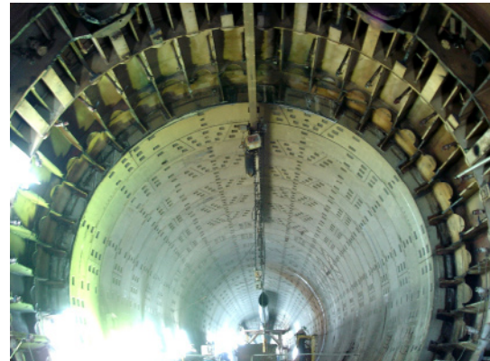
写真-15 接合完了（J字管側から撮影）
