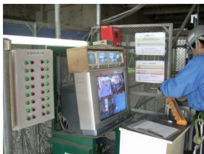
写真・7 監視モニターおよび操作盤
