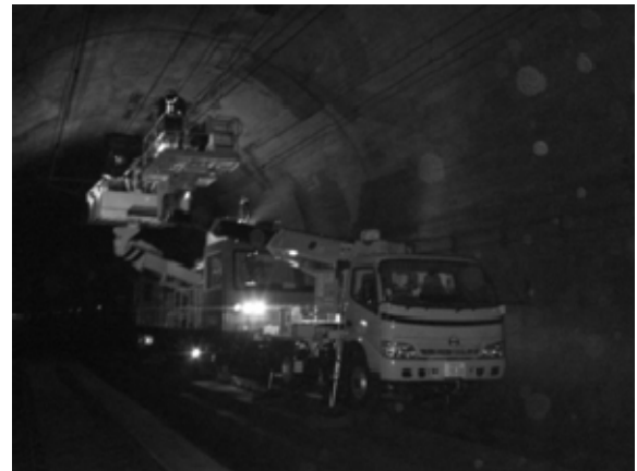
写真 5 TTB 新設施工中
