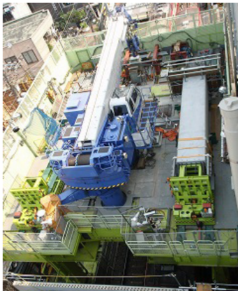
写真-5 PCa 柱建起し装置
