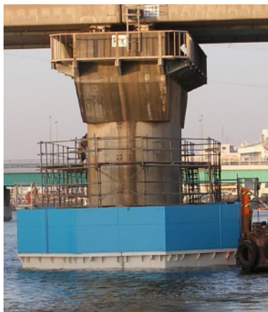
写真-9 鋼管井筒矢板基礎での設置状況
