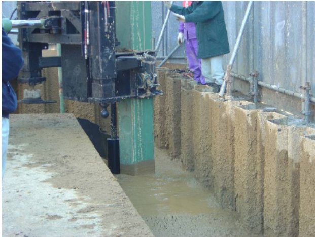
写真-6 シートの角付け作業状況
