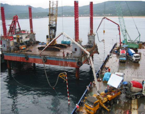
写真-6 中詰めコンクリート打設 井筒内部に中詰めコンクリート（水中不分離コンクリート、約17,000m 3 ）を連続打設。コンクリートミキサー車ごと台船輸送し、台船上のコンクリートポンプ車でトレミー管を使用して打設した。
