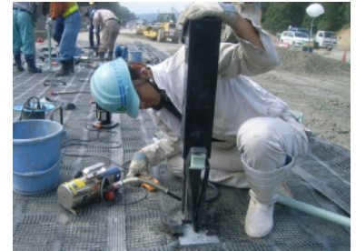
写真-4 プレストレス工
