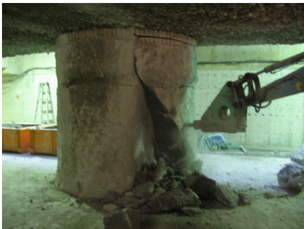
写真-4 油圧ブレーカによる解体
