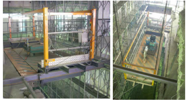
写真・5 搬器各階停止状況と昇降状況
