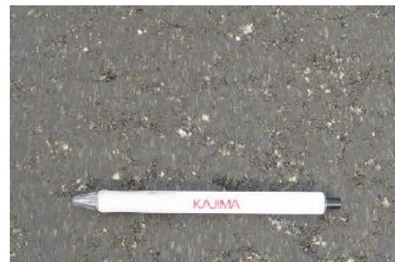
写真-11 車道用土系舗装表面
