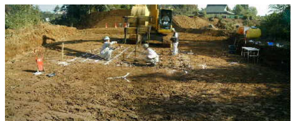
写真7 試験貫入施工
