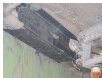
写真1 除去後のH鋼梁面
