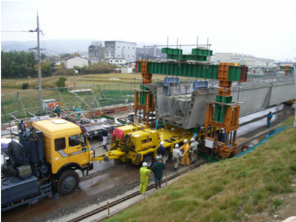
写真-1 U桁積み込み状況
