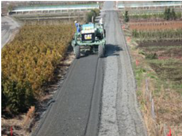
写真-2 一次破碎状況
