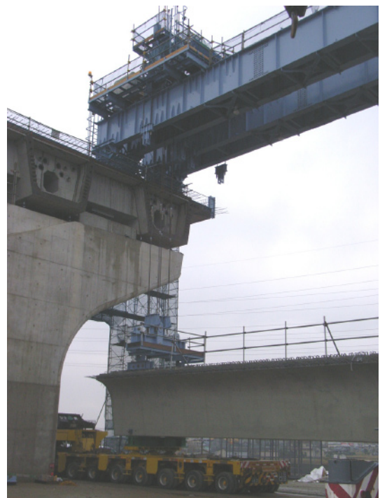
写真-4 U桁吊り上げ状況
