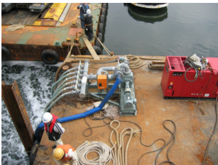
写真-7 給排水設備
