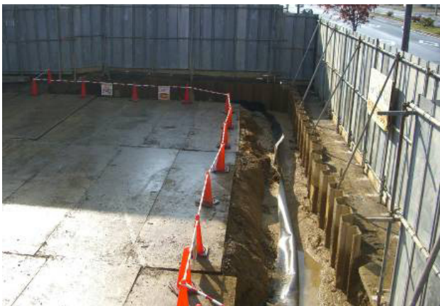
写真-7 角付け施工完了状況
