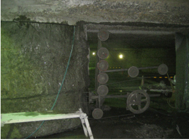
写真-2 ワイヤーソーによる解体
