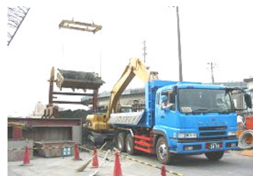
(写真-2) 内部掘削工一連の流れ
