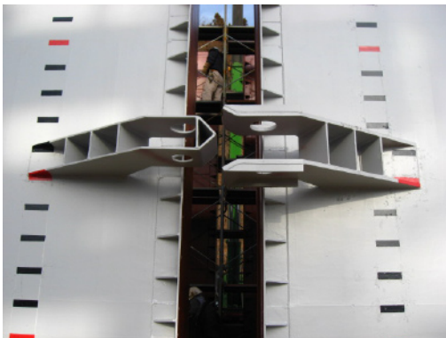
写真-1 ピン構造
