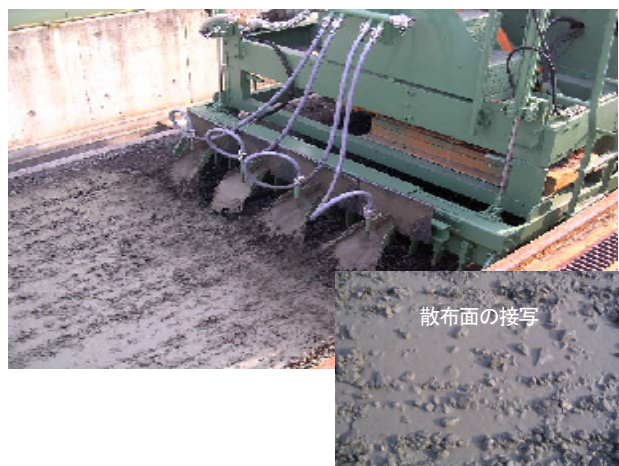
写真-2 スラリー散布状況と散布面
