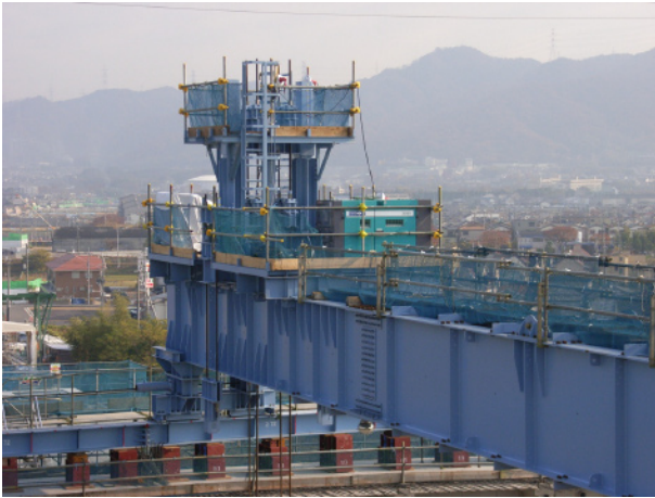
写真-5 横取りレール配置状況
