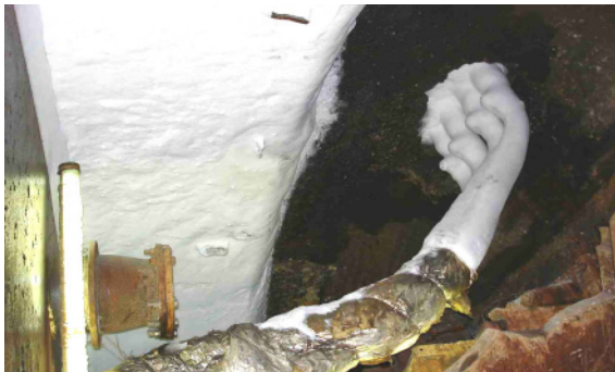
写真-13 さや管部凍結管での二次凍結
