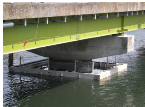
写真-4 沈設完了
