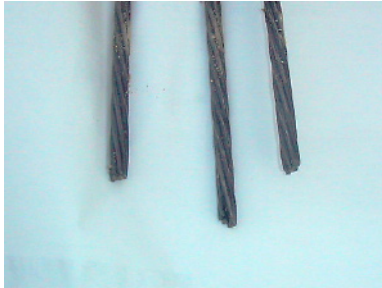
写真-6 PC鋼線切断状況
