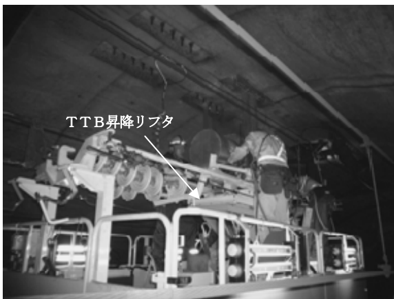
写真7 リフタによるTTB取り付けの様子
