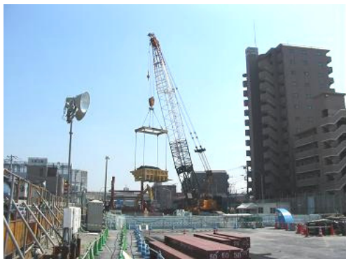
写真－5 工事現場全景
