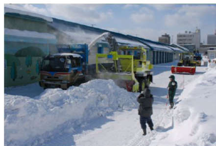
写真 - 5 計測試験
