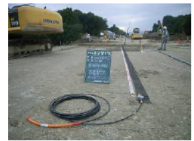
写真-6 光ファイバーセンサー入りジオグリッド
