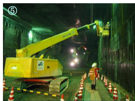
写真-4 ケレン作業におけるアタッチメントとケレン作業状況
