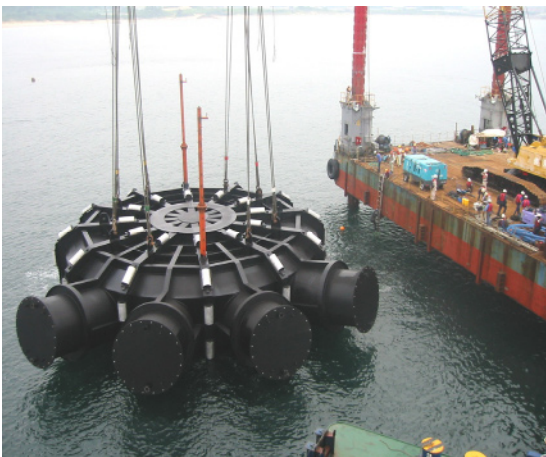
写真-7 マルチノズル排水頭設置 放水口となるマルチノズル式排水頭（本体の直径
