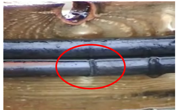
図-7 ケーブルの破壊試験
