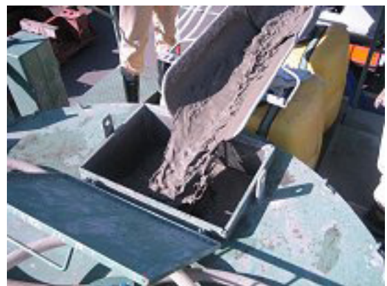
写真-5 材料受け入れ状況
