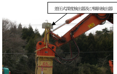
写真-2 深度・鉛直性管理検出装置
