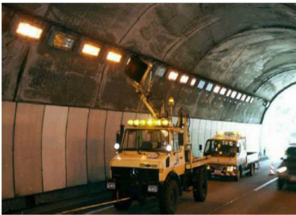
図-1 トンネル照明器具の清掃状況
