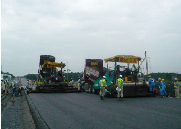
写真-4 施工状況
