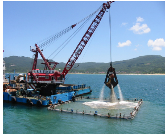
写真-3 鋼管矢板井筒内掘削
