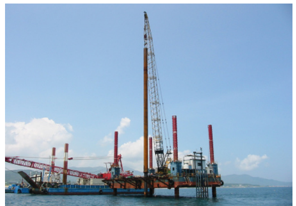
写真-4 基礎鋼管杭打設
