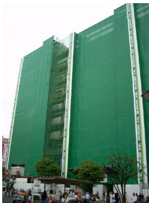
写真・2 リニューアル工事全景
