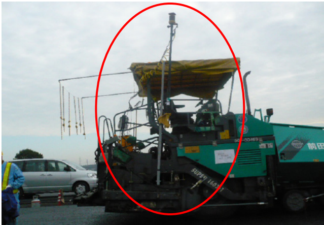
写真-1 フィニッシャーへの、GNSS 式取付状況
