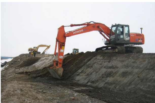
写真－1 ICTバックホウによる施工状況
