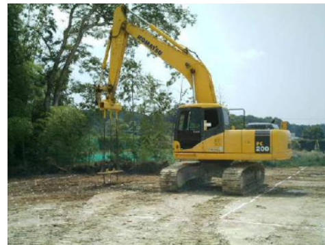
写真2 貫入作業の状況
