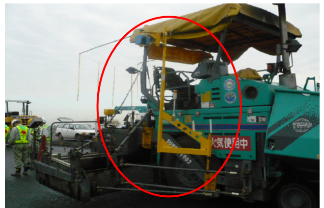
写真-2 フィニッシャーへの、レーザスキャン式取付状況
