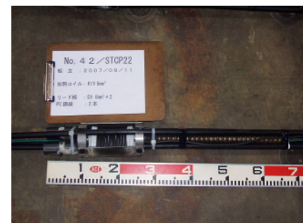
写真-8 鋼製第2耐荷体
