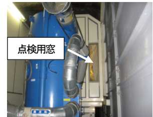
写真-4 点検用窓
