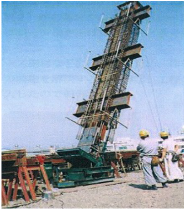
写真-4 鉄骨建起し装置
