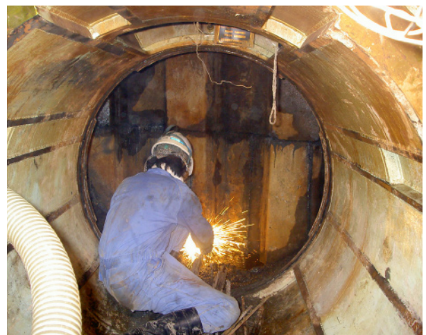
写真-4 鋼矢板切断状況
