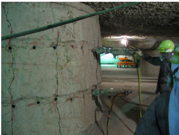
写真-3 ロックジャッキによる解体
