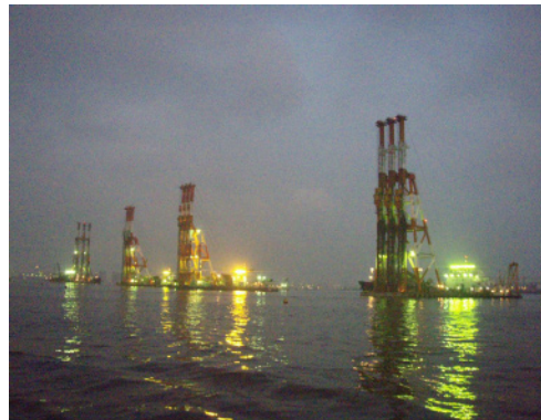
写真-2 : 夜間施工状況
