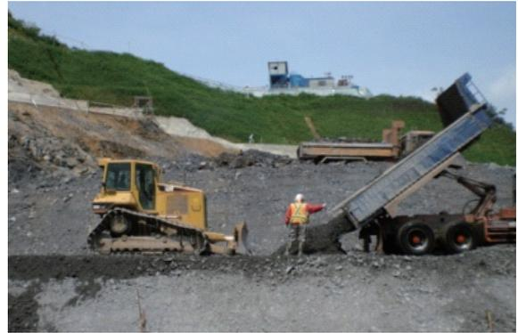
写真-8 CSG荷卸状況
