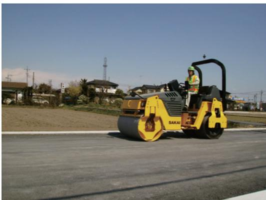
写真-3 CISによるCCV測定状況
