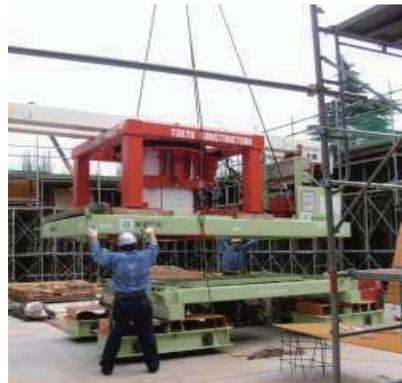
写真-6 組立状況(上部取付装置搭載)
