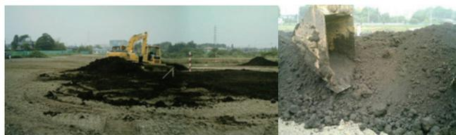
写真-5 改良腐食土の盛土工区での撒きだし転圧状況
