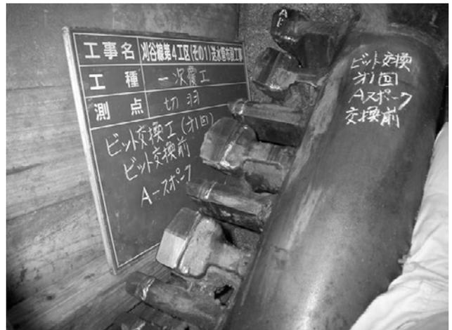
写真-11 カッタービット交換前状況
