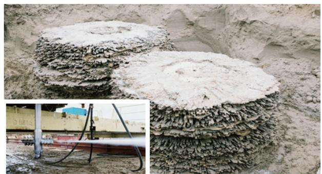
写真-1 N J P 攪拌翼と造成改良体
