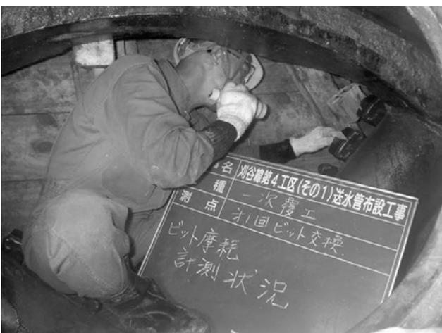
写真-10 ビット点検交換状況
