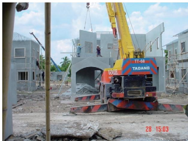
図-2 現場では移動式クレーンでプレファブ部材を吊り上げ、組立てていく
