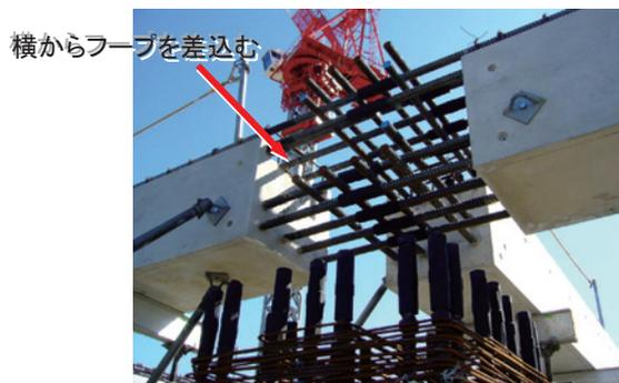
写真-1 T型配置の梁 PCa
