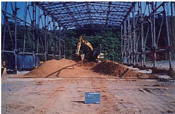
写真-3 昇降屋根付き曝気設備
