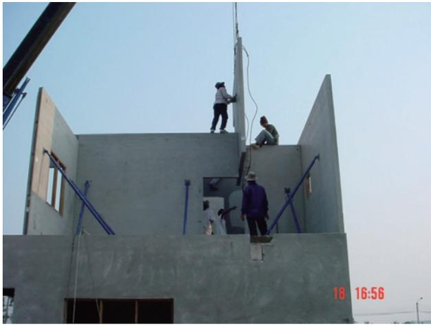
図-4 順番を誤って狭い空隙に壁を挿入している
