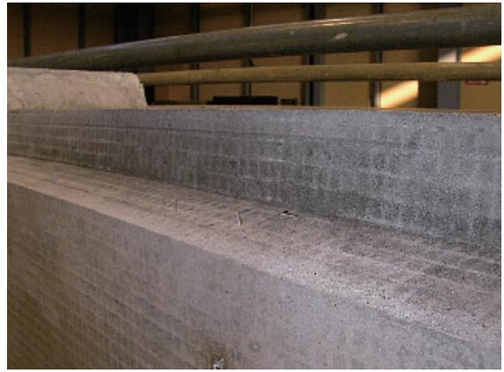
写真-6 目地部脱枠状況
