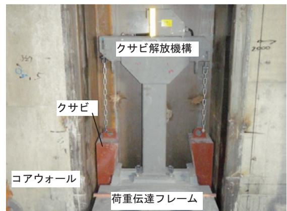
写真-5 くさび制御装置
