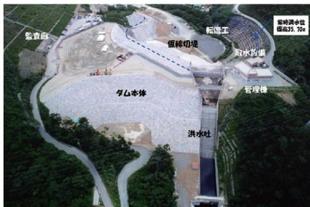
写真-1 真喜屋ダム (施工中の航空写真)
