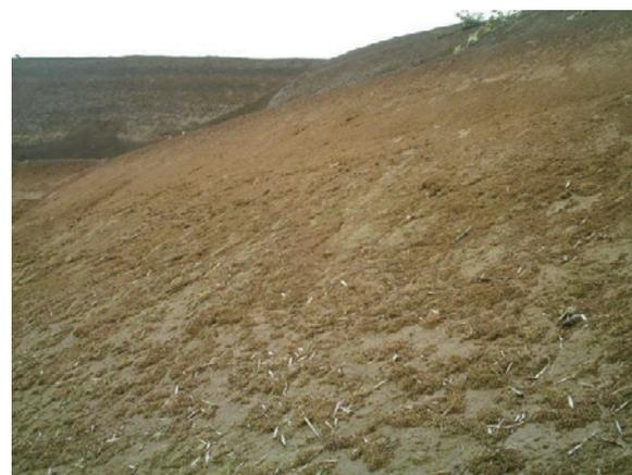
写真-8 切土工区 有機酸浸透法面1年経過状況
