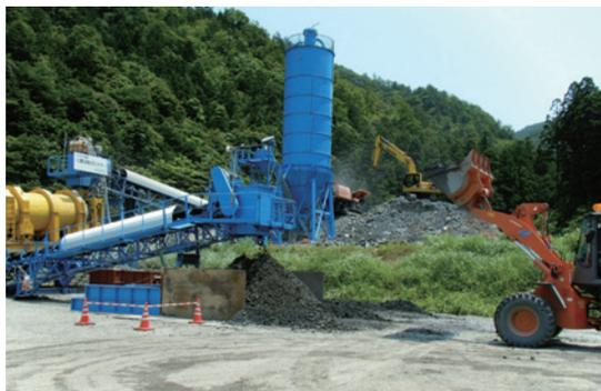
写真-6 CSG製造状況
