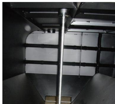
写真-4 タンク内に設置されたレーダーレベル計
