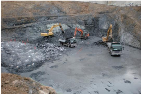
写真-5 CSG母材採取・運搬状況
