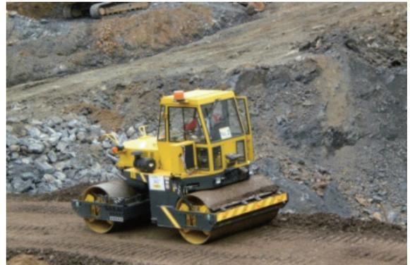
写真-9 CSG締固め状況
