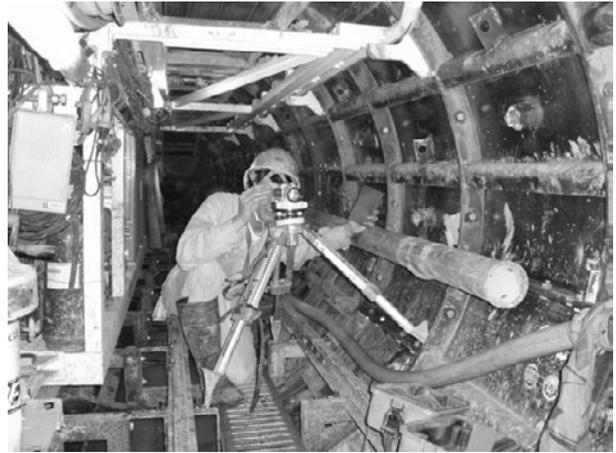
写真-4 従来の坑内測量状況
