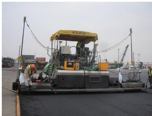
写真-5 GNSS 式基層施工状況
