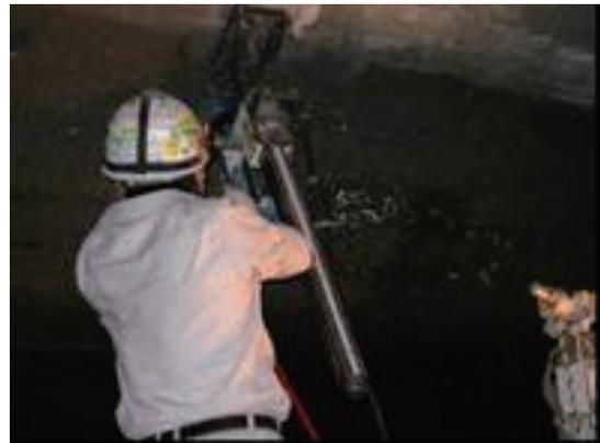
(a) 注入口削孔作業状況
