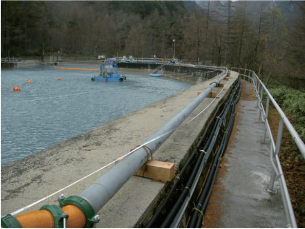
写真-10 陸上排砂管設置状況
