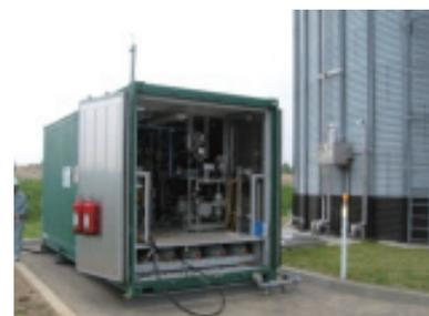
写真-1 バイオガス精製圧縮充填装置設置状況
