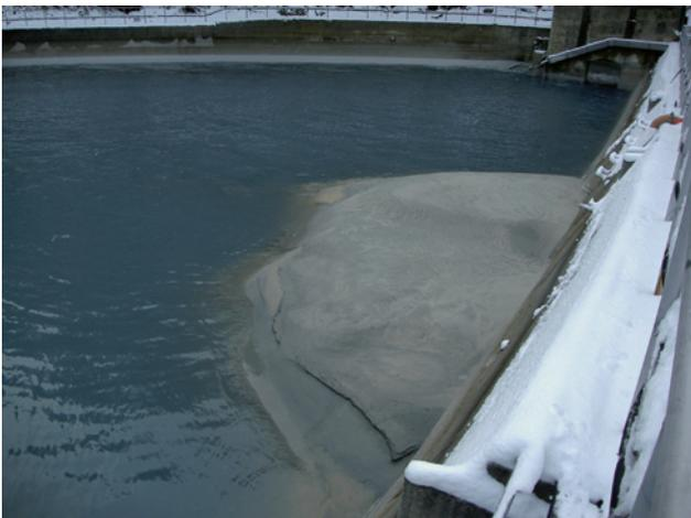
写真-12 排砂口と堆積除去土砂ストック状況
