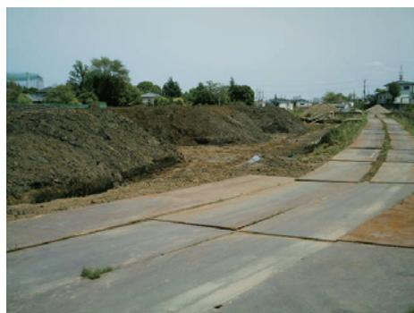
写真-4 改良腐植土の地下水位上集積養生状況
