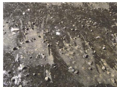
写真-6 水膜路面における加熱水混合散布施工路面の一例
