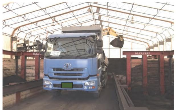
写真-5 浄化土建屋内での浄化物積み込み状況
