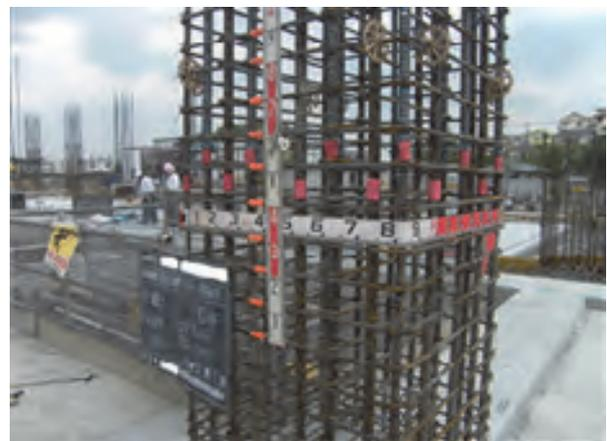
図-1 配筋検査写真例
