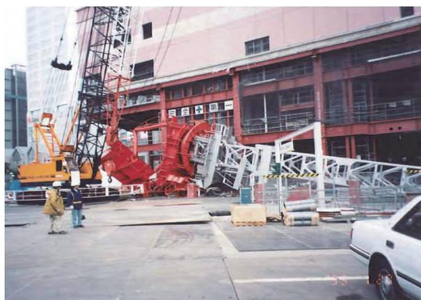
写真-1 倒壊したタワークレーン
