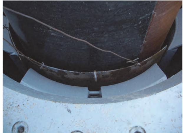
写真-9 重防食塗装面の防護状況
