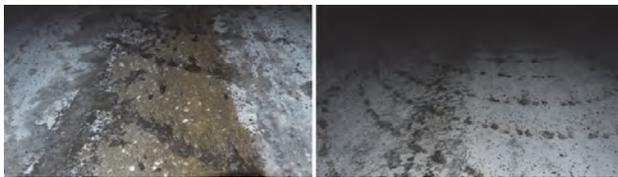
写真-9 雪氷路面における加熱水混合散布施工路面の一例
