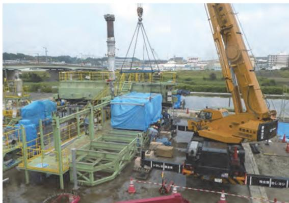
写真-6 無害化処理設備の解体状況
