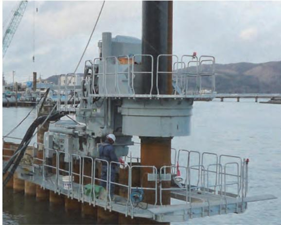
写真-7 鋼管杭施工状況
