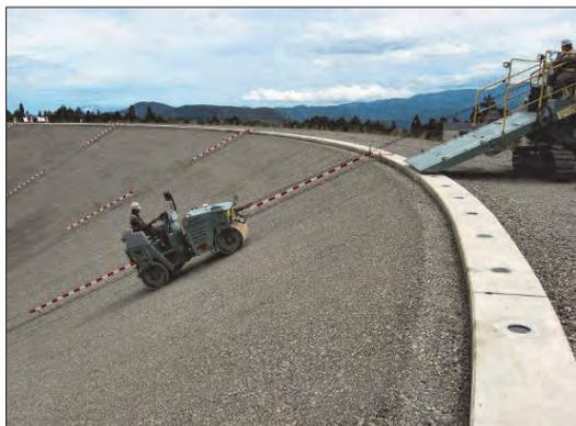
写真-4 ダム・ため池舗装工事例
