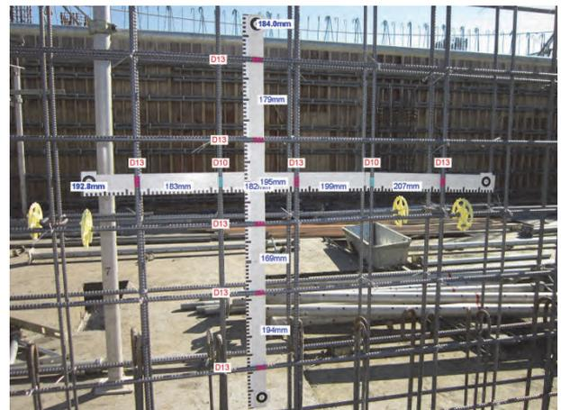
図-14 壁筋への適用
