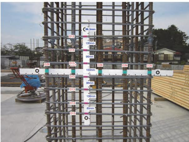
図-12 柱筋への適用
