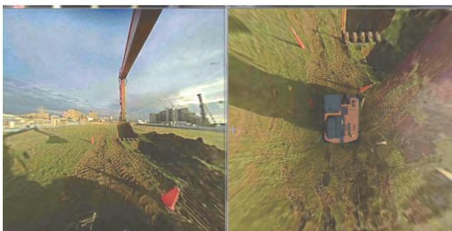
図-8 掘削用前方画像と完成後の俯瞰画像
