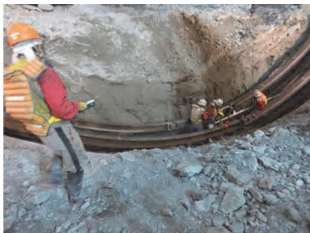
写真-2 インバートストラット接合状況
