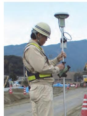
図-8 施工現場におけるGNSS測量
