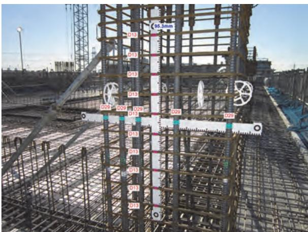
図-13 柱筋への適用
