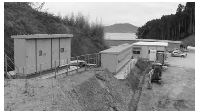
写真-6 破碎機近傍の高圧キュービクル
