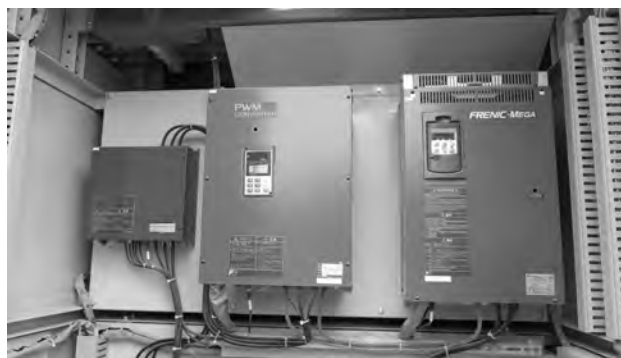
写真-8 スクリーン用インバータと PWM コンバータ
