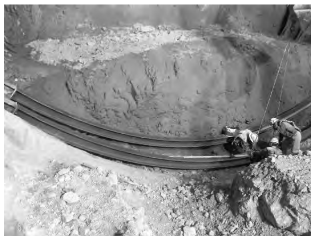
写真-2 インバート支保工接合状況
