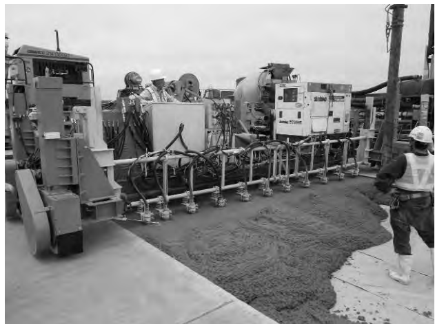
写真-9 施工状況
