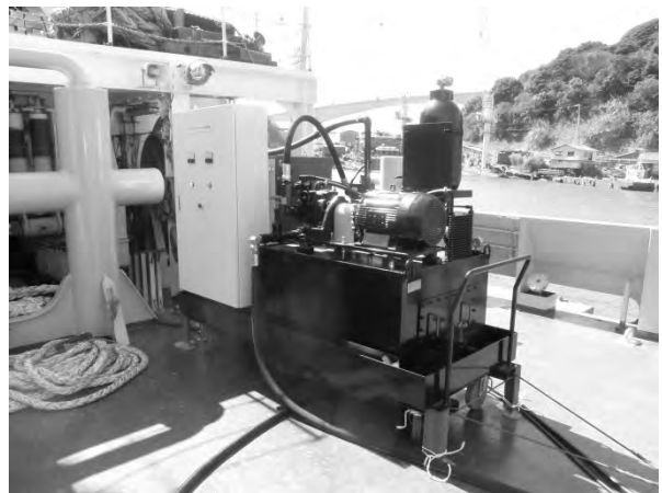
写真-5 油圧ユニット 艀装状況
