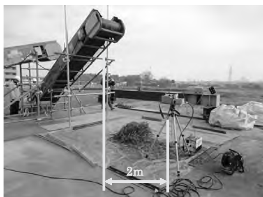
写真-6 粉じん濃度測定の様子
