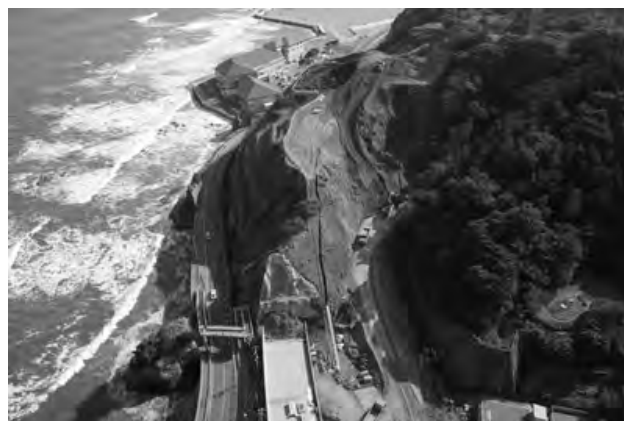
写真-1 施工管理の空撮写真例
