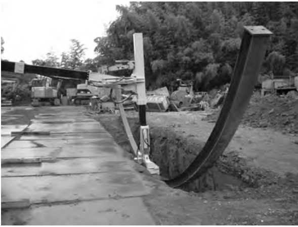
写真-4 アーム伸縮実験
