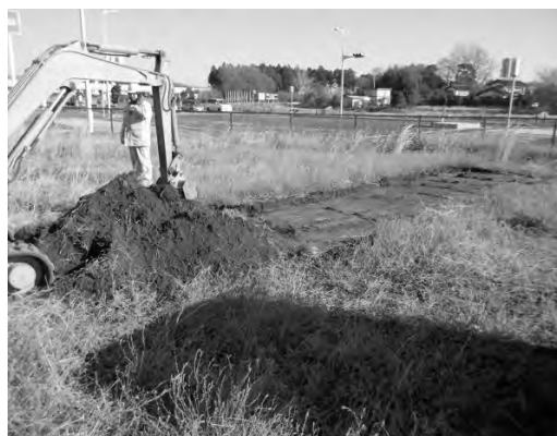
写真-3 模擬除去土壌の採取状況
