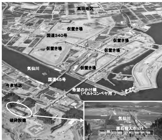
写真-1 破碎・搬送設備全景
