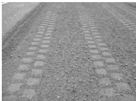
写真-10 敷きならし面におけるCTLのクローラ跡
