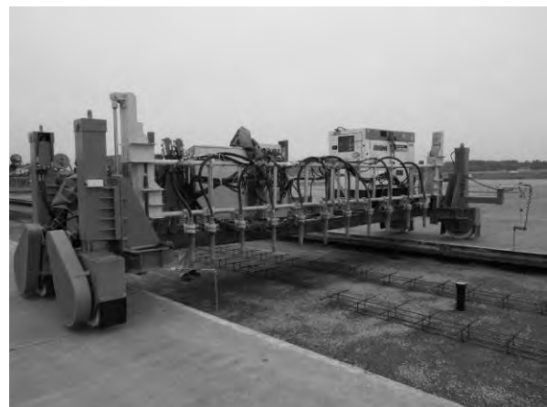
写真-7 オフレール式インナーバイブレータ
