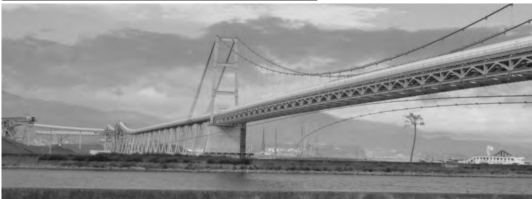
写真-4 ベルトコンベヤ用吊橋「希望のかけ橋」
