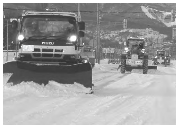
写真-1 雁行体制による除雪作業
