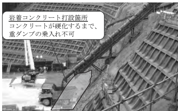
写真-2 SP-TOM 先端直下に重ダンプ配置(湯西川ダム)
