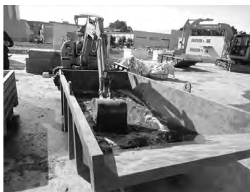
(a) 水槽へ投入した土壌をバックホウで攪拌
