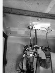
PC箱桁に発生した互板調査
