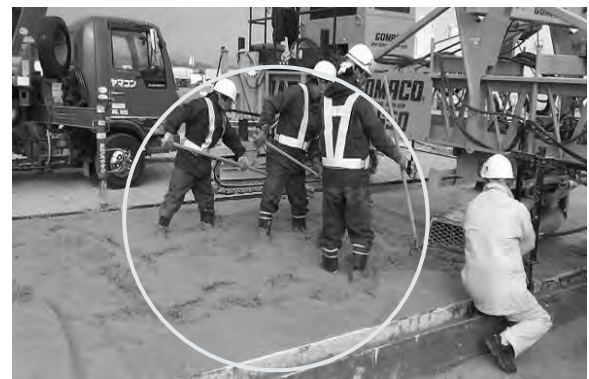
写真-5 施工状況②
