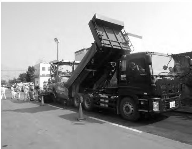
写真-1 オペレータによるダンプ誘導
