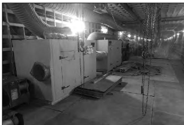
写真-9 排気浄化装置設置状況（マシン近傍）
