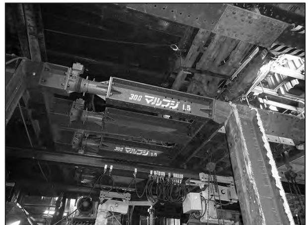
写真-7 推力伝達架台設置状況
