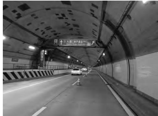
写真-10 天井板撤去完了
