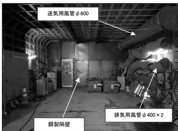
写真-8 鋼製隔壁設置状況（坑口付近）
