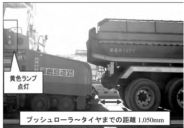
写真-7 黄色ランプ点灯時 (L2:2,000mm)
