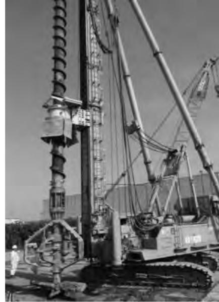
写真-3 スパイラルロッド(PIs工法)による試験施工全景
