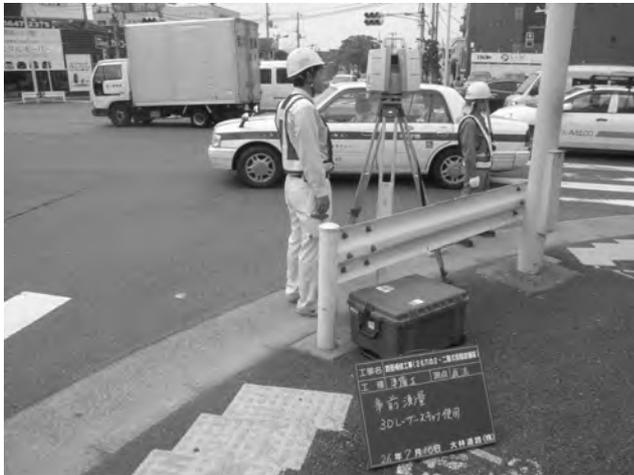
図-3 TLSによる既設路面計測状況
