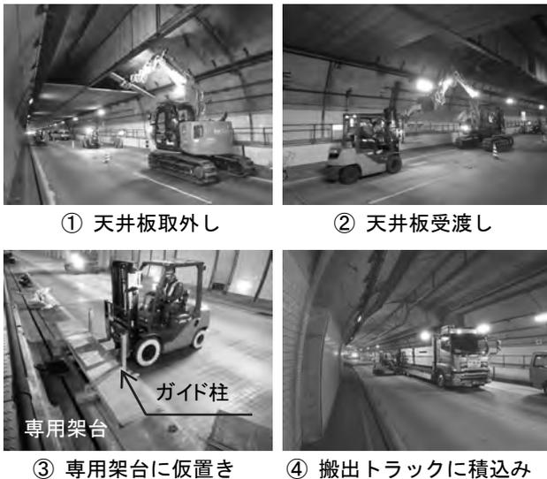
写真-6 天井板撤去作業の流れ
