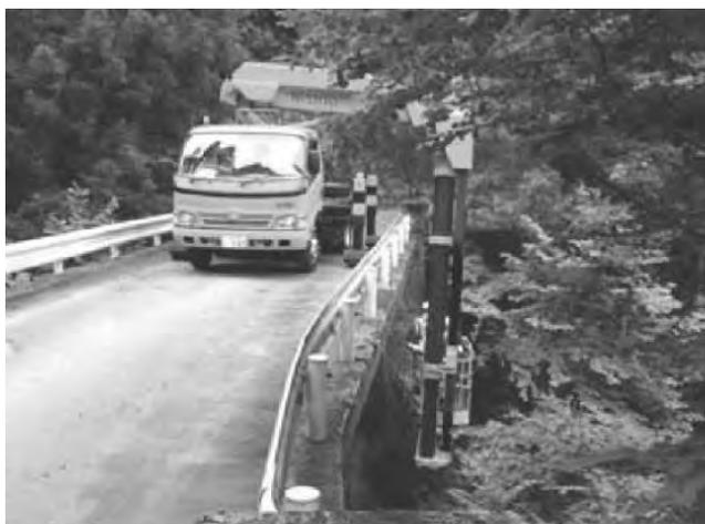
写真-1 橋梁点検車による作業状況
