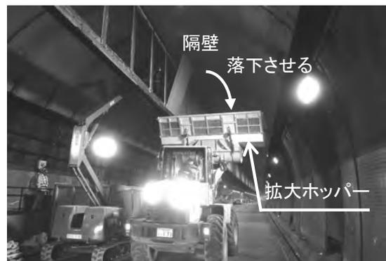
写真-7 隔壁撤去状況
