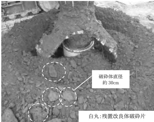
写真-2 残置改良体の破砕状況
