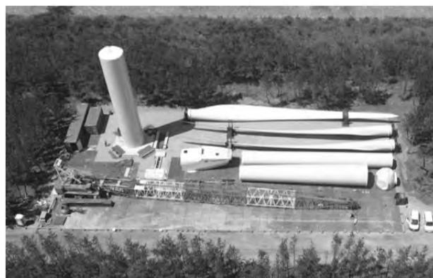
写真-3 風車部材仮置状況
