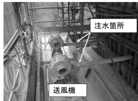
写真-3 送風設備設置状況
