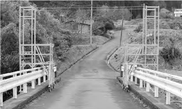
写真-5 路面占有面積の最小化
