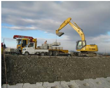
水平吊りによる玉掛け(荷卸し作業)
