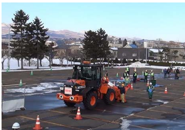
写真 10 競技者は除雪車の点検からスタート
