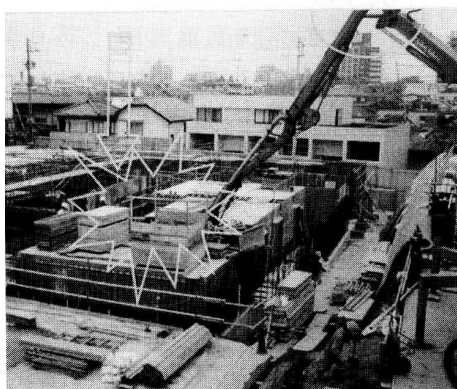
写真-1 A ブーム折損状況
