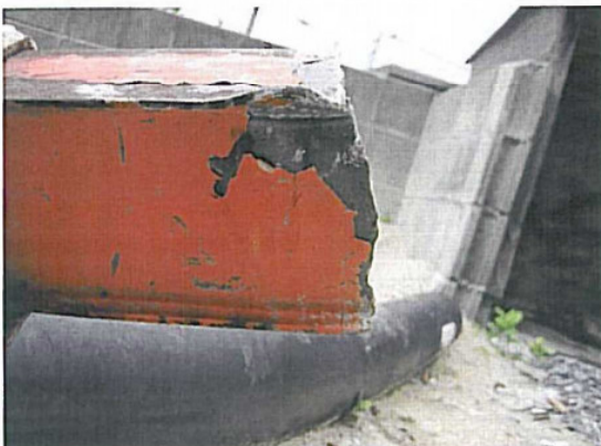
NO.47-ム根元側 (右側より見る)
