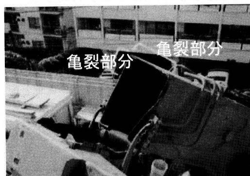
写真-1 B ブーム折損状況
