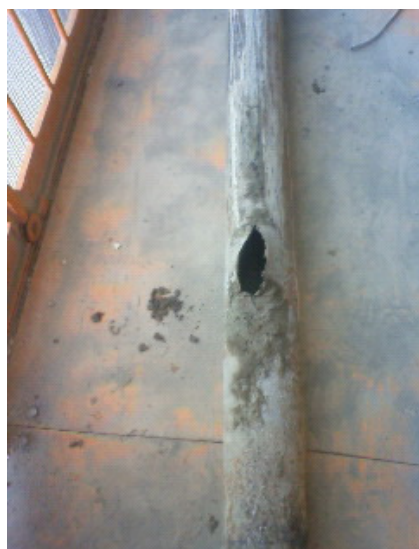
破裂した輸送管
