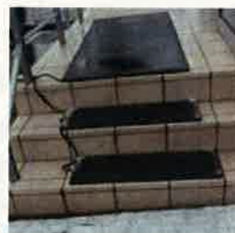
<ヒートマットの設置例>
