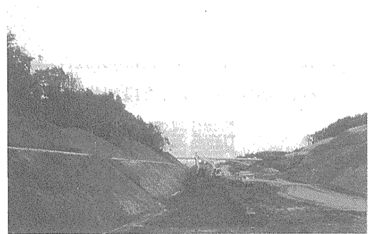
・完成した地盤改良工事
