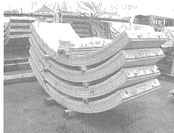
写真-1 セグメント仮置き
