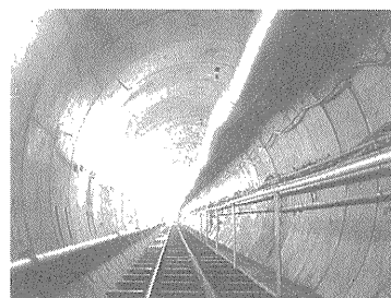
写真-3 坑内全景
