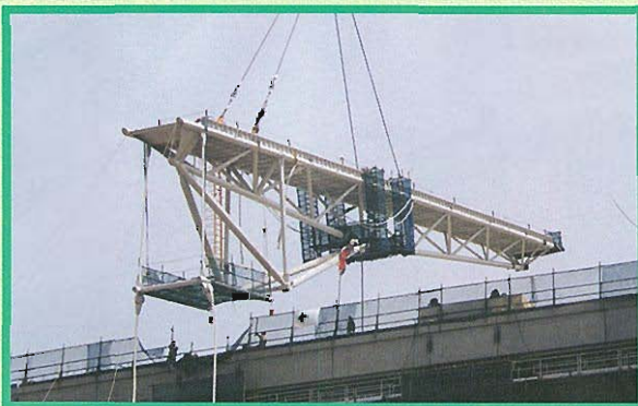
↑スタンド屋根トラスの建方状況
