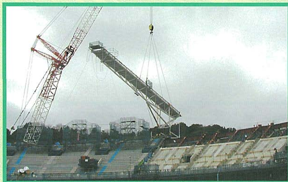
↑スタンド屋根の建方状況
