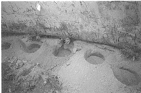
写真—3 刃口掘削状況
