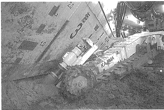
写真—2 刃口掘削装置掘削状況
