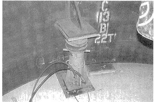
写真—4 建入れ調整ジャッキ
