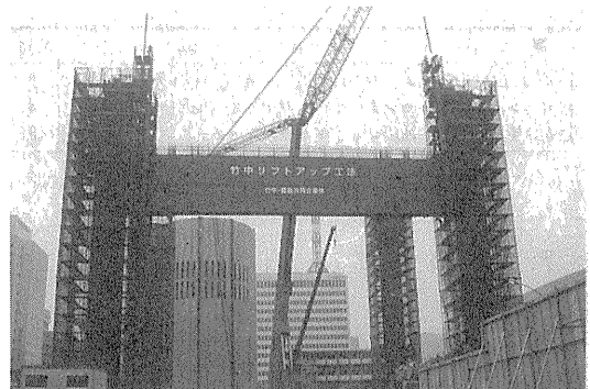
(第1回リフトアップ状況)
