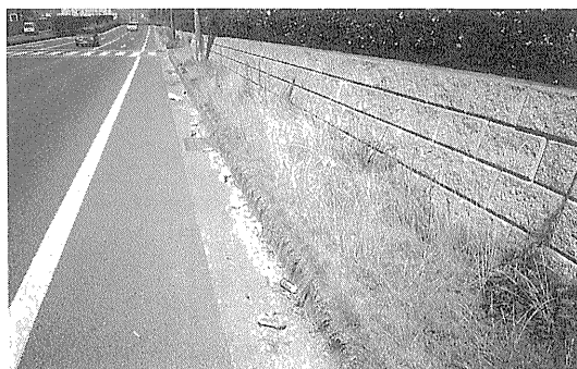
写真-2 路面清掃を待つ路面
