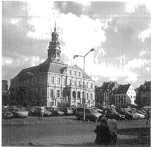
写真-2 マーストリヒト市庁舎
