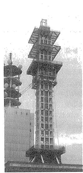
写真-2 プラットフォーム施工状況
