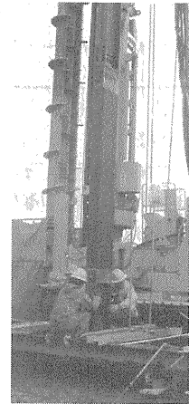
写真—2 ボルトジョイント
