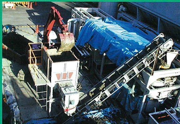
↑固形物を用いた安定液製造状況
