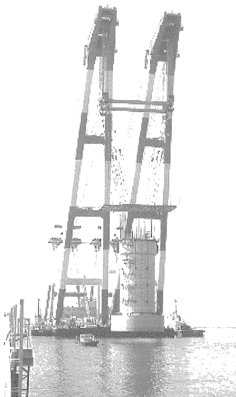
写真-1 据付け中の防衛工 (大阪府土地開発公社提供)
