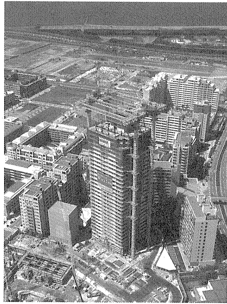
写真—3 最終状況(P1階コアウォール・31階床施工中)
