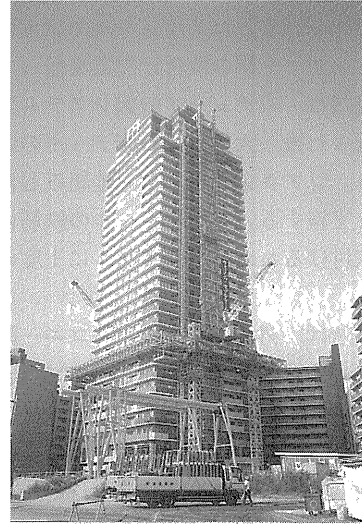
写真-6 迫下げ・マスト及び水平ステー解体(2)
