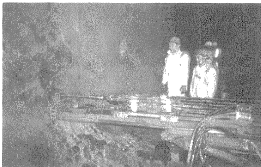
写真-1 切羽前方探査状況
