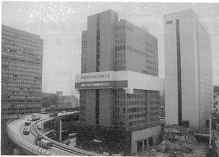
写真一1 工事状況 (MOVE HAT の上昇)
