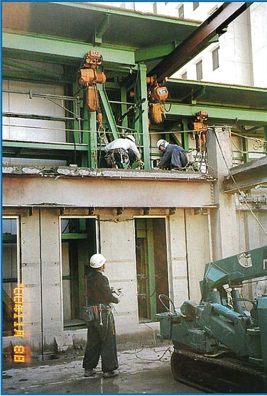
⇩ 外装PC版取り外し作業状況
