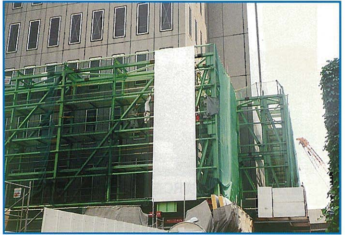
⇩ 鉄骨フレーム組立および防音パネル張状況
